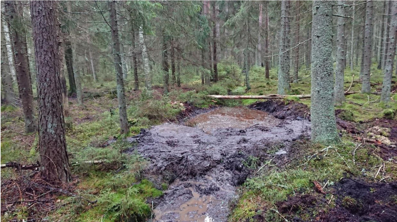
Kuva 10. Esimerkki pienestä kaivinkoneella tehdystä padosta ojassa, jossa ei ole penkkamaita täyttöön. Yleensä padosta kannattaa varmuuden vuoksi tehdä tätä suurempi.
