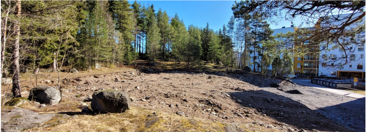
Kuva 5 Suunnittelualueelta on purettu kirjastorakennus ja tontti on tyhjä.
