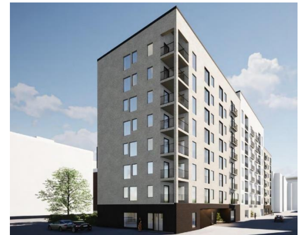
Kuva 1: kuva nykyisestä (yllä) ja havainnekuva uudisrakennuksesta (alla)
