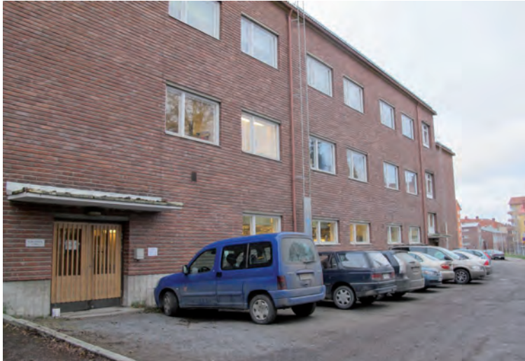
Kalevan lastentalo Väinölänkadun suuntaan. Kuva SHi.
