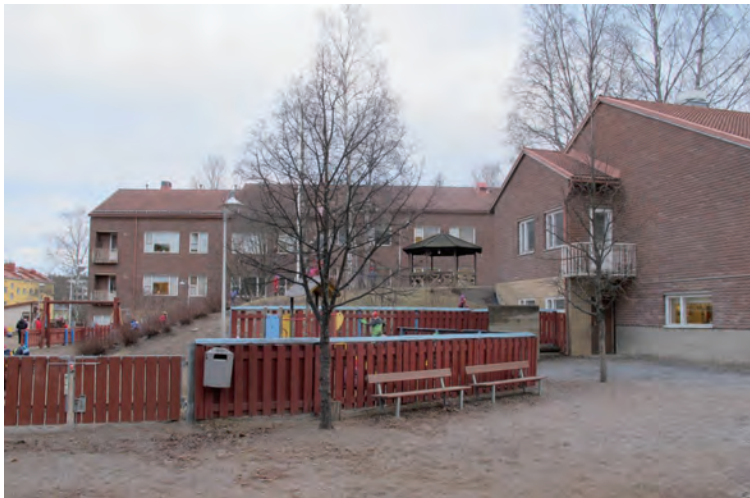
Piha-alue. Ilmarin päiväkodin ja Kalevan päiväkodin piha-alueet on erotettu aidalla toisistaan. Kuva SHi.
