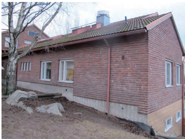
Ilmarin päiväkodin länsipääty. Tiilikatto on sammaloitunut. Kuva SHi.
