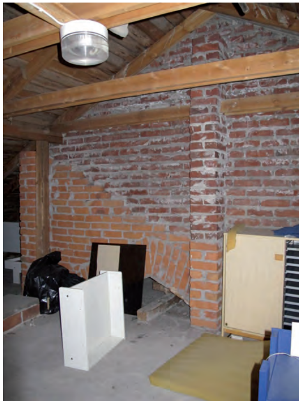
Väinöläkadun puoleisen siiven korkea ullakko. Kattorakenteet ovat terveet. Kuva SHi.
