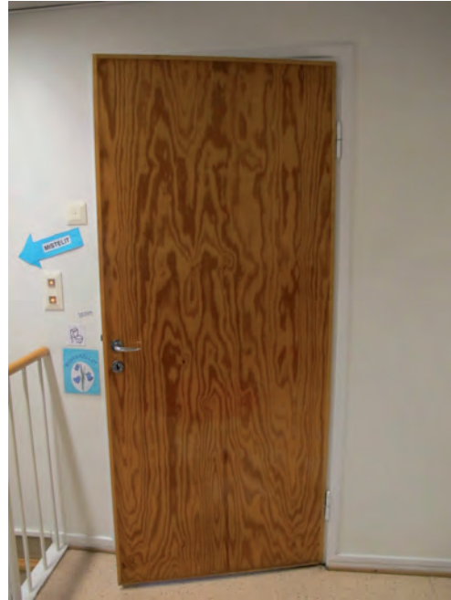
Alkuperäinen lakattu mäntyvanerilaakaovi.
