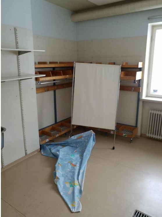
Näyte 24. tilan 139 seinätaipetti → ei sisällä asbestia.
