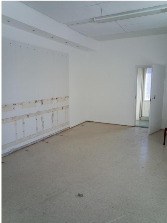
Yleiskuva tilasta 101. Uusitun pinnoitteen alla on asbestipitoista vanhaa pikiliimaa.
