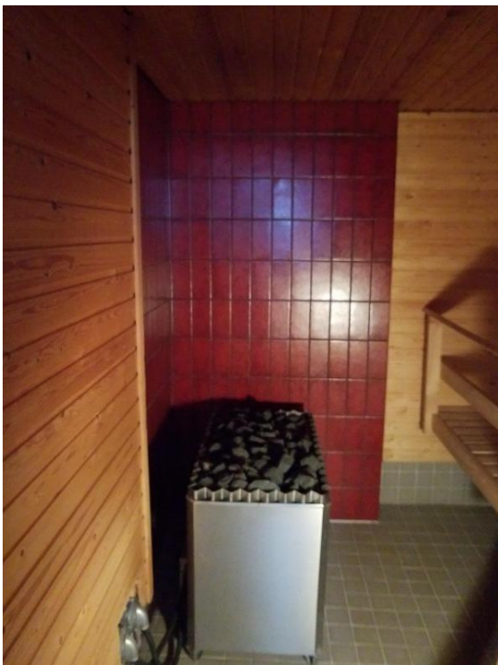
Näyte 22. saunan keraaminen laatoitus → ei sisällä asbestia.
