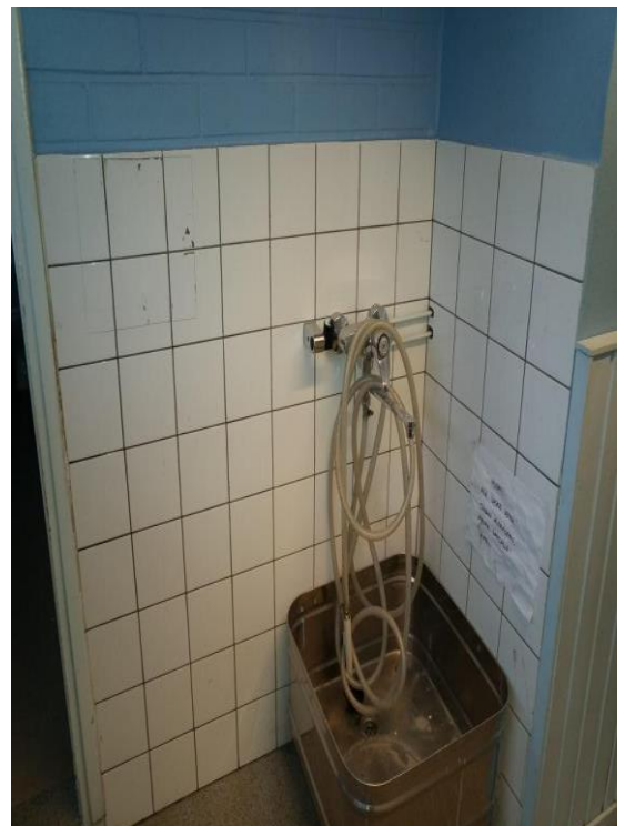
Näyte 23. tilan 051 keraaminen laatoitus → ei sisällä asbestia.
