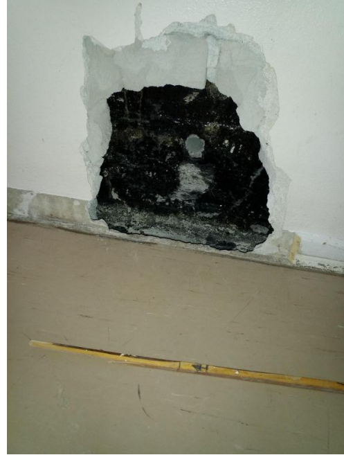
Tilan 053 ulkoseinän bitumisively.
