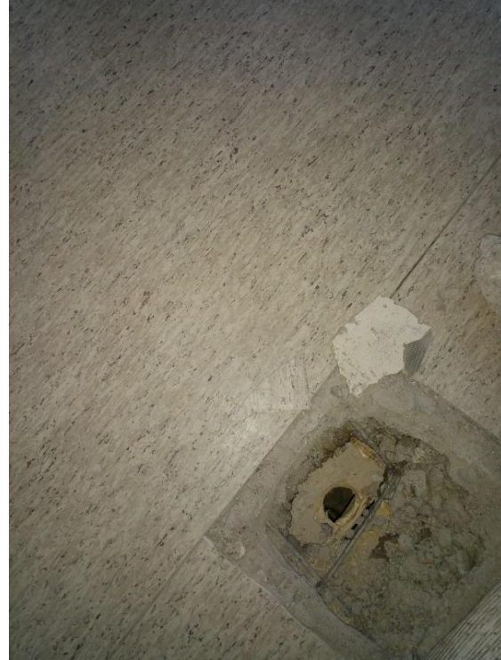
Näyte 16. muovimatto, liimat ja tasoitteet eivät sisällä asbestia.
