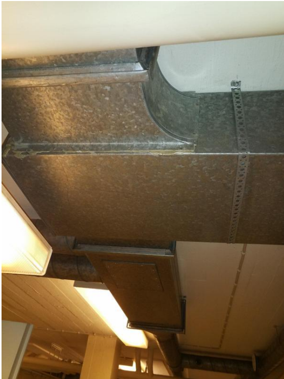
Näyte 20. IV-kanavan kitti → ei sisällä asbestia.
