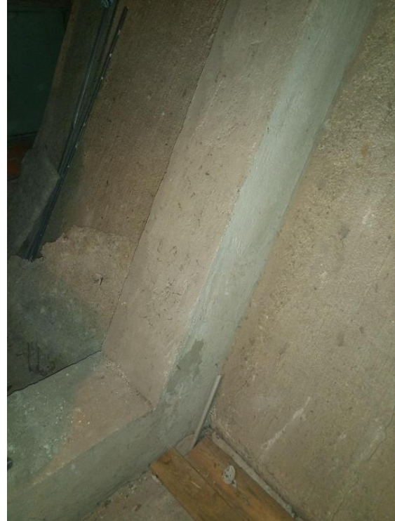
Näyte 25. yläpohjan IV-kanava → ei sisällä asbestia.
