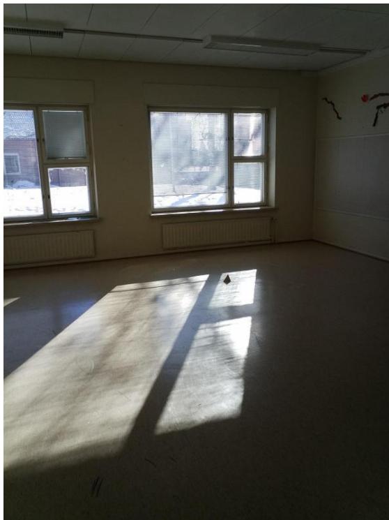
Yleiskuva tilasta 116. Uusitun pinnoitteen alla on asbestipitoista vanhaa pikiliimaa.
