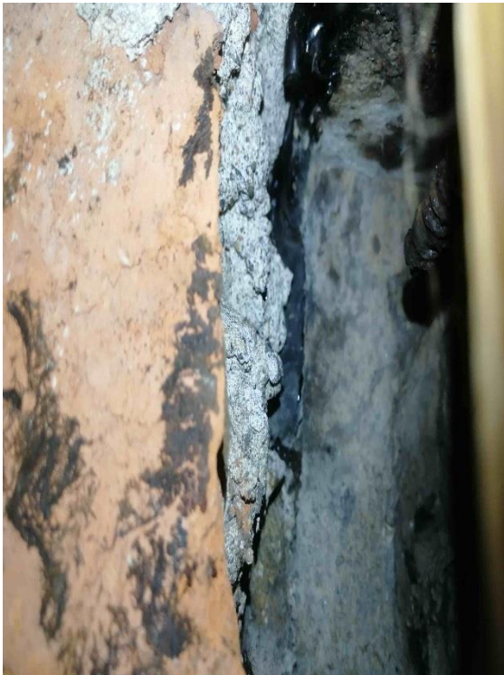
Näyte 2. vedeneristys sokkelista → ei sisällä asbestia ja PAH-yhdisteiden pitoisuus ei ylitä vaarallisen jätteen raja-arvoa.
