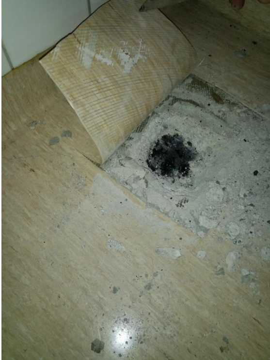
Näyte 15. märkätilan bitumisively → ei sisällä asbestia ja PAH-yhdisteiden pitoisuus ei ylitä vaarallisen jätteen raja-arvoa.
