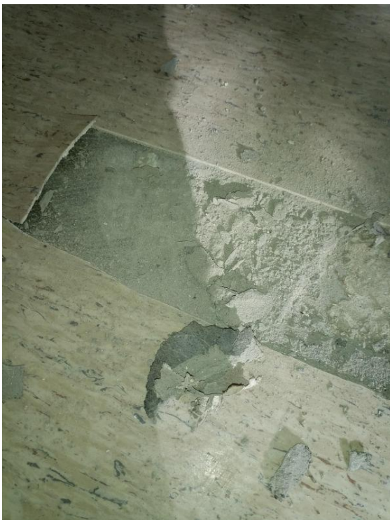
Näyte 17. lattian tasoitteet ja liima → ei sisällä asbestia.
