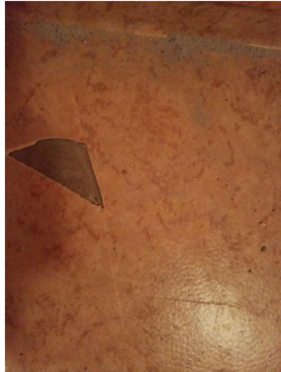
Näyte 21. pukuhuoneen 057 muovimatto ja liima → ei sisällä asbestia.
