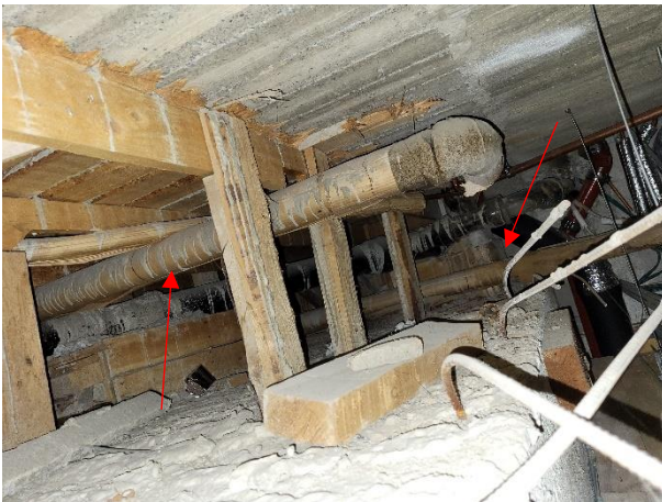
Kuvat 6a ja b. Käytävän 120A alakattotilan kautta pääsee näkemään väestönsuojan yläpuolisen ”ontelotilaan”, josta tukeutuu yläpuolella oleva välipohjarakenne. Rakenteen ”ontelotilassa” on talotekniikkaa. Vesi-/lämpöputket asbestieristeisiä.
