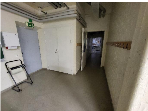
Kuvat 15a ja b. Yleiskuvaa palo-ovista. Ovia on eri aikakausilta ja todennäköisesti niiden eristeet ovat asbestipitoisia. Asbestia on käytetty palo-ovissa jopa 1990-luvulle asti.
