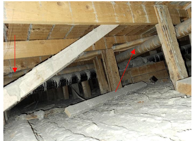
Kuvat 6a ja b. Käytävän 120A alakattotilan kautta pääsee näkemään väestönsuojan yläpuolisen ”ontelotilaan”, josta tukeutuu yläpuolella oleva välipohjarakenne. Rakenteen ”ontelotilassa” on talotekniikkaa. Vesi-/lämpöputket asbestieristeisiä.
