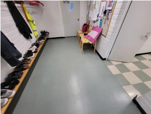
Kuvat 3a ja b. Yleiskuvia 300 x 300 mm 2 vinyylilaatoista, jotka sisältävät asbestia. Vinyylilaattojen alla jäämiä aiemmista Finnflex-laatoista ja niiden liimoista.
