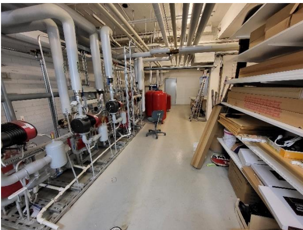
Kuvat 4a ja b. Lämmönjakohuoneen lattiamaalissa todettiin asbestia, joka on lajiltaan Amosiittia. Em. asbestilajia on käytetty yleensä putkieristeissä ja lämmitysjärjestelmissä, mikä mahdollisesti viittaa siihen, että talotekniikan peruskorjauksessa uuden lattiamaalikerroksen alle on jäänyt putkieristepurkujen yhteydessä asbestikuituja.
