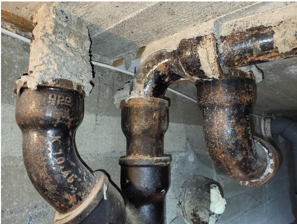
Kuvat 14a ja b. Putkikanaalissa havaittuja valurautaviemäreitä, joiden muhviitoksissa lyijyjuotos.
