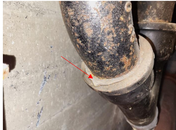
Kuvat 14a ja b. Putkikanaalissa havaittuja valurautaviemäreitä, joiden muhviitoksissa lyijyjuotos.
