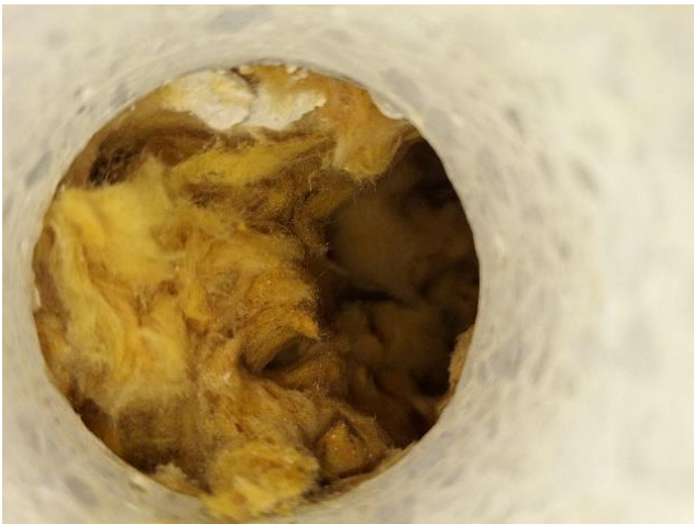
Kuvat 15 a ja b. Betonieriöavaus BET11 laajennusosan julkisivuun.
