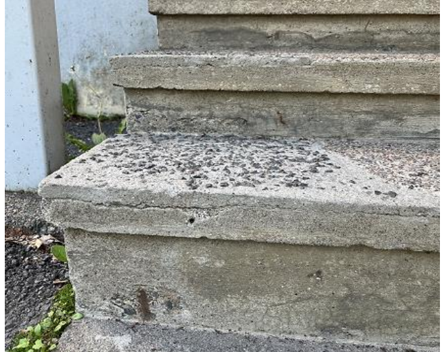
Kuvat 41 a ja b. Alkuperäisosan sisäänkäyntien porrasaskelmien betonirakenteissa havaittiin halkeilua ja terästen korroosiovaurioita.
