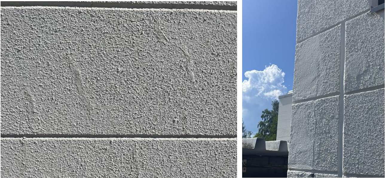
Kuvat 34 a ja b. Vanhempia vaurioita ja halkeamia on paikattu.
