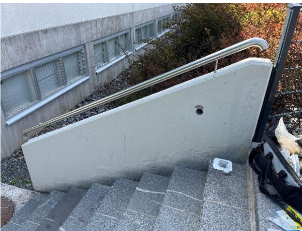
Kuvat 12 a-d. Kuvat a, b) Betonilieriöavaus BET14 alkuperäisosan betonikaiteeseen. Kuvat c, d) Betonilieriöavaus BET13 laajennuksen betoniseen porraskaiteeseen. Porauksessa havaittiin suunnitelmien mukainen \varnothing 8 mm raudoitusteräs n. 85 mm syvyydellä ulkopinnasta.
