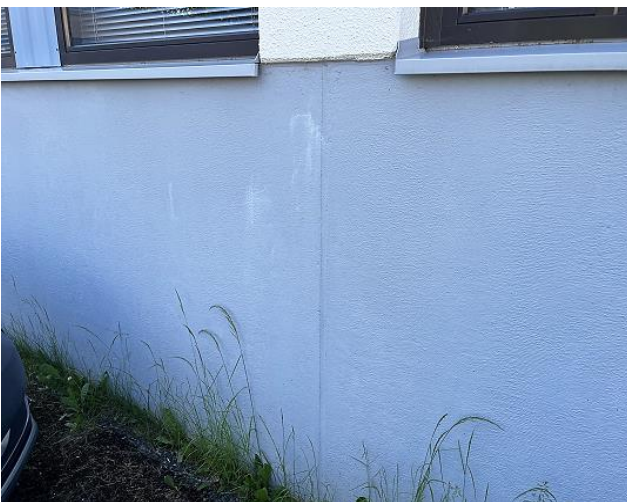
Kuvat 37 a ja b. Alkuperäisosan sokkelit ovat yleisesti hyväkuntoisia ja niissä havaittiin vain yksittäisiä halkeamia ja maalipinnoitevaurioita.
