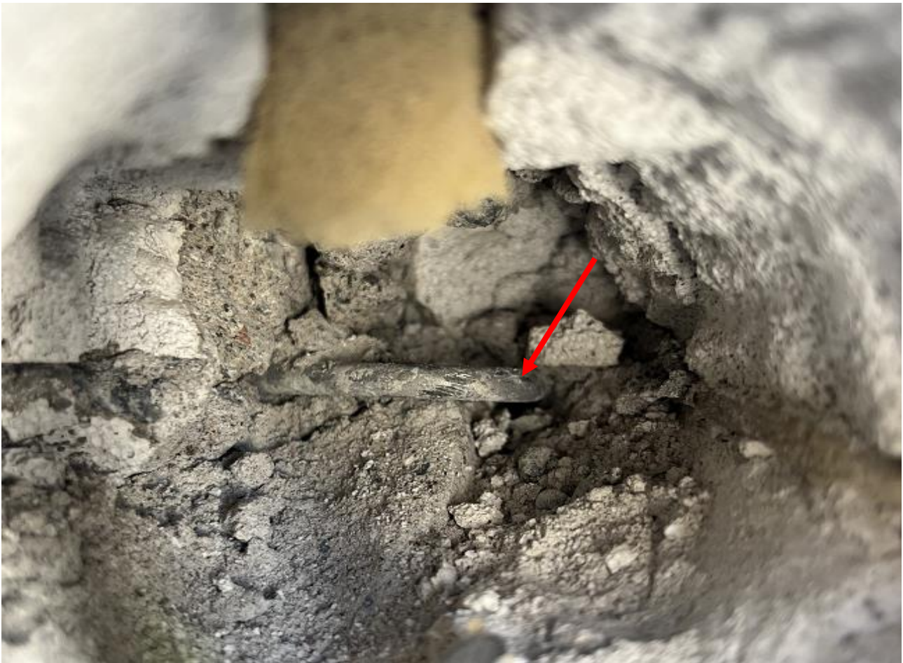
Kuva 19. Rakenneavaus RA2 kevytbetonilankkujen välisen pystysauman kohdalle. Rakenneavauksessa havaittiin suunnitelmien mukainen ruostumaton sidontalenkki sileästä teräksestä (~Ø 5 mm). Saumassa on suunnitelmien mukainen betonivalu, mutta sen sisällä ei havaittu pystyterästä. Elementtisaumassa on alkuperäinen vaahtomuovinauha. Rakenneavauksesta otettiin kevytbetonin kloridinäyte.
