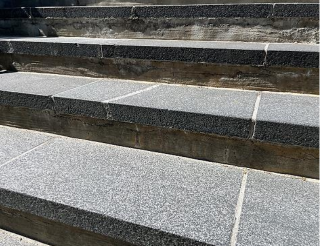
Kuvat 43 a ja b. Laajennusosan pohjoispäädyn ulkoportaiden kiviaskelmat ovat hyväkuntoisia. Porrasaskelmien välisissä betonirakenteissa esiintyy jonkin verran halkeilua. Portaat on todennäköisesti uusittu v. 2019 rakennesuunnitelmien (Sweco) mukaisesti.
