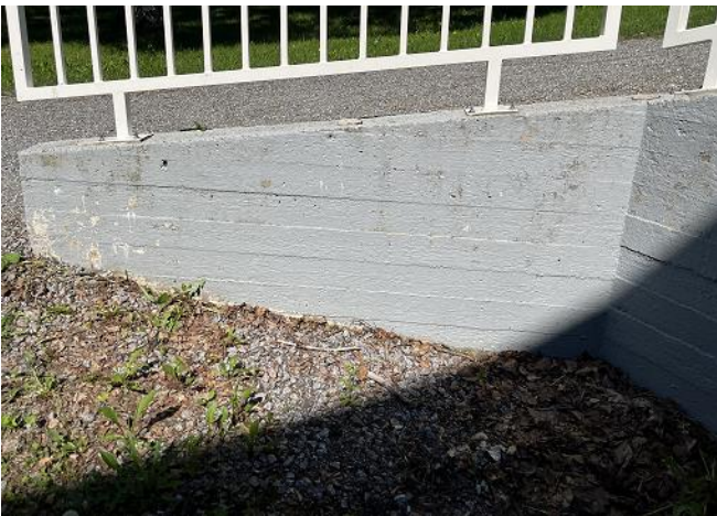
Kuvat 39 a ja b. Juvankadun puoleinen tukimuri alkuperäisosalla. Muurissa havaittiin maalin hilseilyä.
