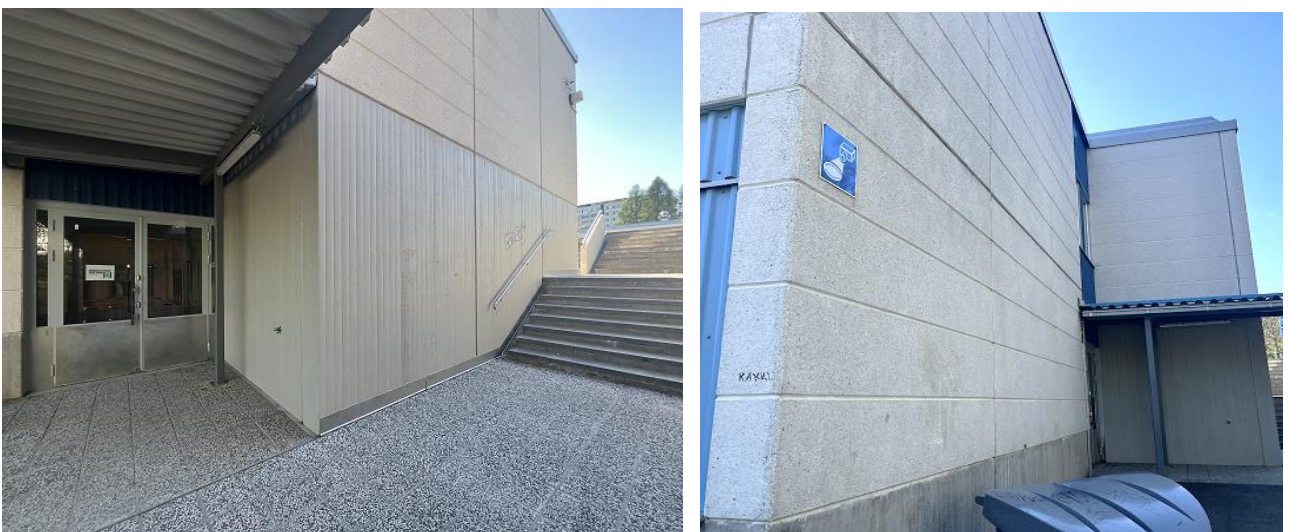
Kuvat 30 a ja b. Laajennuksen julkisivu pohjoiseen.
