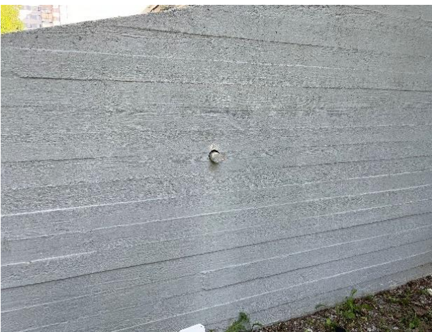
Kuvat 13 a ja b. Betonilieriöavaus BET15 alkuperäisosan tukimuriin. Porauksessa havaittiin suunnitelmien mukainen \varnothing 8 mm raudoitusteräs 25 mm syvyydellä ulkopinnasta.
