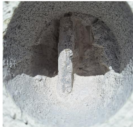
Kuvat 23 a-c. Rakennus RA7 kevytbetonilankun raudoituksen paikantamiseksi. Rakennuksessa havaittiin betonivalujen sisällä pysty- ja vaakasuuntaiset harjateräket noin 45 mm syvyydellä pinnasta.
