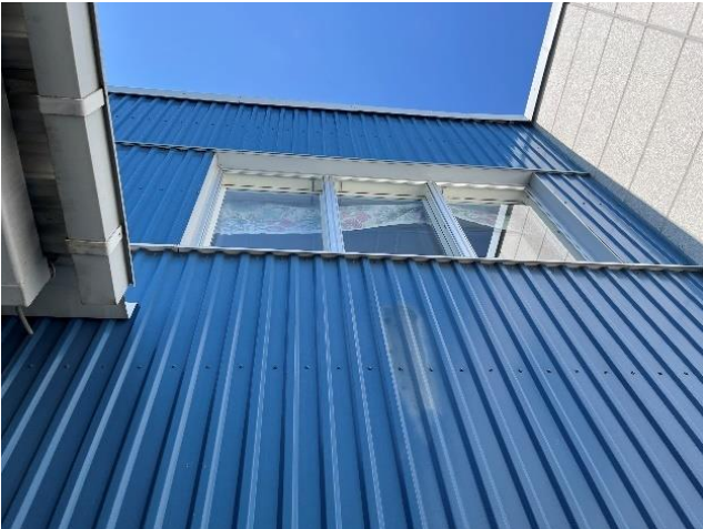
Kuvat 16 a ja b. Rakenneavaus RA8 rakennuksen peltiverhottuun julkisivuun.
