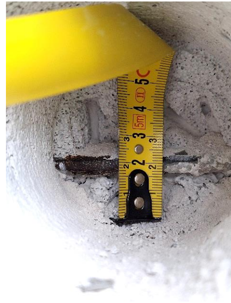
Kuvat 22 a ja b. Rakennus RA6 kevytbetonilankun raudoituksen paikantamiseksi. Rakennuksessa havaittiin betonivalun sisällä raudoitustanko (Ø 6 mm) noin syvyydellä 115 mm ulkopinnasta ja noin 60 mm kevytbetonilankun alareunasta. Teräksen pinnalla havaittiin korroosiota.
