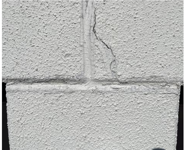
Kuvat 32 a ja b. Tyypillinen vauriokohta ikkunoiden ympäristössä, joissa kevytbetonielementtien päihin on syntynyt syviä halkeamia.
