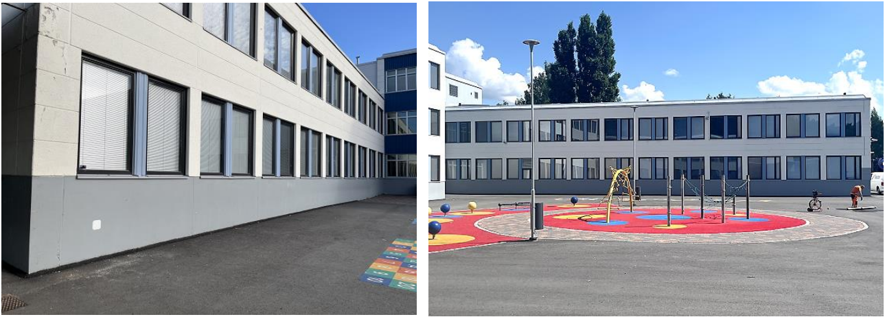
Kuvat 28 a ja b. Kuva a: Pihajulkisivu itään. Kuva b: Pihajulkisivu länteen.
