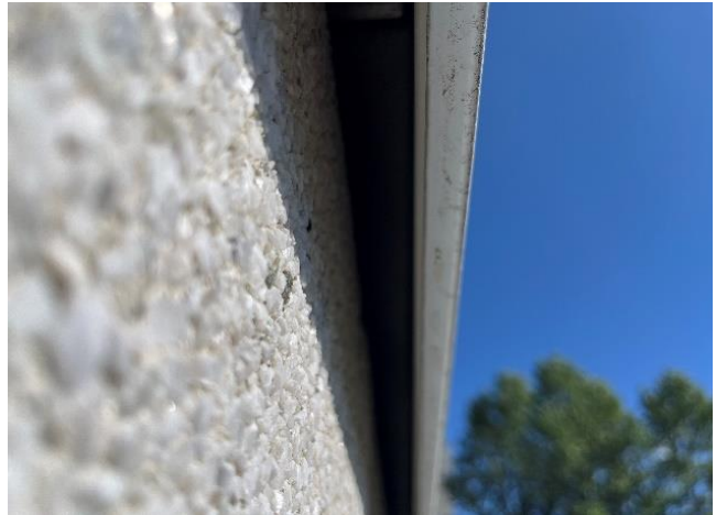
Kuvat 38 a ja b. Alkuperäisosan räystäältä puuttuu myrsky-/vastapellit, yläpohjaan on paikoin useampien senttimetrien rako.
