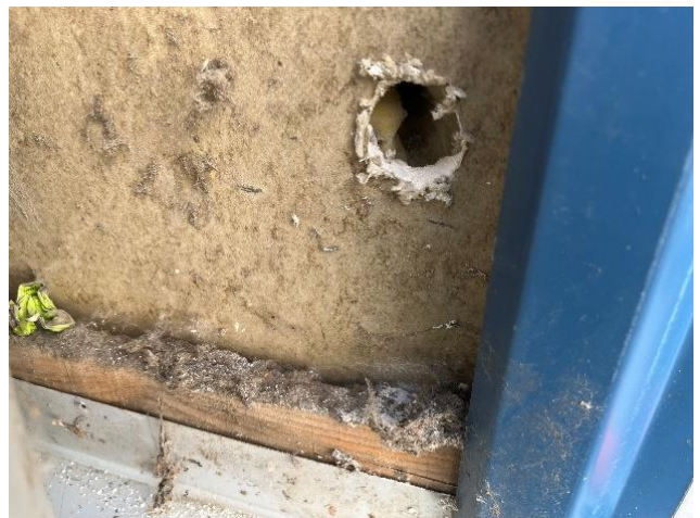
Kuvat 16 a ja b. Rakenneavaus RA8 rakennuksen peltiverhottuun julkisivuun.
