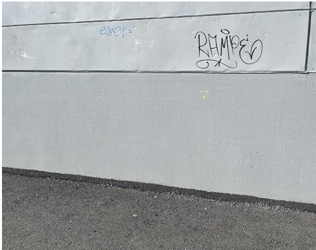
Kuvat 37 a ja b. Alkuperäisosan sokkelit ovat yleisesti hyväkuntoisia ja niissä havaittiin vain yksittäisiä halkeamia ja maalipinnoitevaurioita.
