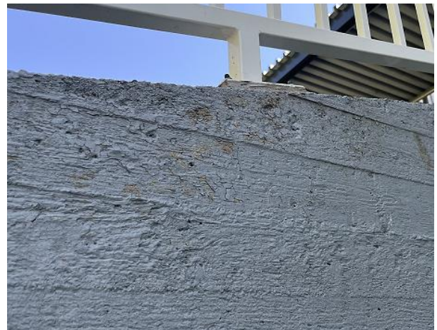
Kuvat 39 a ja b. Juvankadun puoleinen tukimuri alkuperäisosalla. Muurissa havaittiin maalin hilseilyä.
