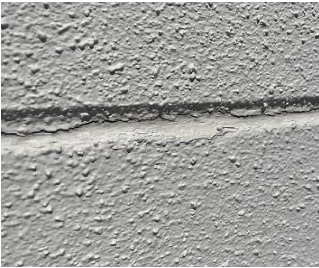
Kuvat 35 a ja b. Kevytbetonielementtien elastisissa saumauksissa esiintyy halkeilua ja irtoamista vastepinnoilta.
