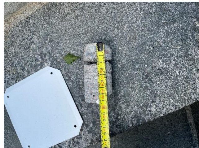
Kuvat 12 a-d. Kuvat a, b) Betonilieriöavaus BET14 alkuperäisosan betonikaiteeseen. Kuvat c, d) Betonilieriöavaus BET13 laajennuksen betoniseen porraskaiteeseen. Porauksessa havaittiin suunnitelmien mukainen \varnothing 8 mm raudoitusteräs n. 85 mm syvyydellä ulkopinnasta.
