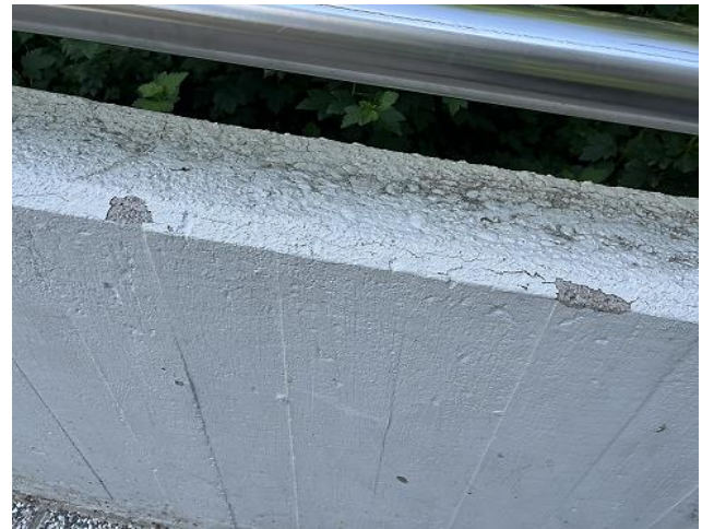
Kuvat 42 a ja b. Laajennusosan pohjoispäädyn ulkoportaiden betonikaiteissa havaittiin yksittäistä maalin hilseilyä.
