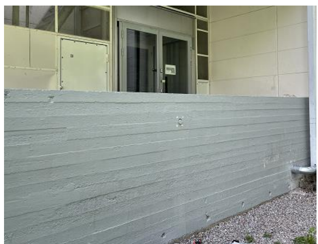
Kuvat 40 a ja b. Juvankadun puoleisen sisäänkäynnin betonikaide alkuperäisosalla. Kai-teessa ei havaittu vaurioita.
