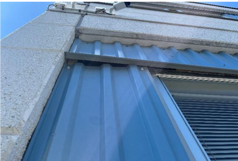
Kuvat 17 a ja b. Rakenneavaus RA9 rakennuksen julkisivun peltiverhottuun osaan.
