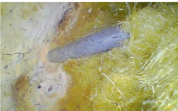
Kuva 11. Ansa ruostumattomasta teräksestä sokkelielementin eristekerroksessa, rakenneavaus BET3.
