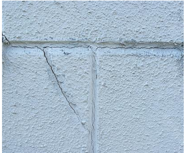
Kuvat 35 a ja b. Kevytbetonielementtien elastisissa saumauksissa esiintyy halkeilua ja irtoamista vastepinnoilta.
