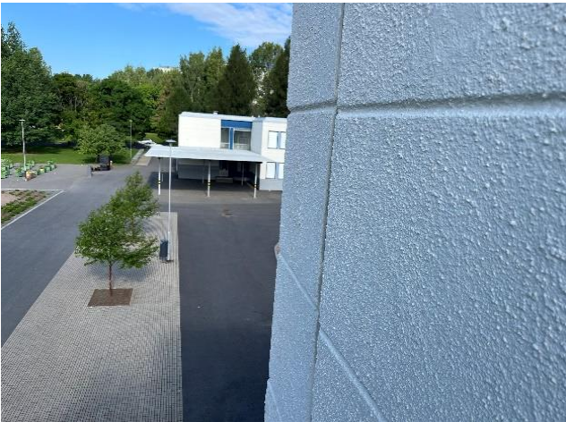
Kuvat 36 a ja b. Yksittäisissä kevytbetonilankkukaistoissa havaittiin vierekkäisten lankkujen välillä hammastusta.
