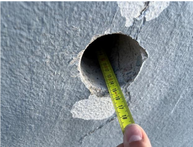
Kuvat 10 a-d. Betonilieriöavaus BET4 sokkelielementtiin halkeaman kohdalle. Lämmöneristeenä 80 mm mineraalivilla ja ulkokuoren paksuus 70 mm. Ulkokuoressa on kuoren läpi ulottuva halkeama.
