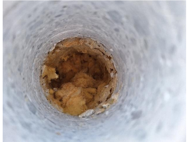
Kuvat 14 a ja b. Betonieriöavaus BET9 laajennusosan sokkeliin.
