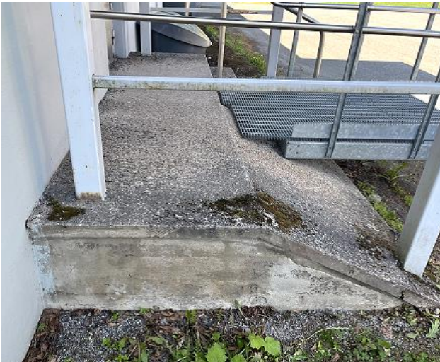
Kuvat 41 a ja b. Alkuperäisosan sisäänkäyntien porrasaskelmien betonirakenteissa havaittiin halkeilua ja terästen korroosiovaurioita.
