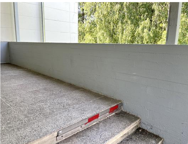
Kuvat 40 a ja b. Juvankadun puoleisen sisäänkäynnin betonikaide alkuperäisosalla. Kai-teessa ei havaittu vaurioita.
