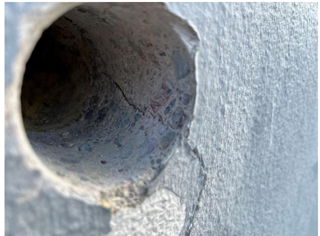
Kuvat 10 a-d. Betonilieriöavaus BET4 sokkelielementtiin halkeaman kohdalle. Lämmöneristeenä 80 mm mineraalivilla ja ulkokuoren paksuus 70 mm. Ulkokuoressa on kuoren läpi ulottuva halkeama.
