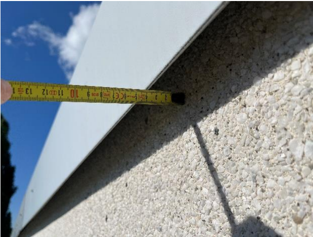
Kuvat 38 a ja b. Alkuperäisosan räystäältä puuttuu myrsky-/vastapellit, yläpohjaan on paikoin useampien senttimetrien rako.
