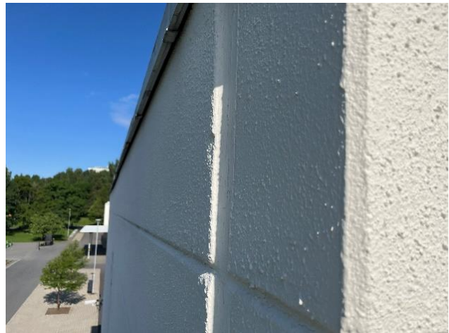
Kuvat 36 a ja b. Yksittäisissä kevytbetonilankkukaistoissa havaittiin vierekkäisten lankkujen välillä hammastusta.
