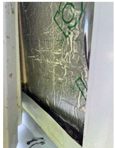
Kuvat 17 a ja b. Rakenneavaus RA9 rakennuksen julkisivun peltiverhottuun osaan.
