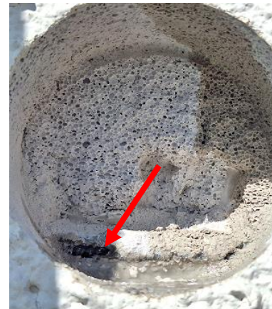
Kuvat 23 a-c. Rakennus RA7 kevytbetonilankun raudoituksen paikantamiseksi. Rakennuksessa havaittiin betonivalujen sisällä pysty- ja vaakasuuntaiset harjateräket noin 45 mm syvyydellä pinnasta.
