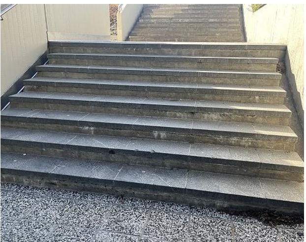
Kuvat 43 a ja b. Laajennusosan pohjoispäädyn ulkoportaiden kiviaskelmat ovat hyväkuntoisia. Porrasaskelmien välisissä betonirakenteissa esiintyy jonkin verran halkeilua. Portaat on todennäköisesti uusittu v. 2019 rakennesuunnitelmien (Sweco) mukaisesti.
