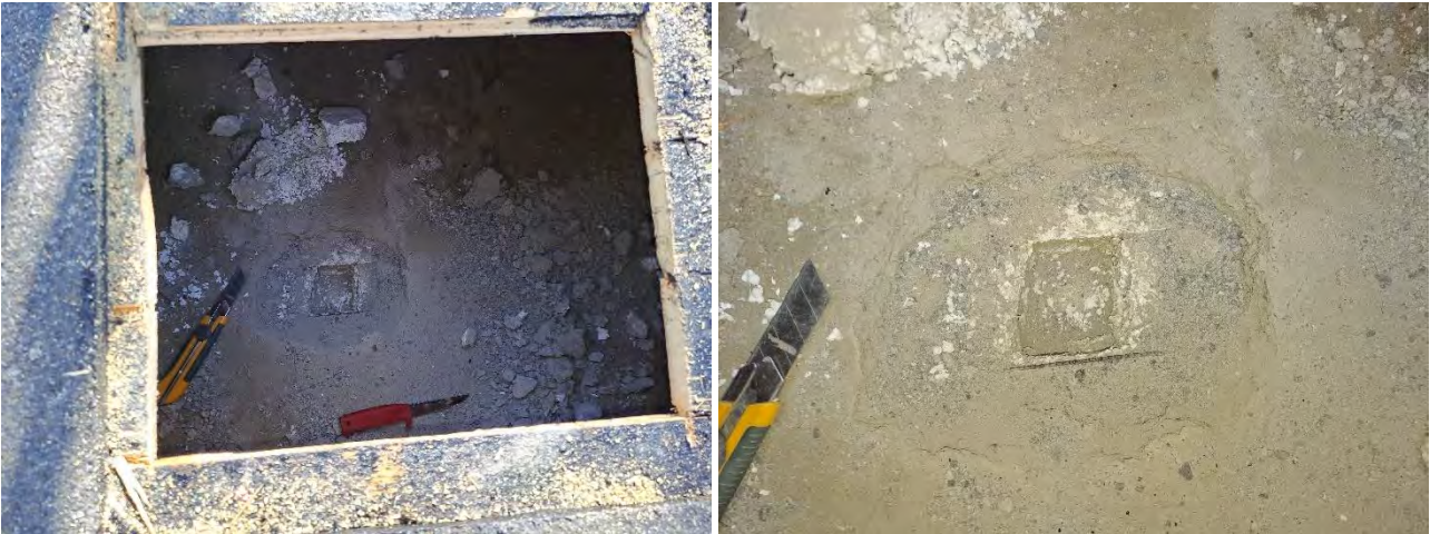
Kuva 50 a-b. a) Yleiskuva rakenneavauksesta RA-YP4 D-osalla. b) A-, C-, ja D-osilla palolaatan (50 mm) alla 100 mm paksu EPS-lämmöneriste ja kantava yläpohjalaatta.
