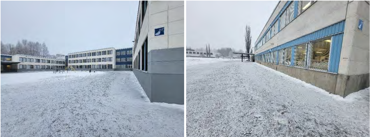
Kuvat 3 a-b. a) Yleiskuva rakennuksen eteläpuolelta. b) Yleiskuva rakennuksen itäsivustalta. Etualalla rakennuksen E-osa.
