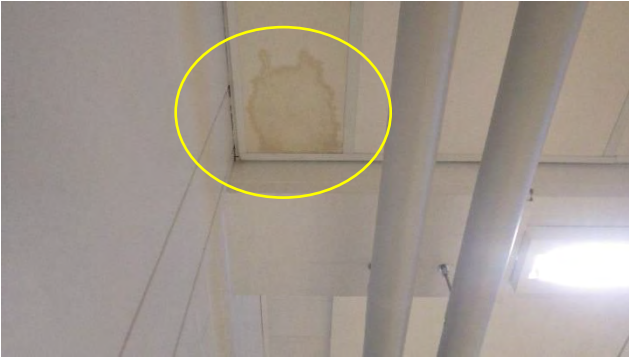
Kuvat 43 a-b. a) Vanha kosteusjälki tilan 138D katossa. b) Kosteusjäljen kohdalla on viemärin ja käyttövesien läpivienti. Ko. kohdassa ei tutkimusten aikana havaittu aktiivista vuotoa.
