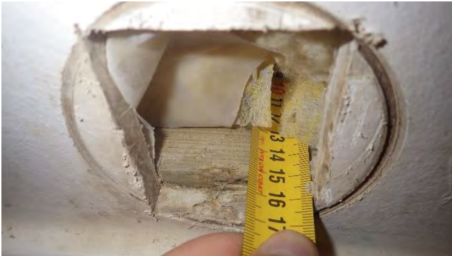
Kuva 64 a-b. a) Rakenneavaus RA-US15 tilan 126E ikkunoiden väliin. Mineraalivillasta otettiin materiaalinäyte M1. Laboratorioanalyysin perusteella materiaalissa esiintyy mikrobikasvustoa. b) Ulkoseinän leikkauskuva ikkunoiden välistä E-osan luokkatiloista.
