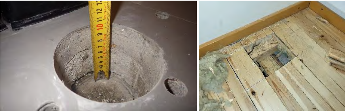
Kuvat 13 a-b. Rakenneavaus RA-AP2 tilan 132C kaksoislaattarakenteeseen. b) Rakenneavaus RA-AP8 puukäsityöluokan 209B alapohjaan.
