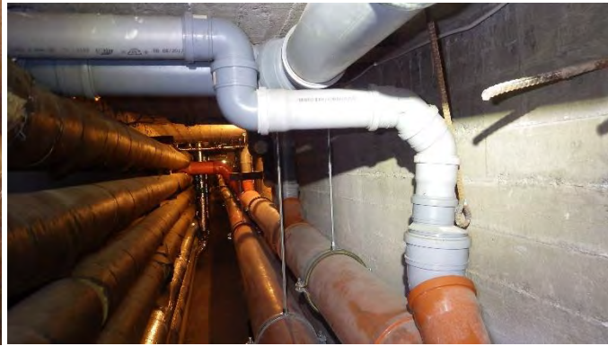
Kuvat 73 a-b. a) Yleiskuva putkitunnelista. Tunnelissa paikoin runsasta pölykertymää ja useita kuitulähteitä. b) Tunnelissa useampia puutteellisesti kannakoituja viemäriputkia.
