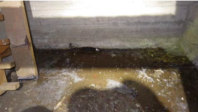
Kuvat 74 a-b. a) Tunnelin portaikon alla kaivo tulvii. b) Tunneli jatkuu itäpuolen aulasta E- ja D- osiin matalampana kanaalirakenteena. E- ja D- osan käytävillä on erilliset tarkastus-/huoltoluukut kanaaliin.
