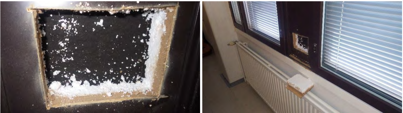
Kuva 63 a-b. a) Rakenneavaus RA-US11 tilan 244B ikkunoiden väliin. b) Yleiskuva rakenneavauksesta RA-US11.
