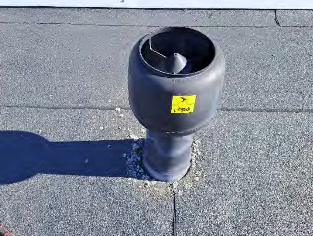
Kuvat 54 a-b. a) Alipainetuulettimien juurella on sammaloitumista. Vesi voi jäädä makamaan tuulettimien juurelle. b) Nostojen saumoissa on yksittäisiä mahdollisia epätiiviskoh- tia.
