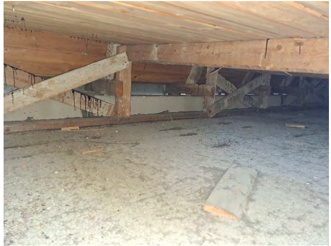
Kuvat 55 a-b. a) Alipainetuulettimien kohdalle on puhkaistu aukot aluslaudoitukseen. b) Rakenteet tuulettuvat alkuperäisosalla kuvan mukaisesti myös räystäiltä. Yläpohjatilassa on katupölykertymää.
