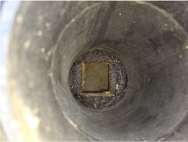
Kuvat 55 a-b. a) Alipainetuulettimien kohdalle on puhkaistu aukot aluslaudoitukseen. b) Rakenteet tuulettuvat alkuperäisosalla kuvan mukaisesti myös räystäiltä. Yläpohjatilassa on katupölykertymää.
