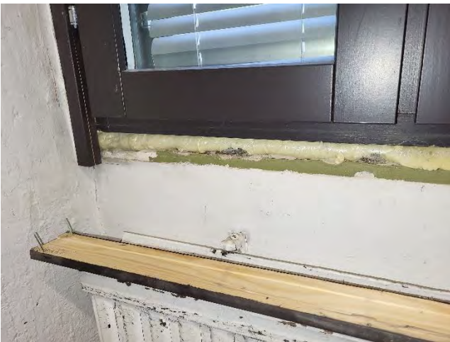
Kuvat 72 a-b. a) Tilan 294D ikkuna-seinäliittymä tiivistetty polyuretaanivaahdolla. b) Polyuretaanivaahdotuksen seassa on jäämiä vanhasta pellavariveestä. Pellavariveessä havaittiin aistinvaraisesti PAH-yhdisteisiin viittaava hajua.
