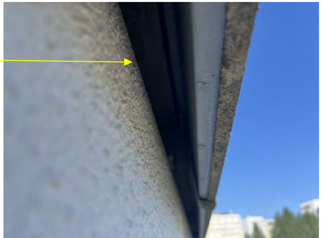
Kuva 56 a-b. a) Yleiskuva räystäsrakenteesta. b) Räystäillä on paikoin useamman senttimetrin rako, josta pienet linnut pääsevät yläpohjatilaan.
