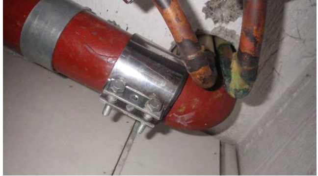
Kuvat 43 a-b. a) Vanha kosteusjälki tilan 138D katossa. b) Kosteusjäljen kohdalla on viemärin ja käyttövesien läpivienti. Ko. kohdassa ei tutkimusten aikana havaittu aktiivista vuotoa.
