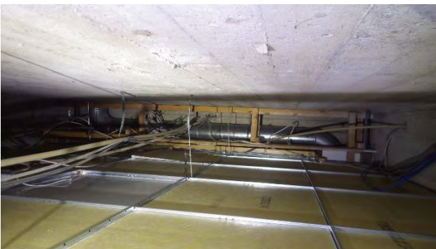
Kuvat 45 a-b. a) Yleiskuva porrassaulan 131E alakattotilasta, jossa mineraalivillapohjaiset alakattolevyt. b) Käytävän 132D alakattotilassa epätiivittä läpivientejä sekä runsaasti pölykertymää.
