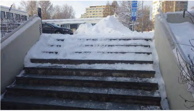
Kuva 9. E-osan päädyssä portaikon sulanapitokaapelit eivät toimi portaiden yläpäässä. Ylimmät rappuset ovat vaarallisen liukkaat talvikaudella.
