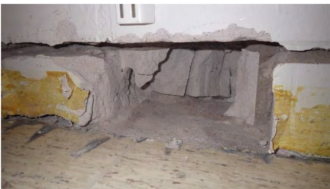
Kuva 39. Rakenneavaus RA-VS3 tilojen 115E ja 114Ea välisessä väliseinässä. Muurauksen lähtee suoraan betonilaatan päältä lattiapinnan tasosta.
