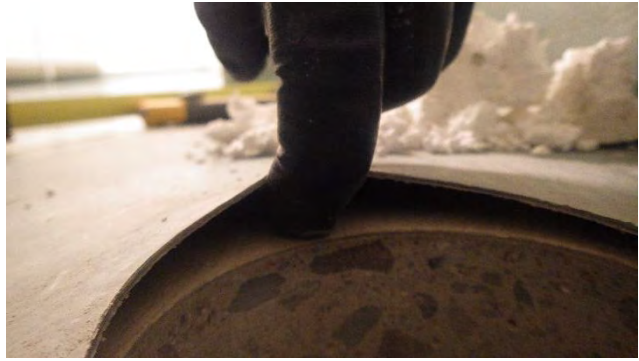
Kuvat 16 a-b. a) Tilassa 104Ea alapohjassa kohonneita havaittiin pintakosteusilmaisimen arvoja. b) Muovimatto irti alustastaan ja sen alta havaittiin poikkeavaa kemiallista hajua.
