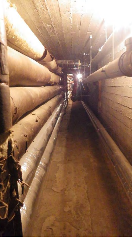
Kuvat 73 a-b. a) Yleiskuva putkitunnelista. Tunnelissa paikoin runsasta pölykertymää ja useita kuitulähteitä. b) Tunnelissa useampia puutteellisesti kannakoituja viemäriputkia.
