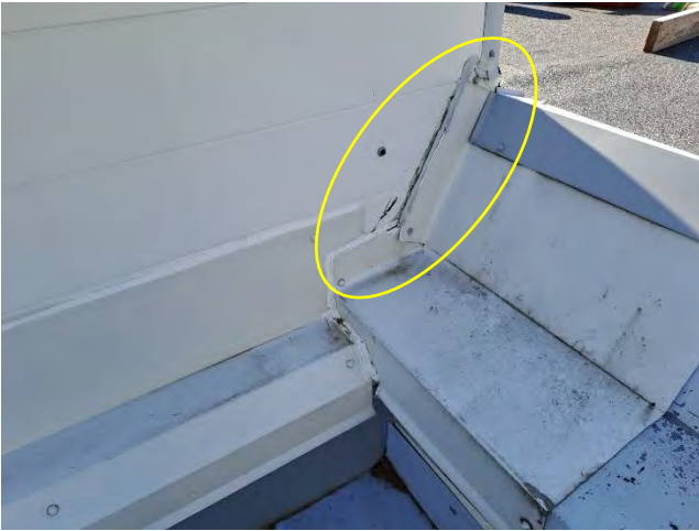
Kuvat 57 a-b. a) Länsipäädyssä IV-konehuoneen ja C-osan räystäspellityksen tiivistyksessä on puutteita. b) Räystäspellitysten saumakohtien tiivistykset ja maalipinnat ovat paikoin kuluneet.
