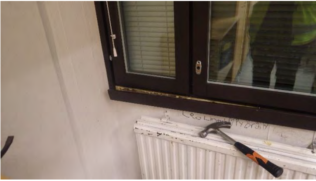
Kuva 71 a-b. a) Tilan 142D ikkunalistan avaus. b) Ikkuna-ulkoseinä liittymä tiivistetty polyuretaanivaahdolla.
