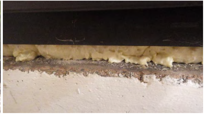
Kuva 71 a-b. a) Tilan 142D ikkunalistan avaus. b) Ikkuna-ulkoseinä liittymä tiivistetty polyuretaanivaahdolla.
