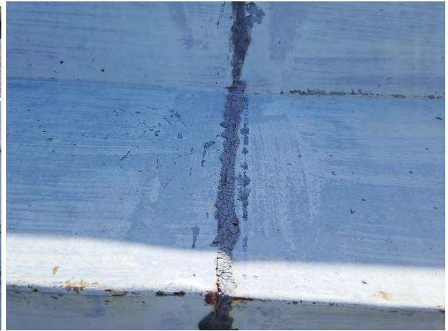
Kuvat 57 a-b. a) Länsipäädyssä IV-konehuoneen ja C-osan räystäspellityksen tiivistyksessä on puutteita. b) Räystäspellitysten saumakohtien tiivistykset ja maalipinnat ovat paikoin kuluneet.
