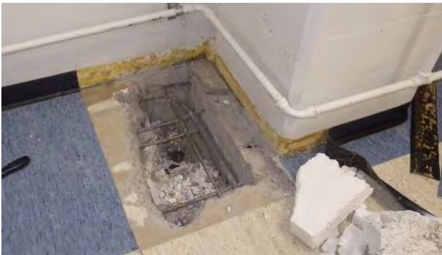
Kuvat 15 a-b. a) Rakenneavaus RA-AP10 tilassa 126E. Alapohjalaatta noin 130 mm ja EPS 100 mm b) Rakenneavaus RA-AP9 tilassa 104Ea ulkoseinälinjalla anturan kohdalla. Alapohjalaatta noin 120 mm ja EPS 100 mm.
