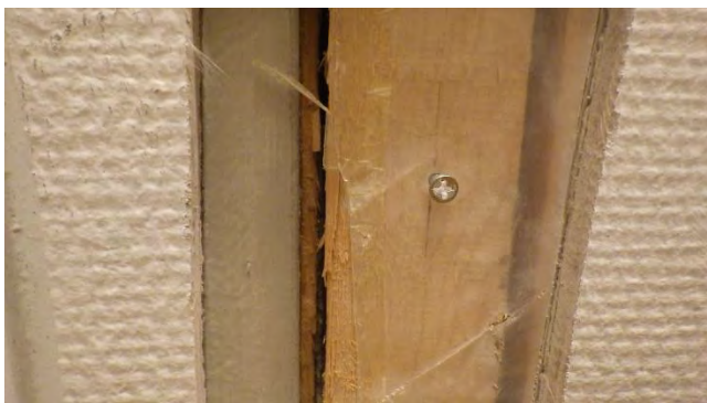
Kuva 32. Ulkoseinän rakenneavaus RA-US12 aulassa 203A.
