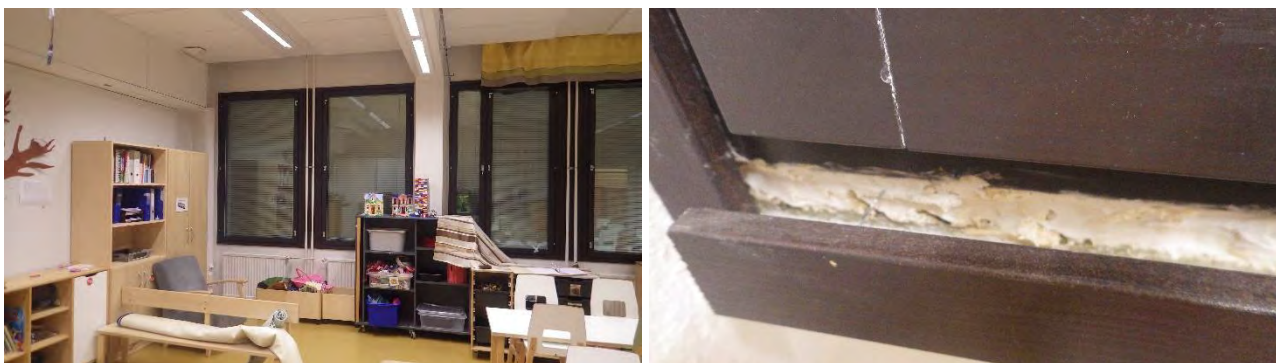
Kuvat 70 a-b. a) Yleiskuva tilan 117A ikkunoista. b) Ikkunatiivisteenä uretaania ja kittiä.
