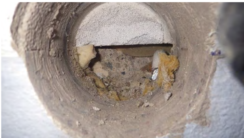
Kuva 22. Rakenneavaus RA-US1 sokkelin ja ulkoseinän liitoskohdassa. Sokkelin mineraalivillan paksuus n. 80 mm ja ulkokuoren paksuus n. 80 mm. Sokkelin sisäkuoren ja kevytbetonin välissä solumuovieristenauha.
