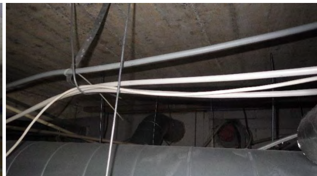
Kuvat 45 a-b. a) Yleiskuva porrassaulan 131E alakattotilasta, jossa mineraalivillapohjaiset alakattolevyt. b) Käytävän 132D alakattotilassa epätiivittä läpivientejä sekä runsaasti pölykertymää.
