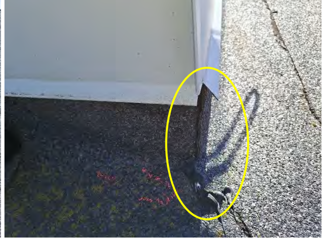
Kuvat 54 a-b. a) Alipainetuulettimien juurella on sammaloitumista. Vesi voi jäädä makamaan tuulettimien juurelle. b) Nostojen saumoissa on yksittäisiä mahdollisia epätiiviskoh- tia.
