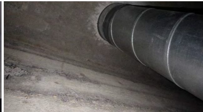
Kuvat 44 a-b. Opettajien huoneen käytävällä 233A katossa vanha kosteusjälki. b) Ko. kohdassa on IV-läpivienti kolmanteen kerrokseen. Alakattotilassa ei havaittu tutkimuskäynnillä aktiivista vuotoa.
