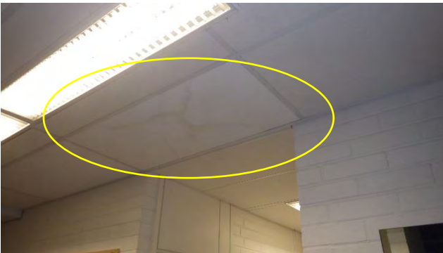
Kuvat 44 a-b. Opettajien huoneen käytävällä 233A katossa vanha kosteusjälki. b) Ko. kohdassa on IV-läpivienti kolmanteen kerrokseen. Alakattotilassa ei havaittu tutkimuskäynnillä aktiivista vuotoa.
