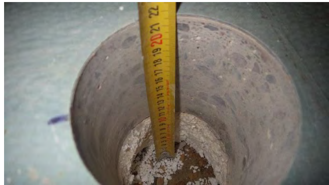
Kuvat 15 a-b. a) Rakenneavaus RA-AP10 tilassa 126E. Alapohjalaatta noin 130 mm ja EPS 100 mm b) Rakenneavaus RA-AP9 tilassa 104Ea ulkoseinälinjalla anturan kohdalla. Alapohjalaatta noin 120 mm ja EPS 100 mm.
