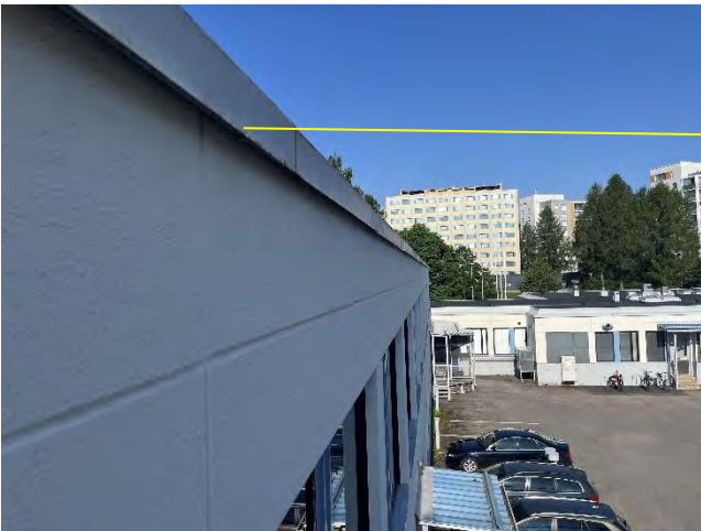
Kuva 56 a-b. a) Yleiskuva räystäsrakenteesta. b) Räystäillä on paikoin useamman senttimetrin rako, josta pienet linnut pääsevät yläpohjatilaan.
