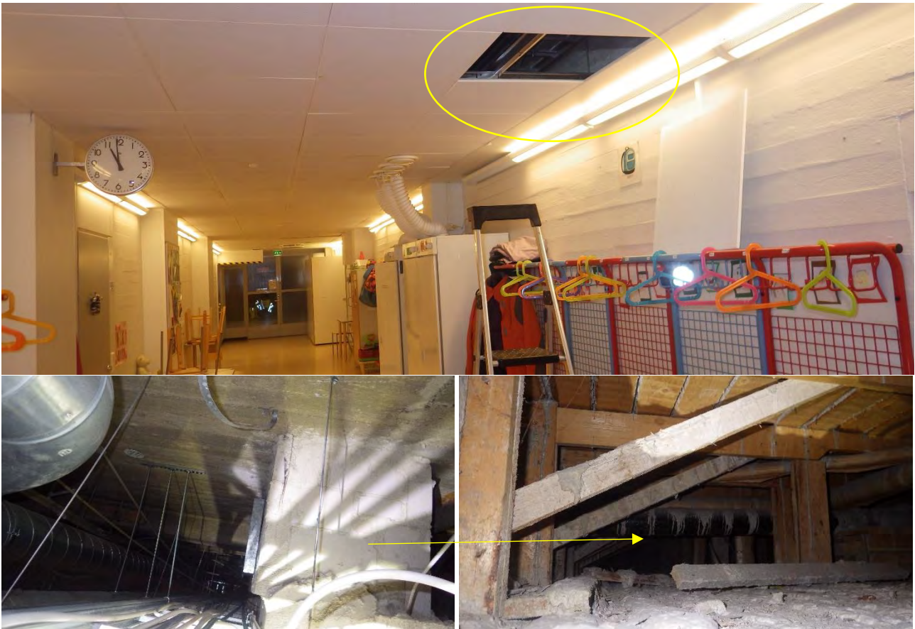
Kuvat 47 a-c. a) Yleiskuva käytävältä 120A, jossa kipsoniittialakatto. b) Kuva käytävän 120A alakattotilasta, joka on suorassa yhteydessä väestönsuojan päällä olevaan ilmatilaan (kuva c). c) Väestönsuojan katon päällä on puurakenteet, ml. muottilaudoitus.
