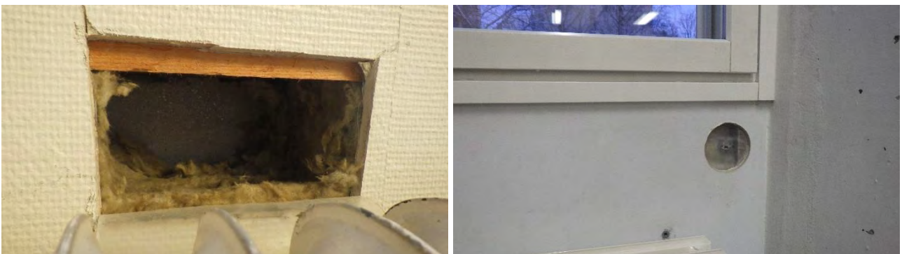
Kuvat 26 a-b. a) Rakenneavaus RA-US12 aulan (204A) ikkunan alle. Sisä- ja ulkopinnalla on kuitusementtilevy ja välissä mineraalivillaa. b) Rakenneavaus RA-US16 tehtiin ikkunan alla olevaan kevytrakenteiseen seinään.
