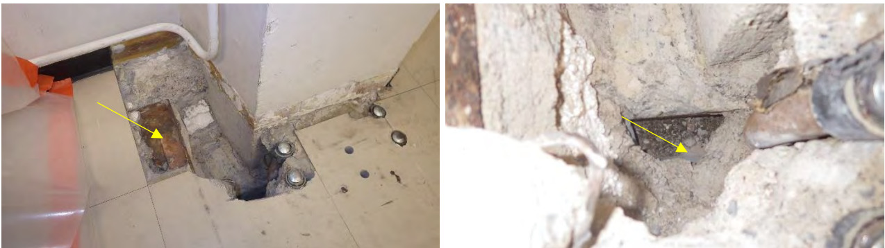
Kuvat 12 a-b. a) Rakenneavaus RA-AP4 tilassa 135D ulkoseinän ja pilariliittymän kohdalla. Pintabetonilaatassa on vanha teräksinen kiinnitysalusta? tai vastaava (keltainen nuoli). b) Alalaatan ja hiekan välissä on muovikerros (keltainen nuoli). Vanhat patteriputkistot on asennettu kaksoislaattarakenteen eristetilaan.
