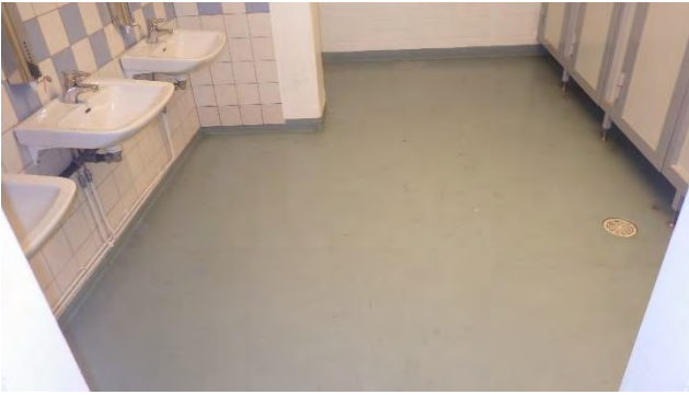
Kuvat 16 a-b. a) Tilassa 104Ea alapohjassa kohonneita havaittiin pintakosteusilmaisimen arvoja. b) Muovimatto irti alustastaan ja sen alta havaittiin poikkeavaa kemiallista hajua.
