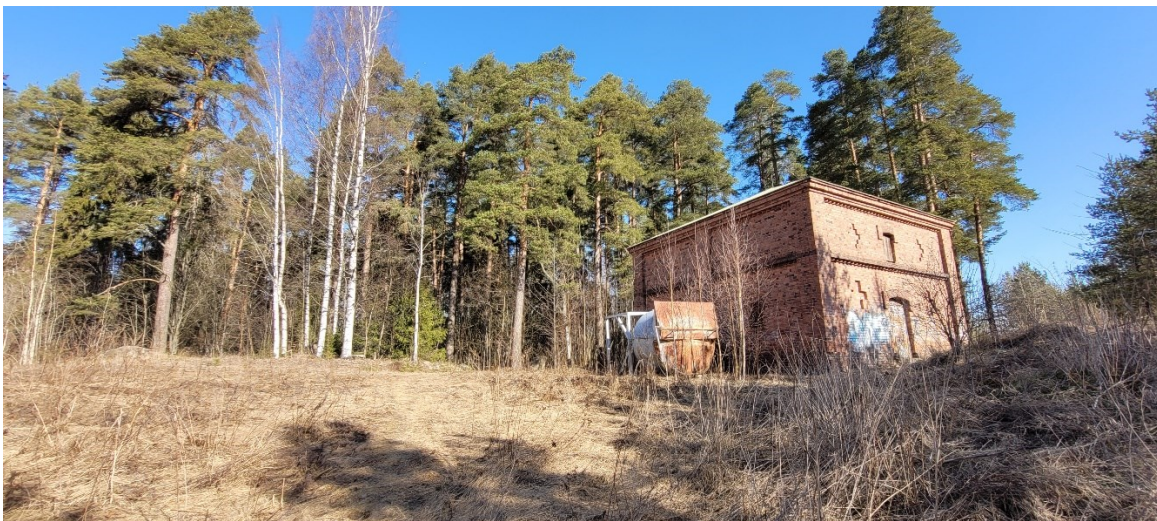
Kuva 9 Viialan Vasaratien teollisuustontilla sijaitsee 1800-luvulla rakennettu makasiini.
