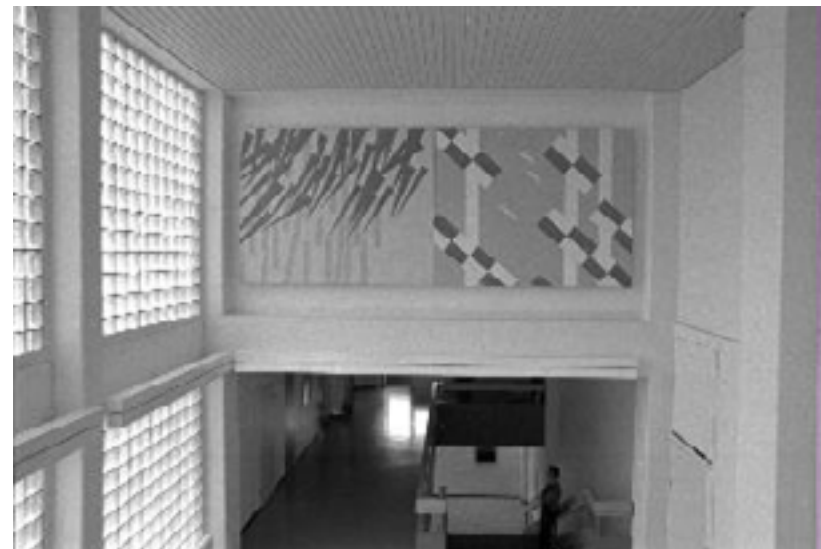
Vastavalmistunut Kaukajärven yhteiskoulun aula. Ikkunoissa vielä lasitiilet ja alakattopinnan paneeli näkyvissä. Raimo Nieminen 22.9.1972. VKA
