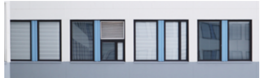
Schreck 1971, länsijulkisivun ikkunat. 2020-luvun alussa uusittujen ikkunoiden välinen muovipinnoitettu vaaleansininen pelti oli alkuperäisessä vaalean siniseksi maalattu kevytbetonipinta
