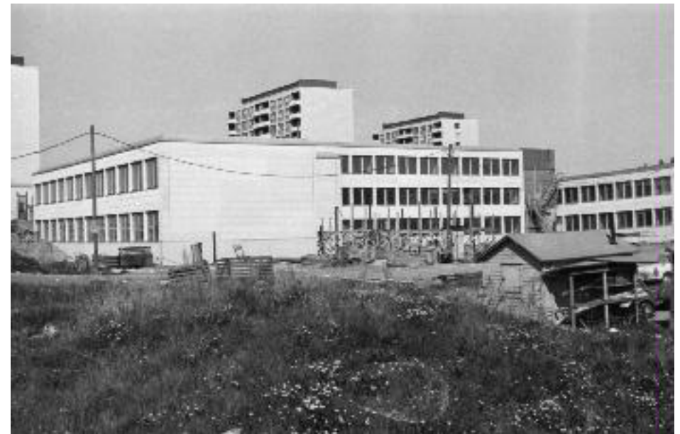
Kaukajärven koulu vielä rakenteilla. Reino Branthin 6.4.1971. VKA
