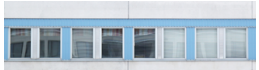
Schreck 1993, länsijulkisivun ikkunat. Laajennusosan ikkunat ovat alkuperäisiä matalammat ja näin pinta-alaltaan pienemmät.
