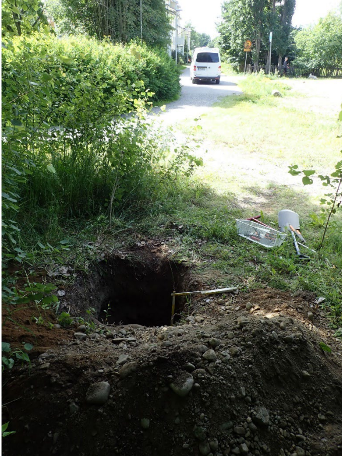
Kuva 11. Koekuoppa 13. Koekuopan kohdalla oli vanha tienpohja. Ilmeisesti tietä perustettaessa on paikalta poistettu vanhat peltokerrokset.
