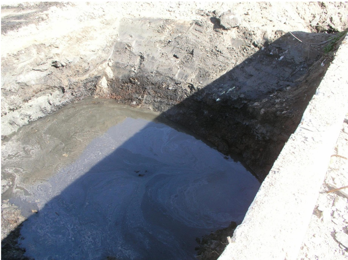
Kuva 2. Täyttöalueen kunnostuskaivantoon kerääntyi vettä, joka johdettiin öljynerottimen kautta viereisen kaatopaikan pintarakenteisiin imeytettäväksi
