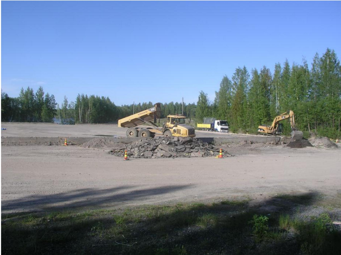
Kuva 1. Täyttöalueen kunnostus aloitettiin betonilaatan länsipuolelta
