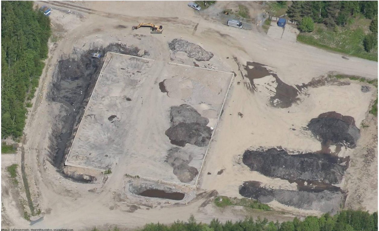
Kuva 11. Rannan täyttöalueen kaivun alkuvaihe (ilmakuva: Eniro)
