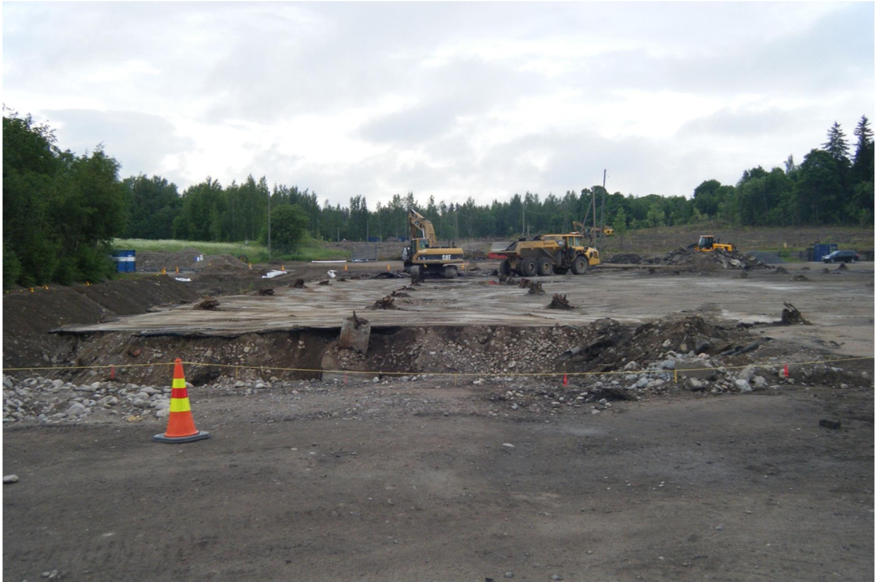
Kuva 7. Betonilaatta purettiin kesäkuussa
