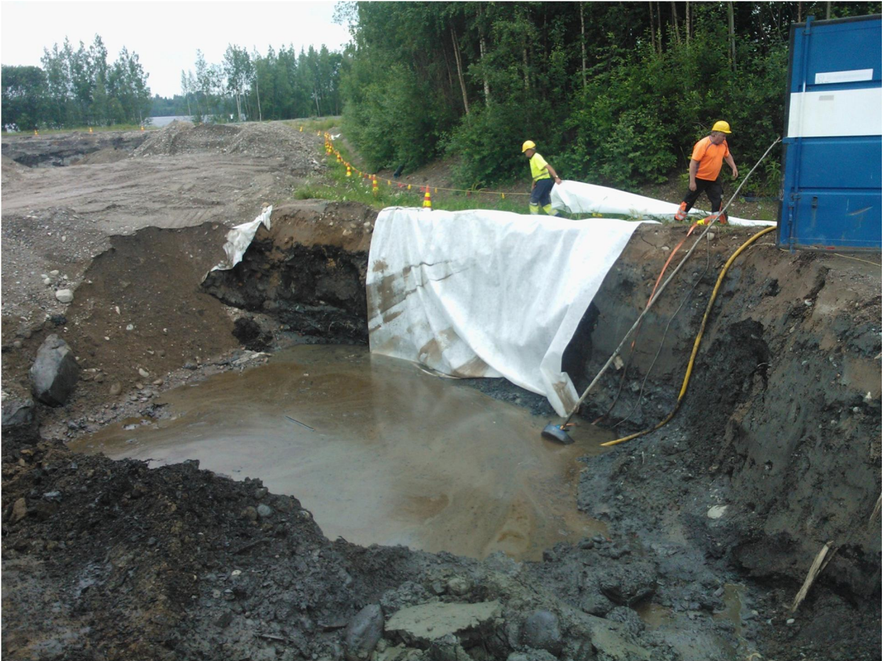
Kuva 3. Suodatinkankaan asennusta
