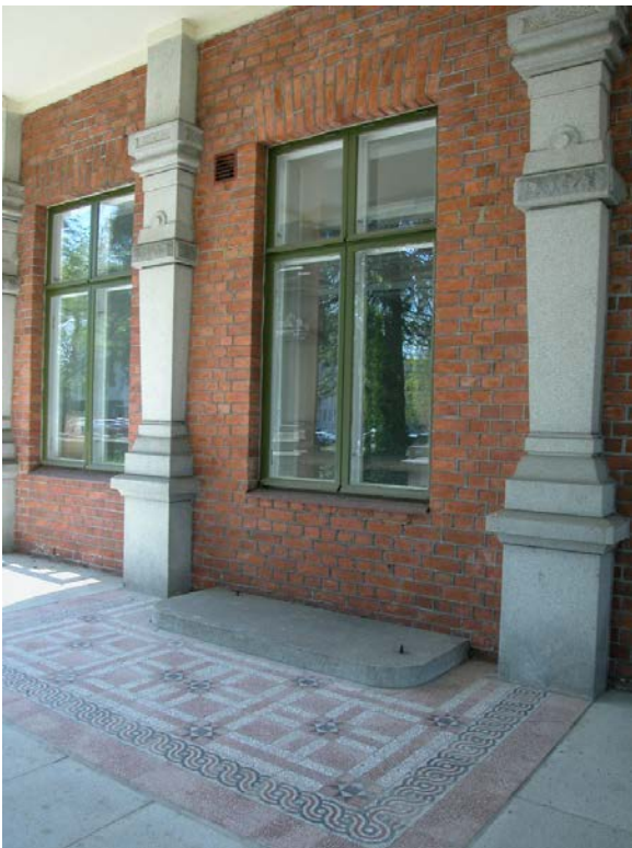
Terassin koristelaatoitusta, alkuperäinen pääoven paikka.
