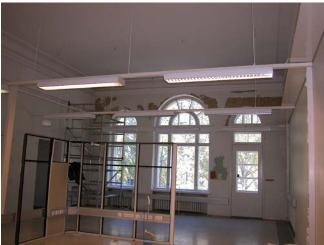
221 Ikkunat itään, yleiskuva
