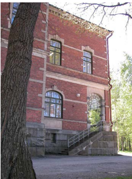
Julkisivu pohjoiseen, luoteiskulma
