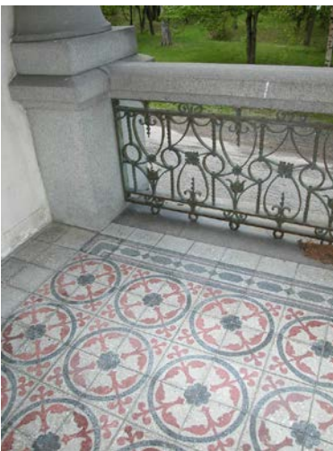
Länsiterassin laatoitusta ja terassin kaide
