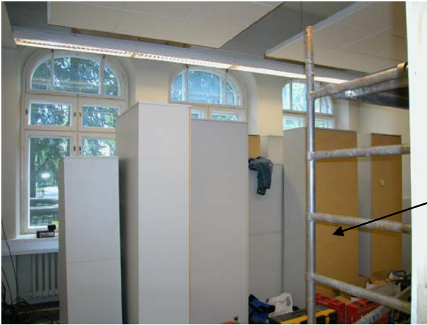
123 Ikkunat itään, yleiskuva
