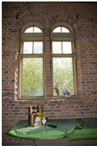
Tornihuone, ikkunat etelään
