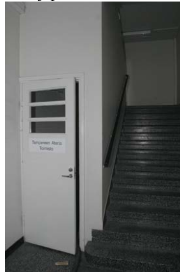
126, portaikko toiseen kerrokseen ja ovi käytävään 124
