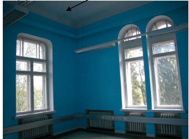
228 Ikkunat pohjoiseen ja itään (pari-ikkuna)
