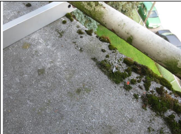
Kuva 3: Parvekelaatoissa on kosteusrasitukseen viittaavaa kasvustoa.
