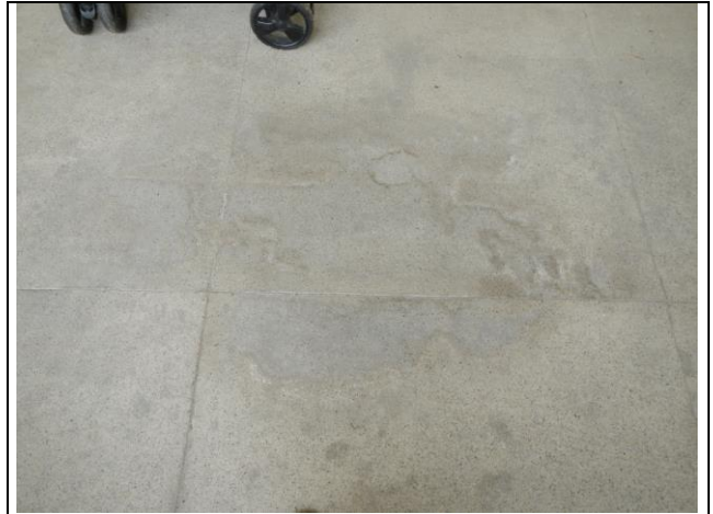
Kuva 2: Kuva terassiparvekelaatan yläpinnasta
