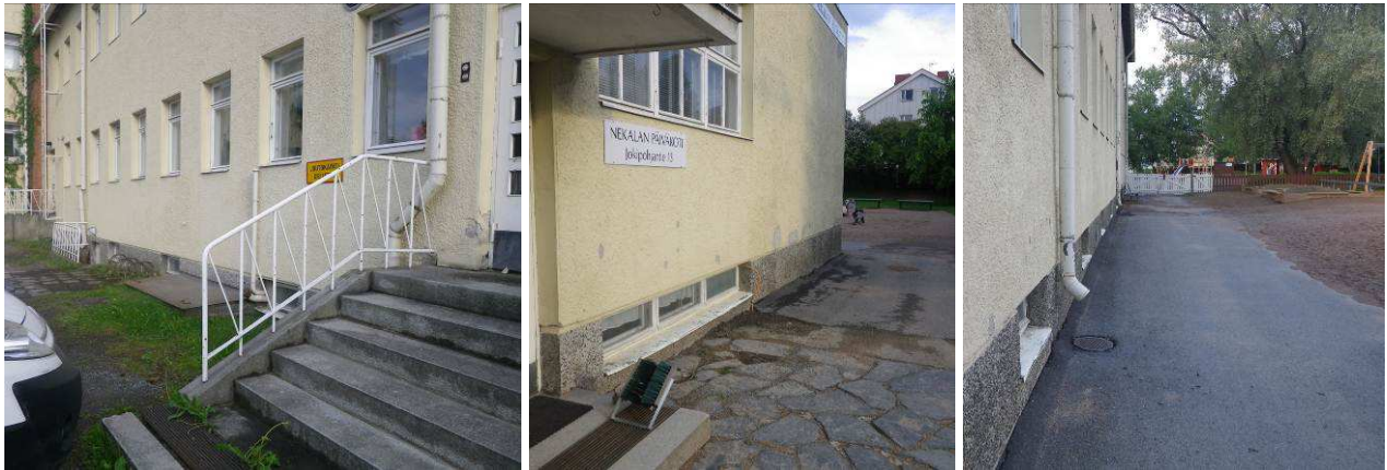
Kuva 2 a, b ja c. Yleiskuvia rakennuksen vierustasta.
