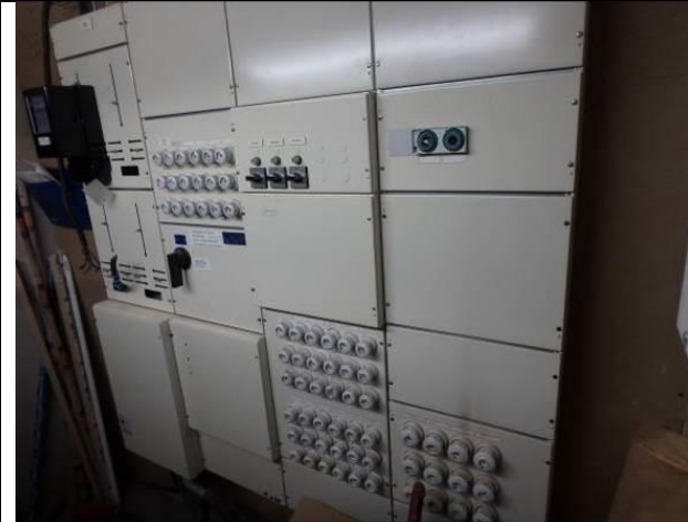
Yhdistetty pää- ja kiinteistökeskus vuodelta 1991
