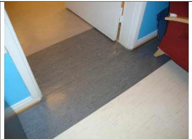
Lattianpäällysteet ovat ehjiä ja saumaukset kunnossa
