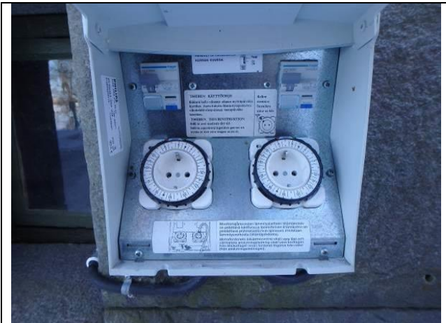
Hyväkuntoinen autolämmityspistorasiakotelo
