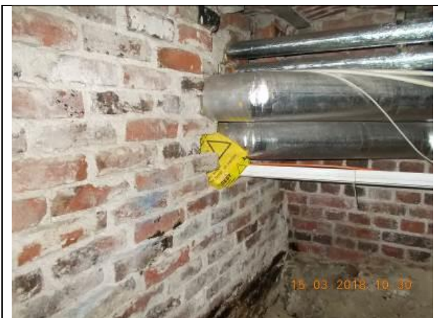
Putkien eristeistä on kartoitettu asbesti
