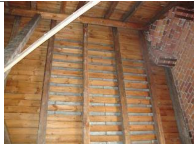
Vesikatteen puurakenteet ovat hyväkuntoisia
