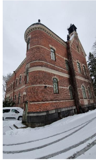
Kuva 2 Rakennuksen julkisivua etelän suunnasta
