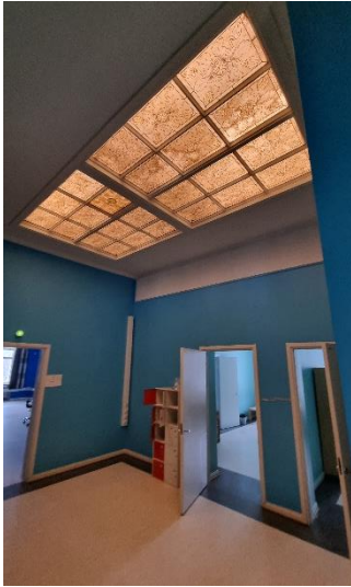
Kuva 1 Yleiskuva kohteesta. Yläaulassa oleva kattoikkuna.
