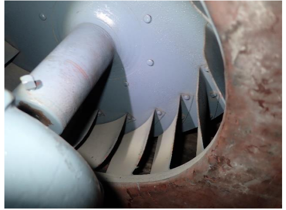
Kuva 8 PK1 siipipyörän siivet ovat likaantuneet, ja sen laakeri ääntää.
