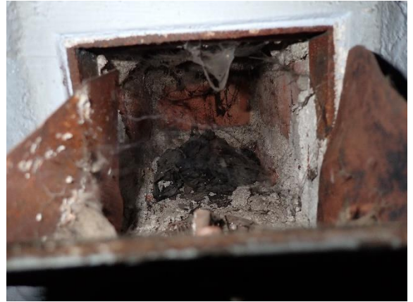
Kuva 18 Raitisilma-aukot ovat osin erittäin likai- sia.
