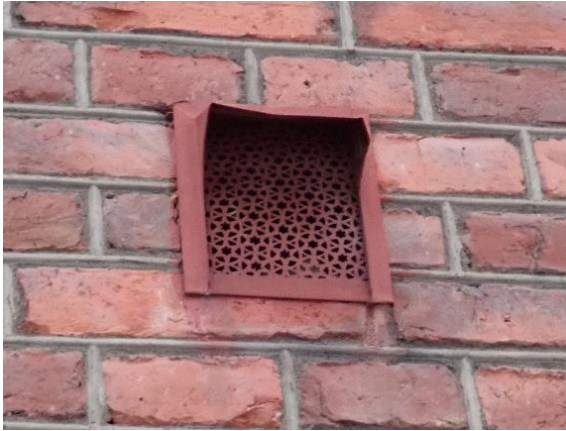
Kuva 3 Oletettavasti rakennuksen alkuperäinen koristeellinen korvausilmaventtiili julkisivussa.
