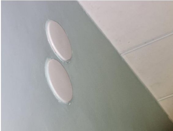
Kuva 19 Osa lautasventtiileistä on täysin suljettuja.
