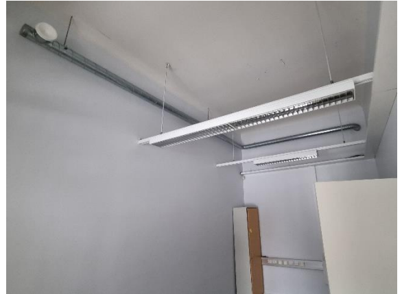
Kuva 20 Huoneeseen 104 on asennettu kierresaumakanavaa tuloilmakanavaksi.
