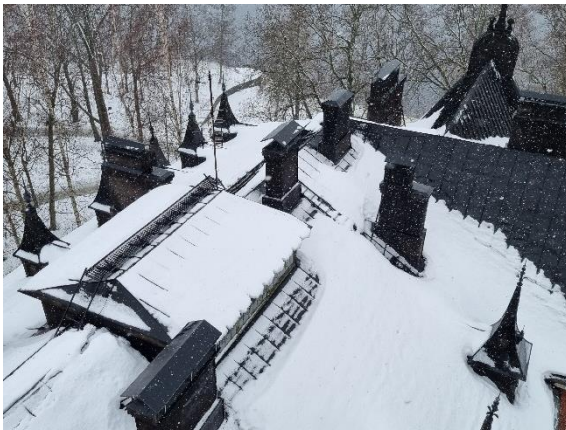
Kuva 5 Painovoimaisen ilmanvaihdon hormeja vesikatolla
