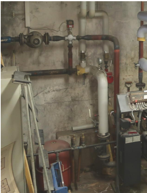
Kuvat 10 ja 11. Laippaliitosten tiivisteet sisältävät todennäköisesti asbestia.
