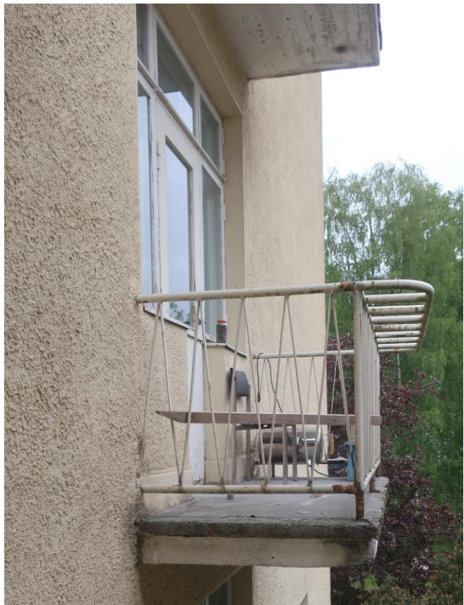
Kuvat 20 ja 21. Parvekkeiden vedeneristeenä käytetty bitumihuopa sisältää asbestia (Dimen Oy:n näytteet 5 ja 7).
