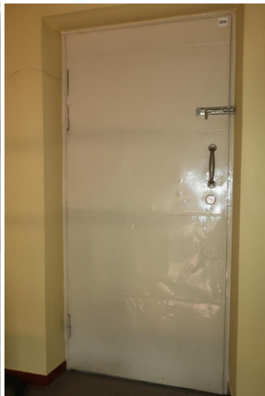
Kuvat 7 ja 8. Vanhat peltiset palo-ovet ja niiden karmit sisältävät asbestia.
