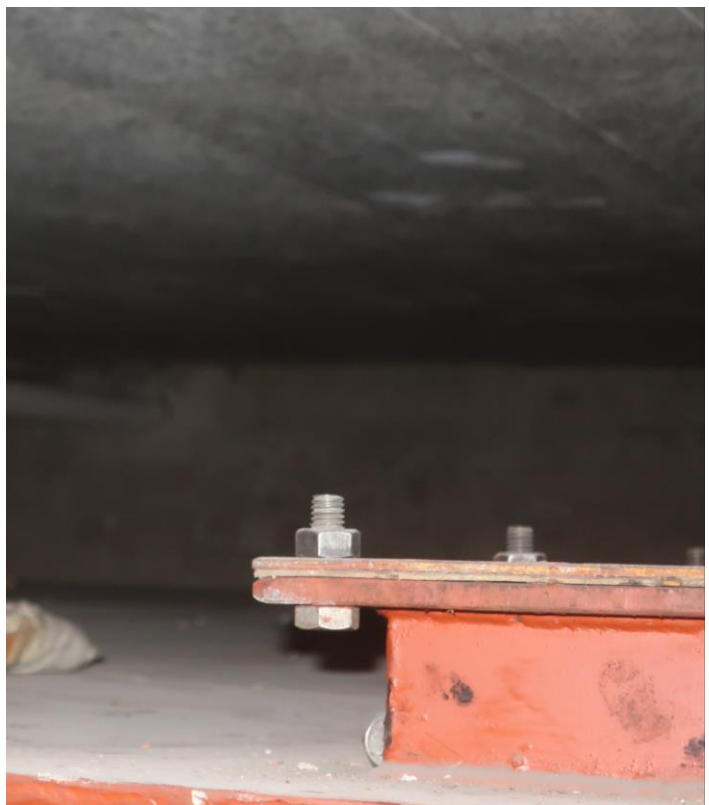
Kuvat 10 ja 11. Laippaliitosten tiivisteet sisältävät todennäköisesti asbestia.
