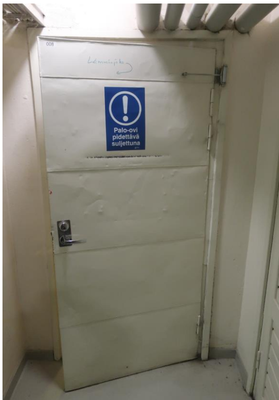
Kuvat 7 ja 8. Vanhat peltiset palo-ovet ja niiden karmit sisältävät asbestia.
