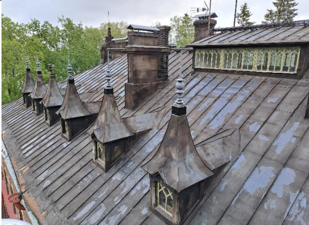
Vesikaton yleiskuvaa läntisellä julkisivulla
