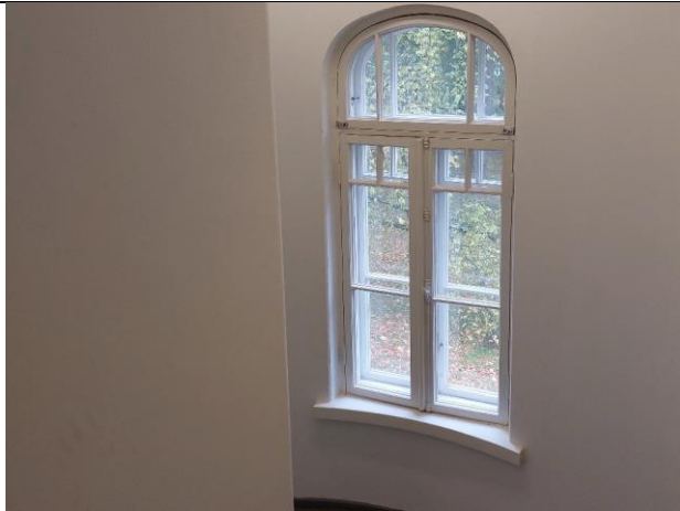
Rakennuksessa paikoin alkuperäisiä ikkunoita porrastilassa
