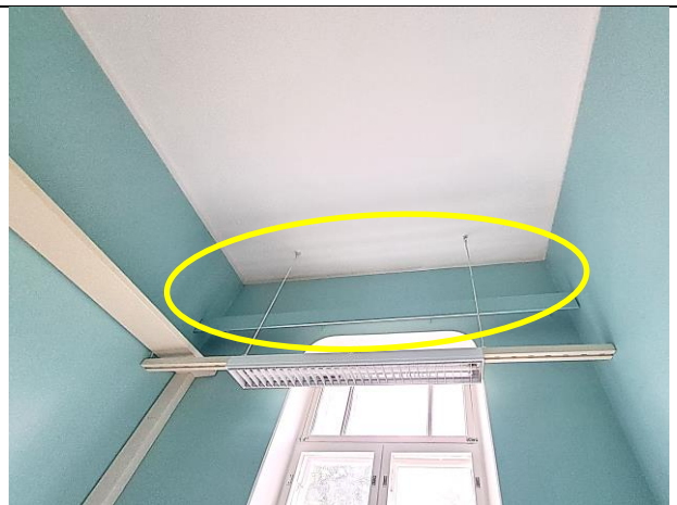
Mahdollista ilmavuotojälkeä katon rajassa
