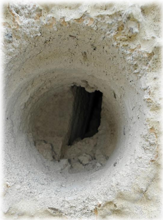
Kuva 1 rappauksen alustana ja lämpöeristeenä on siporexharkko, rappauksen mitattu paksuuden vaihteluväli 19-26 mm.
