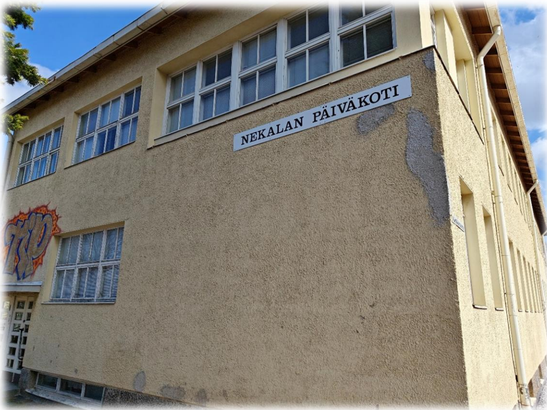
Kuva 3 Rappauksessa oli muutamia paikkarappauskorjauksia
