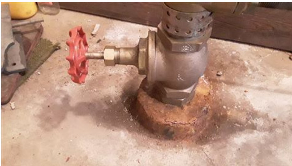
Varauduttava tonttivesijohdon ja pääsulkujen uusintaan.
