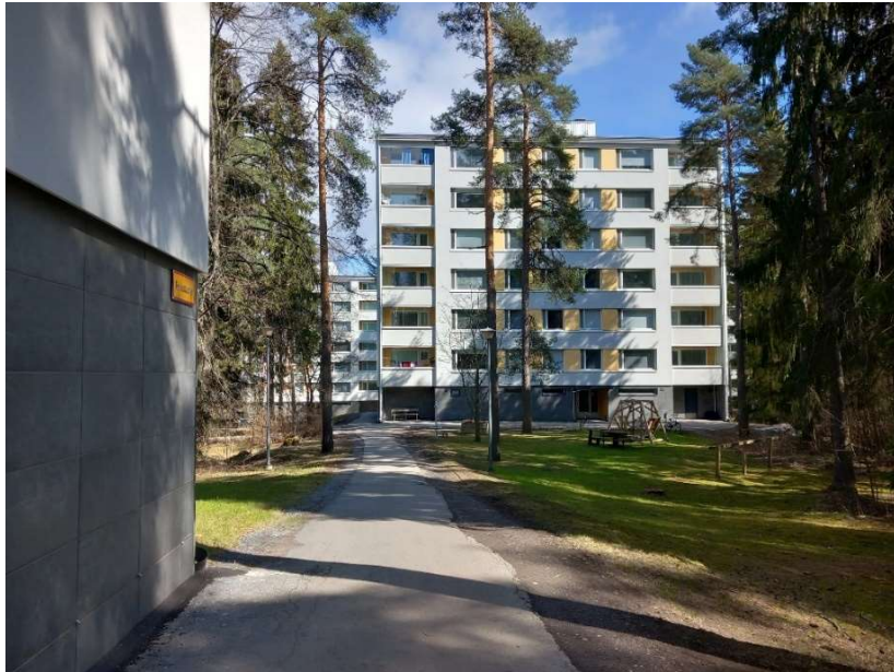
Kuva 4: Suunnittelualueutta keväällä 2023. Rakennuksille on tehty mittava korjaus vuosina 2021-2022. Kuva Tampereen kaupunki.
