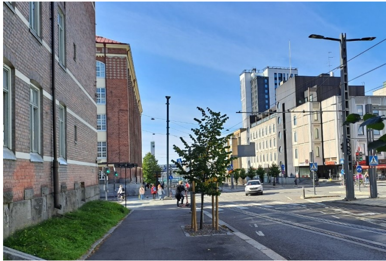
Kuva 5. Näkymä Itsenäisyydenkadulta: Purettava vaalea rakennus on kuvassa oikealla. Sen takana näkyy Luminary-rakennuksen torni. Aivan taustalla hämmöttää rautatieaseman kellotorni. Vasemmalla etualalla on Toralinnan kulmaus ja sen takana ns. Attila-rakennus. Kuva: Sanna Lahti, 2023.
