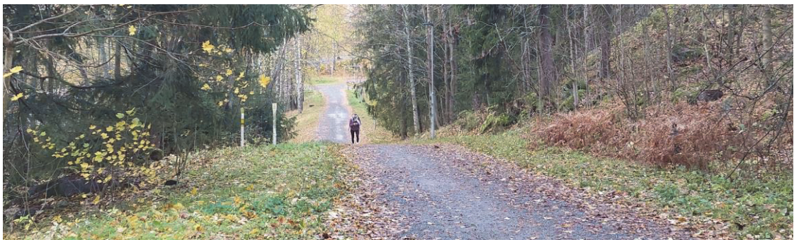
Kuva 2. Kaasuputken valkoiset merkkipaalut väylän eteläreunalla
