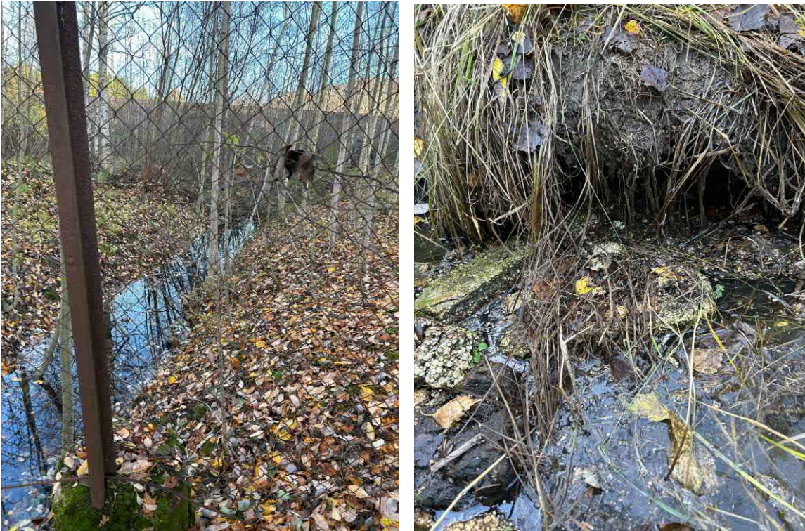
Kuva 3.2. Radan eteläpuolinen hulevesiuoma (vas.) ja Uurastajankadun hulevesirumpu (oik.)
