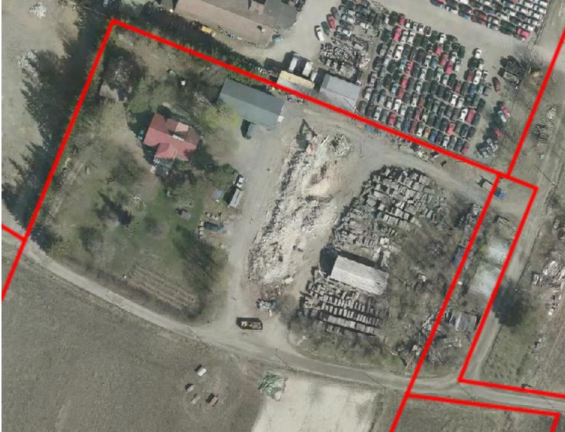
Kuva 7. Ilmakuva kiinteistön 2–55 alueesta vuodelta 2020, jossa kuvan yläreunassa nähtävillä harmaakattoinen hallirakennus ja purkuvaiheessa oleva karjasuoja (Ilmakuva © Tampereen kaupunki, lähde: Oskari karttapalvelu 10/2024).
