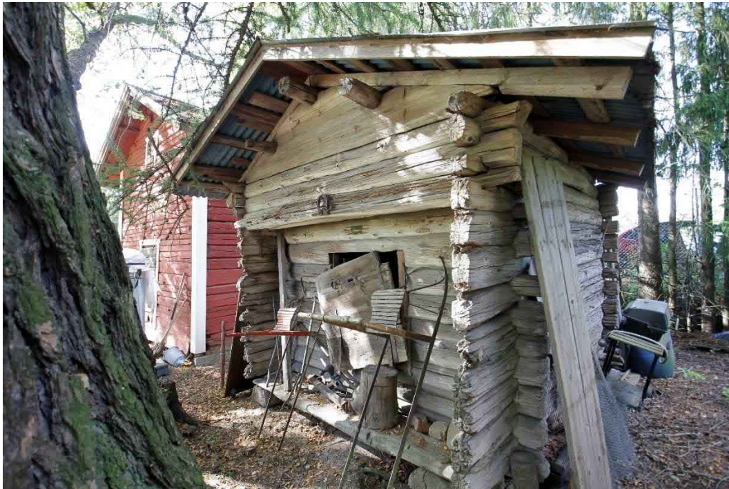
Kuva 39 Ala-Heikkilän alkuperäisen aitan koillispuolella on paikalle 1960-luvulla siirretty otsallinen aitta. Aitassa on pitkät nurkat. Nurkkakivet ovat betonia ja vesikate aaltopeltiä. Aitan edustalla kasvaa kookas lehtikuusi.
