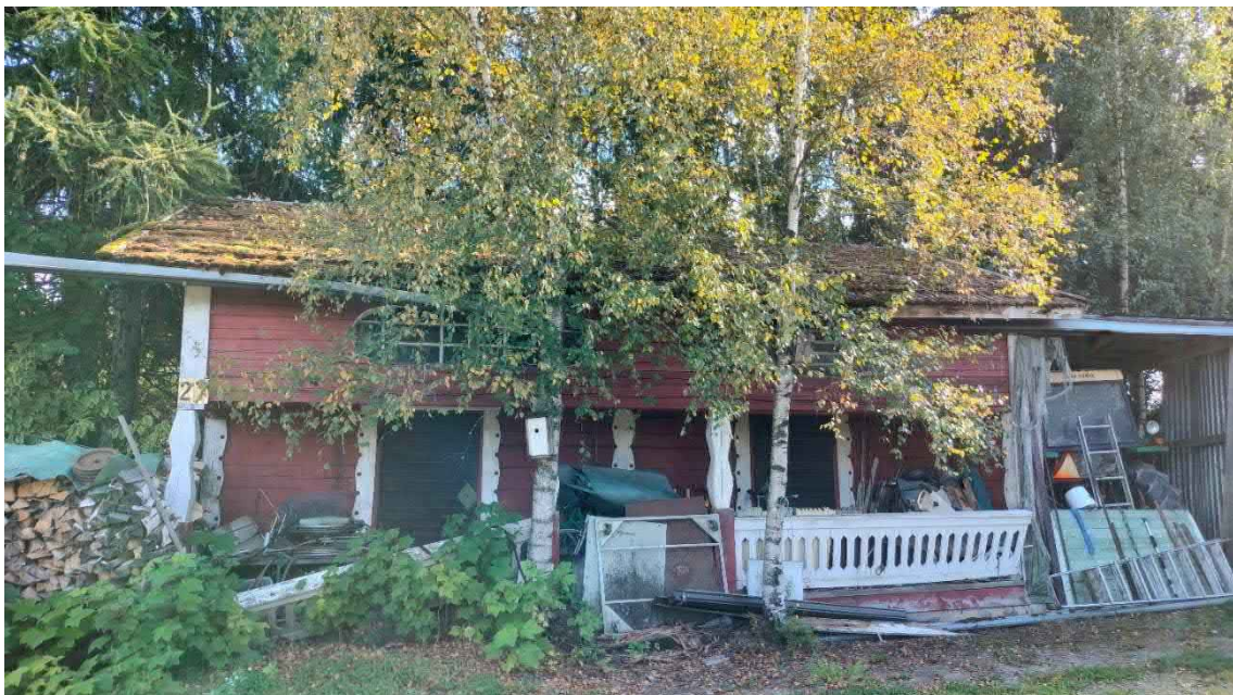
Kuva 48 Hannulan pihassa oleva luhtiaitta on mahdollisesti Takahuodin kylän Linna-nimisestä talosta paikalle siirretty. Luhtikäytävää kannattelevat pilarit on muotoiltu veistämällä. Aitan ensimmäisessä kerroksessa nurkkalistat ja ovien listoitus on koristeellista. Aitan eteläpäädyssä on peltivuorattu katos.
