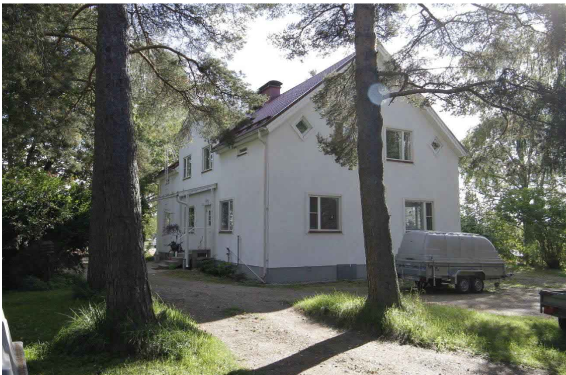
Kuva 36 Ala-Heikkilän asuinrakennus luoteesta. Koillissivun sisäänkäynnin päällä on teräsrunkoinen yksilappeinen lasikate. Koillisjulkisivun keskiosassa on kahden kerroksen korkuinen frontoni.
