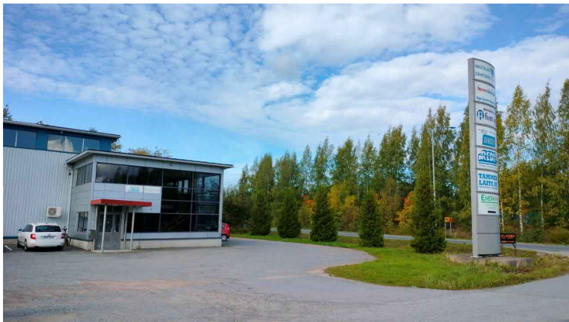
Kuva 26 Teollisuusrakennuksen sisäänkäyntipääty Hautalantien ja Sammon valtatie risteyksessä. Kuvan oikeassa laidassa maamerkinä toimiva tavanomainen mainoskyltti.
