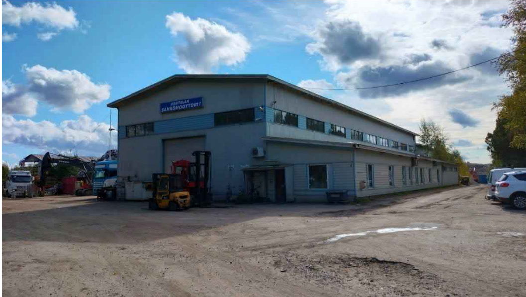
Kuva 55 Hautalan Sähkömoottori Oy:n teollisuusrakennus tarkastelualueen itäosasta. Yrityksen pihapiirissä on rakennusjätteen lajitteluasema ja betonin läjitystä. Kuva on otettu luoteesta.
