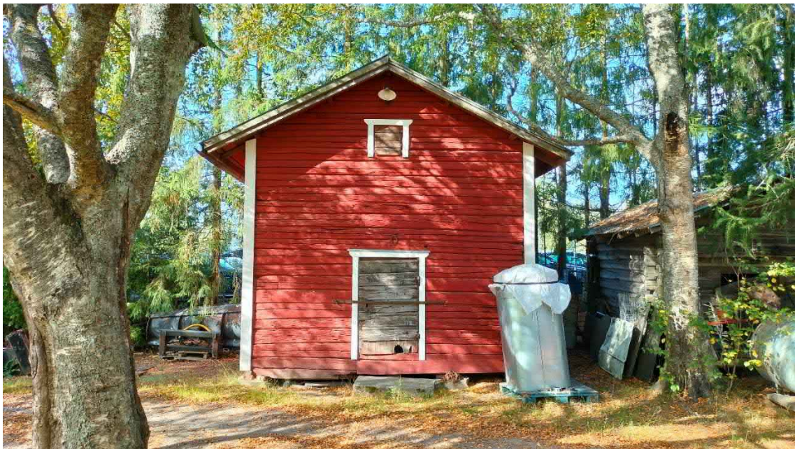
Kuva 38 Ala-Heikkilän päätyovellinen aitta on 1900-luvun alusta ja alkuperäisellä paikallaan. Aitta on eteläisin kiinteistön luoteisreunalla olevista neljästä aitasta. Aitta on ainoa Ala-Heikkilän rakennuksista, joka säästy jatkosodan aikaisesta tulipalosta. Aitan hirsikehikko on lyhytnurkkainen ja kulmat on laudoitettu. Aitta on perustettu nurkkakivien varaan. Nurkkakivinä on käytetty porakiviä ja betonilaattoja. Vesikate on aaltopeltiä. Laidoitettun oven yllä on aitan yläkerrassa lastausluukku.
