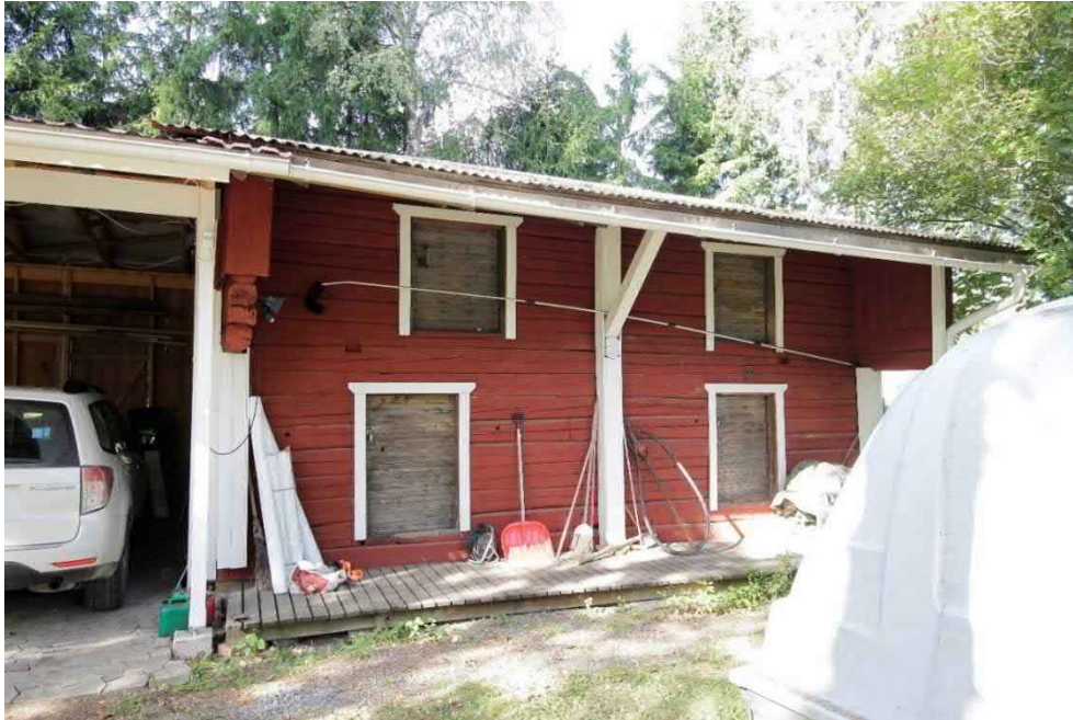
Kuva 44 Ala-Heikkilän pihan pohjoiskulmassa on kaksikerroksinen riviaitta. Rakennustavasta päätellen aitta on viimeistään 1900-luvun alkupuoliskolta, mutta ilmakuvienv perusteella se on siirretty paikalle vasta 1900-luvun jälkipuoliskolla. Aitassa ei kuitenkaan ulkopuolella näkynyt siirtomerkkejä. Aitassa vaikuttaa alkujaan olleen luhtikäytävällinen. Hirsikehikon pitkät nurkat on koteloitu. Vesikatteena on aaltopelti. Rakennusta on laajennettu autokatoksella 2000-luvulla.
