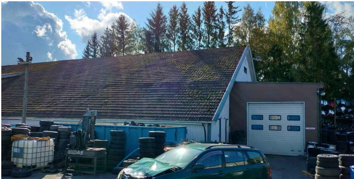
Kuva 30 Autopurkaamo Fusti Oy:n teollisuusrakennus kuvattuna pohjoisesta. Koillisjulkisivulla teollisuushallin katon lape ulottuu hyvin alas. Koillisjulkisivu on vuorattu profiilipellillä, katto on tummaa sementtitiiltä. Luoteispäädystä on lapekattoinen laajennusosa 2000-luvun alusta. Taustalla näkyy Ala-Heikkilän pihapiiriä rajaava kookas kuusiaita.
