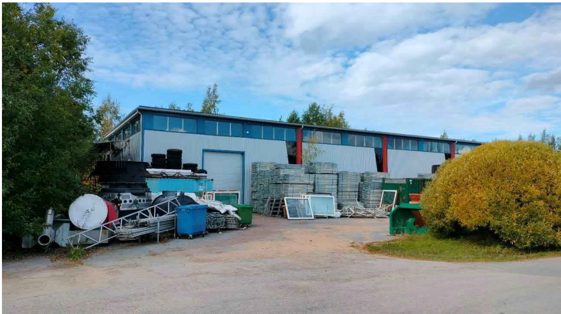
Kuva 25 2000-luvun alussa rakennettu teollisuusrakennus ja sen pihapiiriä Hautalantien länsipuolelta.
