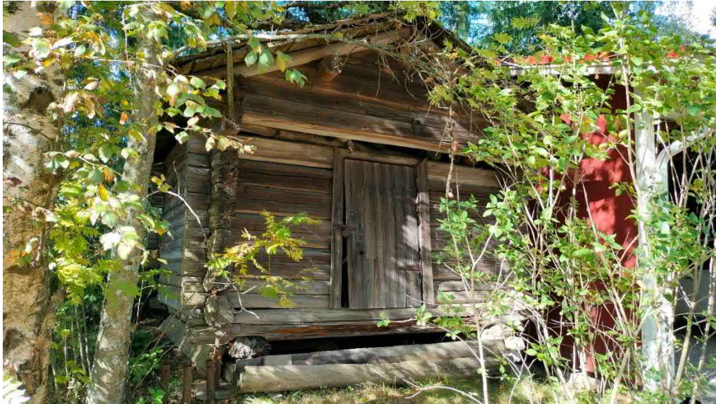
Kuva 41 Toinen Ala-Heikkilään siirretty otsallinen aitta sijaitsee edellisen aitan koillispuolella. Myös se on pitkänurkkainen. Perustuksena on betonikivien päällä oleva hirsikehikko. Vesikatteena on sementtitiilet, joiden alta näkyy myös päreitä.
