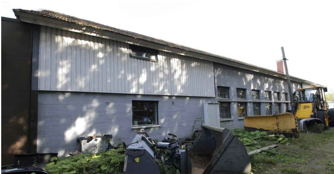
Kuva 29 Autopurkaamo Fusti Oy:n teollisuusrakennus kuvattuna lounaasta. Tiilimuuratun teollisuushallin julkisivu on osittain vuorattu profiilipellillä. Hallin kaakkoispäädyn toimistotilat on myös vuorattu profiilipellillä. Teollisuushallissa on pieniruutuiset ikkunat. Ikkunoiden 9-ruutuinen alaosa on neliön mallinen, yläpuolella on 6-ruutuiset vaakaikkunat. Yhdessä nämä ikkunat antavat vaikutelman pystyikkunoista.
