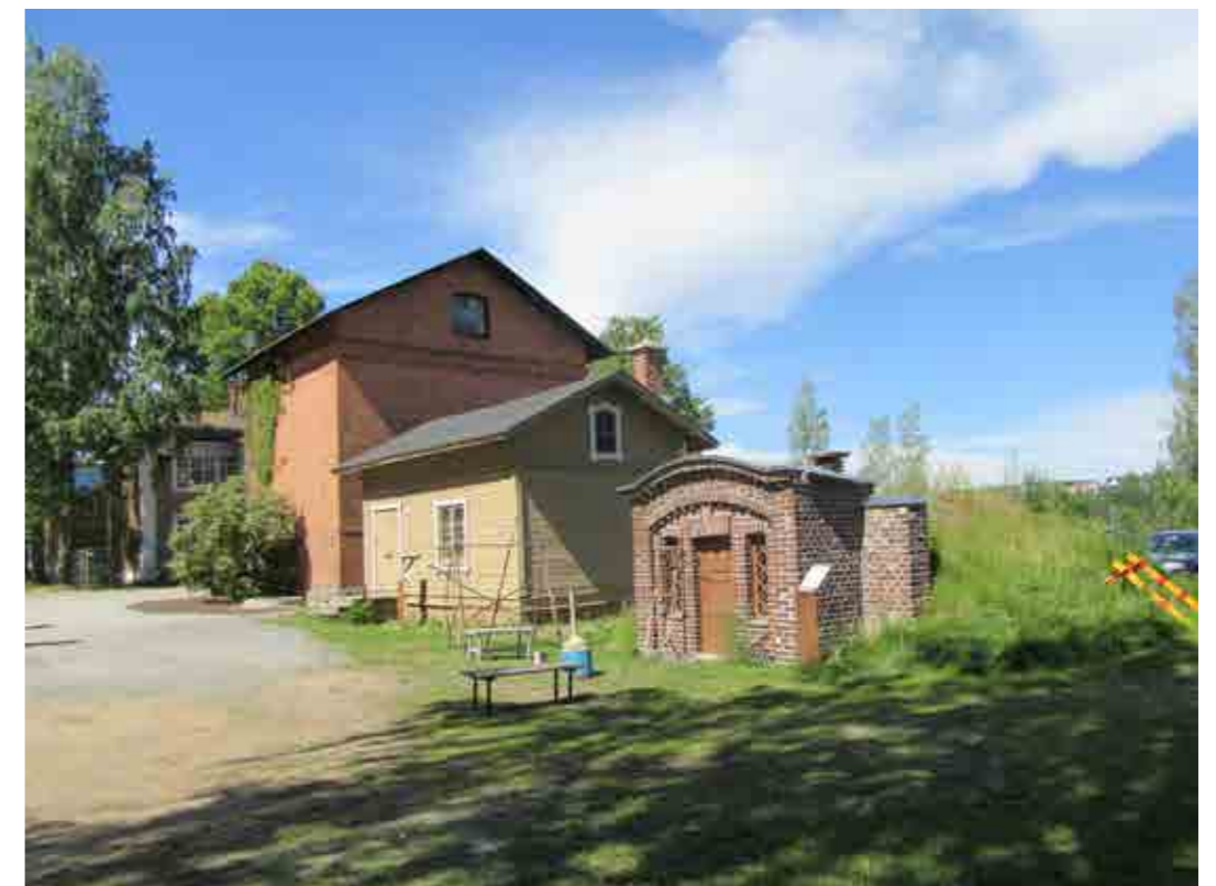
Kartanon talousrakennuksia. Etualalla maakellari, sen vieressä puinen talousrakennus sekä tiilinen makasiini, jota käytetään nykyisin autotallina. Taustalla Virkamiestalo ja pysäköintialue.
