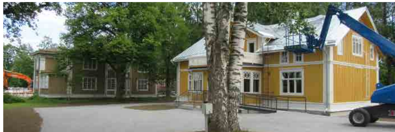
Jukolan vastakunnostettu piha-alue. Takana Virkamiestalon rakennus, jonka alustavat kunnostustoimenpiteet oli aloitettu alkuvuodesta 2020. Virkamiestalon edustalla oleva vanha lehmus säilytetään.
