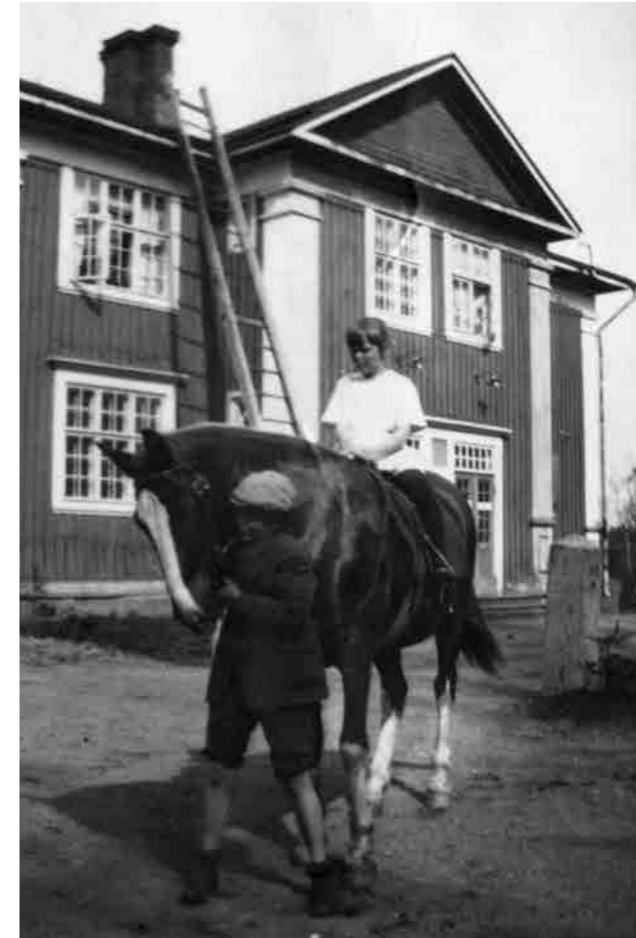
Ylin kuva vasemmalla: Suunnittelukonttori/ virkamiestalo nykyistä vaatimattomammassa asussa 1800-1900-lukujen vaihteessa. Valokuvan tiedoissa rakennuksen nimi on Enqvistin sosiaalikonktori. Vanhan kartta-aineiston perusteella rakennus on alun perin ollut osa avointa nelöpihamaista talousrakennusten muodostamaa kokonaisuutta. Se muutettiin 1910-1920-luvulla kahden virkailijaperheen asunnoksi ja myöhemmin tehtaan toimistoksi. Kuva Reino Branthin n. 1900-1929. VK
