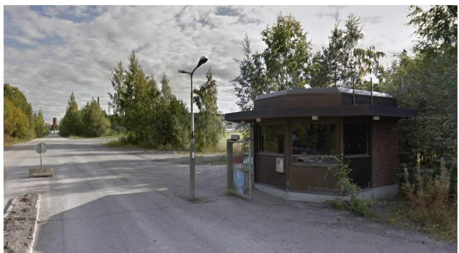
Portinvartijan rakennus liki alkuperäisessä asussaan. Tehdaskartanonkadun päässä näkyy vesitorni. Kuva Google Maps 2011.
