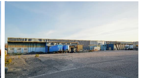
Teollisuuskiinteistö alueen eteläpuolella
