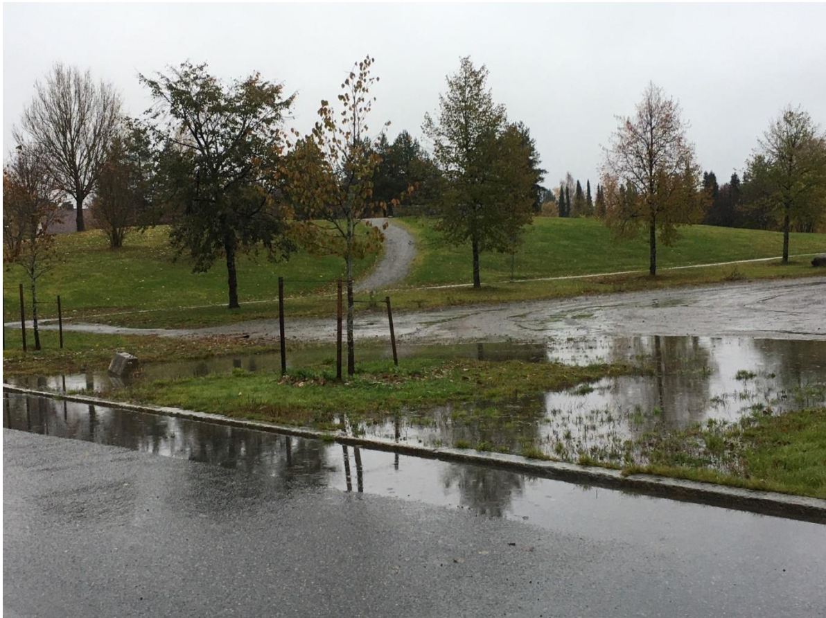
Kuva 2.5. Huleveden nykytilainen lammikoituminen Kissanmaankadun varressa tulee poistaa tasaus-, hulevesikaivo- ja tulvareittisuunnittelulla (Kuva: Ramboll/Jonkka-H. 22.10.2020).
