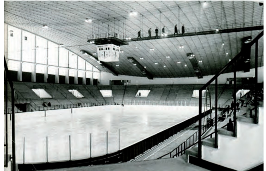
Hallin päätila lopputarkastuksen aikaan vuonna 1965. Tarkastajat kulkevat kellostillalla 18 metrin korkeudessa. Kuva: Hirvikallio, 2015; Leinonen, 2015
