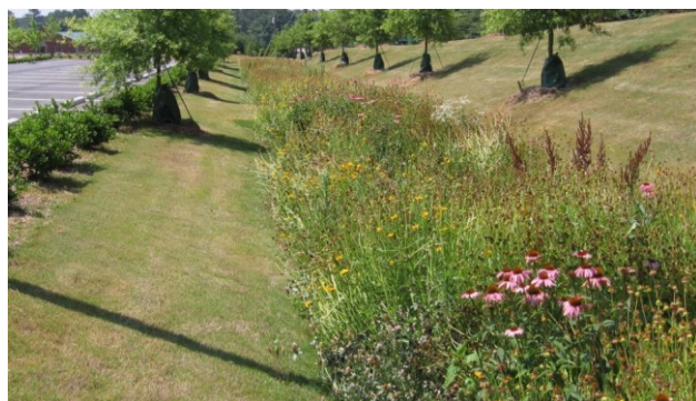
Esimerkki huleveden suodatuspainanteesta viheralueella. Kuva: Ramboll Oy
