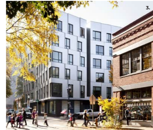
Toimisto- ja työpaikkarakennukset Paasikiven suuntaan
