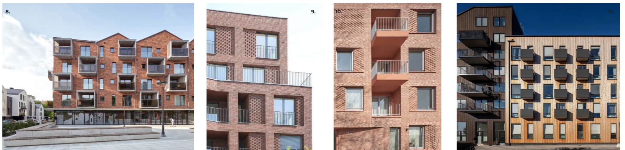
Kaupunkimainen arkkitehtuuri vaihtelevilla kattomuodoilla
