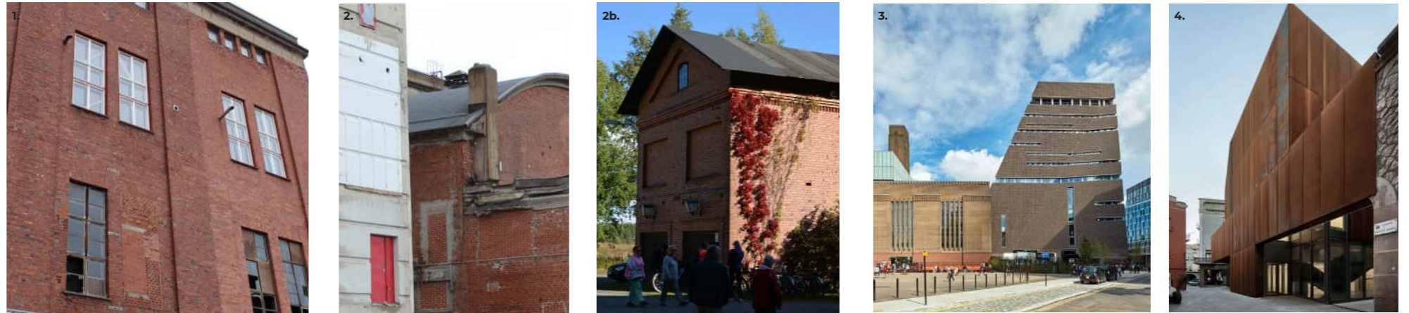
Tehdasalueen monimuotoinen rakennuskanta antaa virikkeitä alueen uuteen arkkitehtuuriin.
