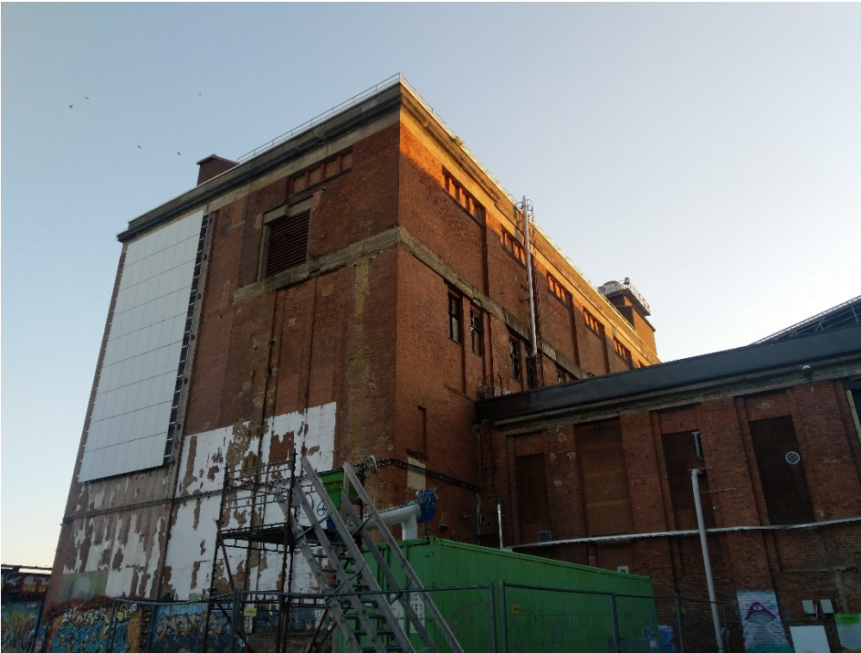
Kuva 5. Tehdaskompleksin osa, jossa on runsaasti avoimia aukkoja rakennukseen.
