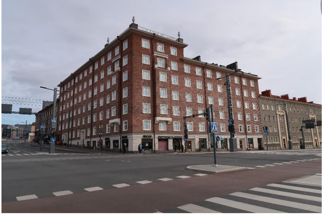
Rakennuksen nurkka kohti risteystä.
