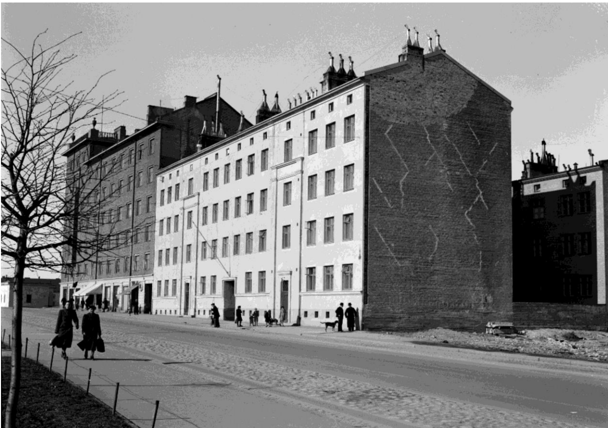
Kuva 17. Rakennus on korjattu ja katujulkisivu rapattu. Kuvaaja E. M. Staf, 1942, Vapriikin kuva-arkisto. CC BY 4.0
