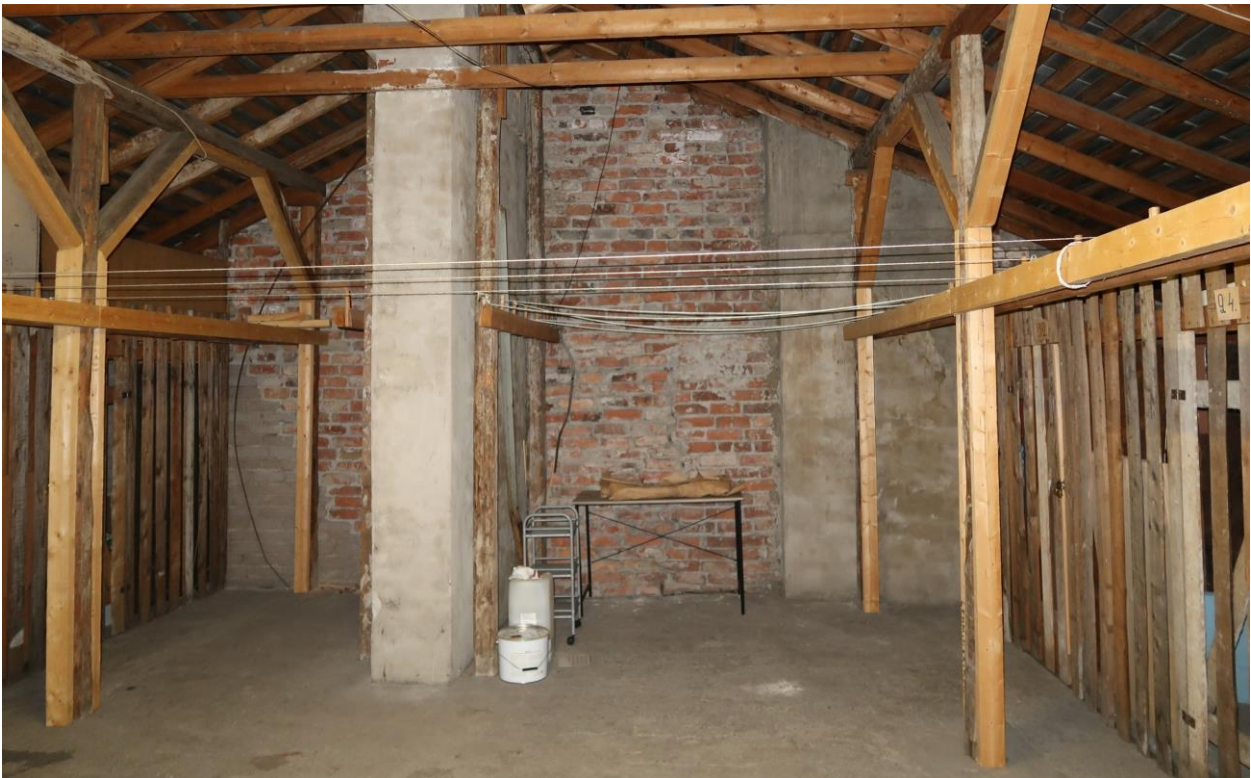
Kuva 45. Ullakot ovat avaria. Kuvassa vuoden 1940 pommituksessa vaurioitunut ulkoseinä, jota on paikattu osittain myös kahitiilillä.
