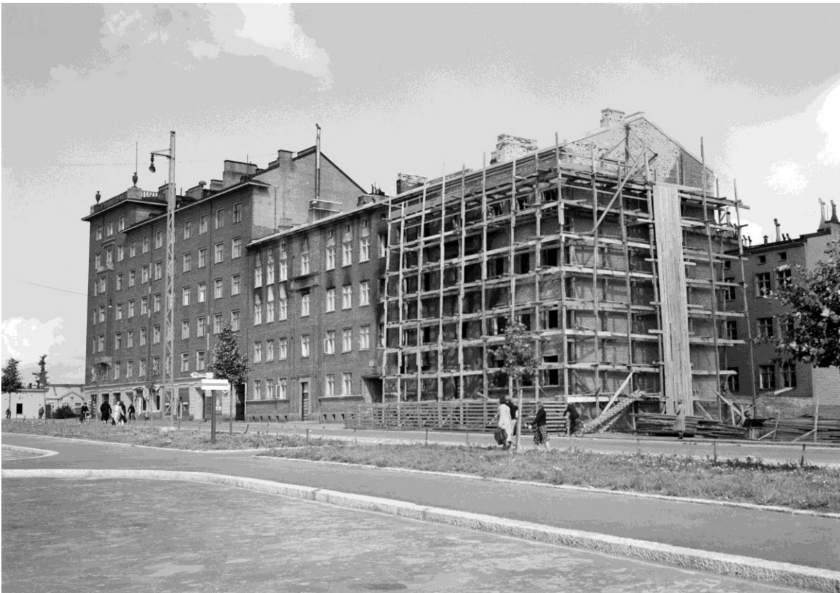
Kuva 16. Rakennusta korjataan. Kuvassa näkyy telineiden takaa, miten pääjulkisivussa käytetyt tiilet ovat kirjavia ja miten ikkunoiden yläpuolelle lieskoista tulleita tummentumia on yritetty putsata, mutta ne ovat edelleen hyvin näkyviä. Kuvaaja E. M. Staf, 1942, Vapriikin kuva-arkisto. CC BY 4.0
