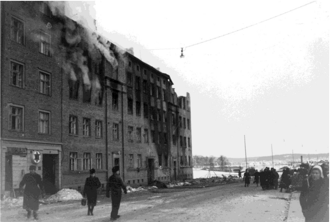
Kuva 15. Vaurioitunut As Oy Sorinmäen rakennus. Kuvaaja Teuvo Mäkinen 2.3.1940, Vapriikin kuva-arkisto. Teuvo Mäkinen asui naapuritalossa, Hatanpään valtatie 12:ssa. CC BY 4.0
