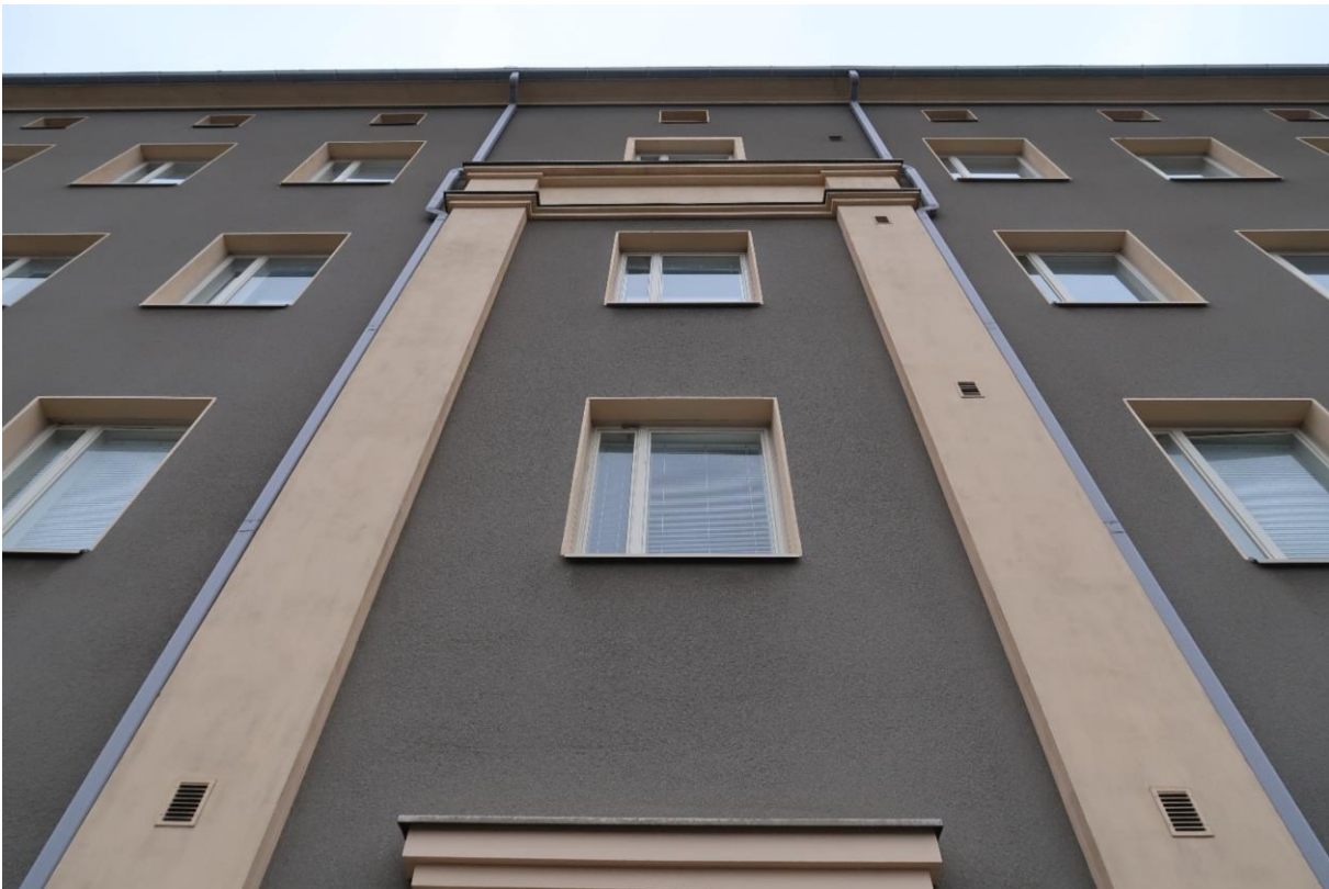
Kuva 32. Katujulkisivussa on alkuperäinen idea porttiaiheesta jäljellä. Syöksytorvet ovat alun perin olleet suoran myös "palkin" kohdalla, nyt ne tekevät mutkan.
