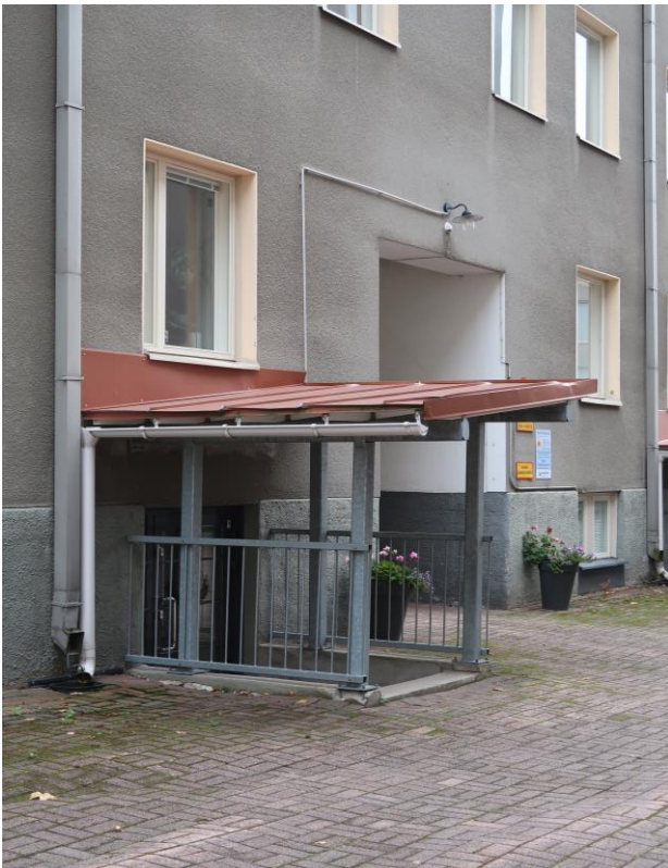
Kuva 35. Siipien välisellä sisäpihalla on kolme sisäänkäyntikatosta: saunaan ja kahteen liiketilaan. Katokset on tehty 2000-luvulla. Molempien siipien "takajulkisivun" ulko-ovet ovat teräslasiovia.
