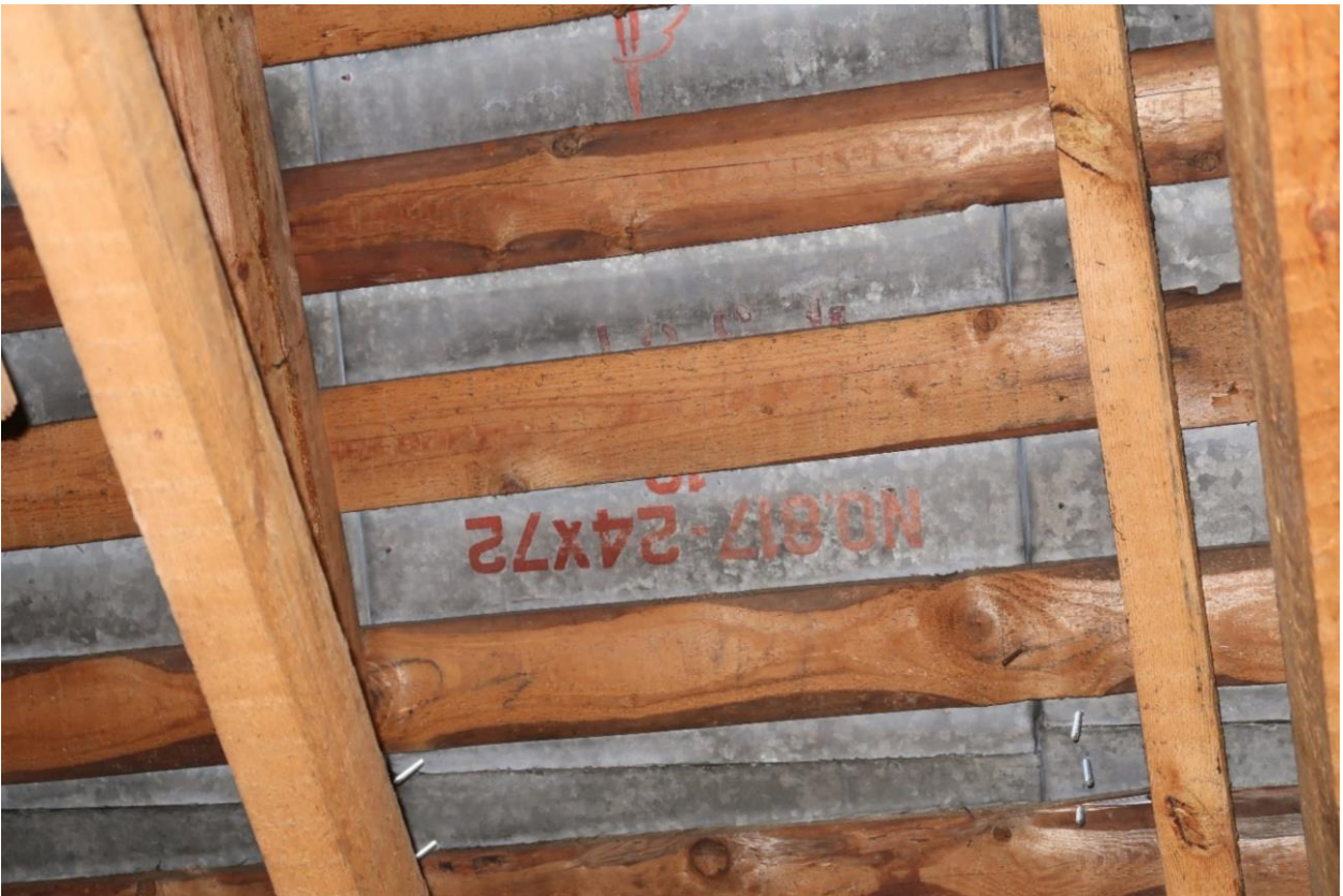
Kuva 47. Kadunvarsirakennuksen peltikate on pommituksen jälkeisestä korjauksesta ja toimii nyt tiilikatteen aluskatteena. Pelti on sinkittyä ja siinä on leimoja alapinnassa.
