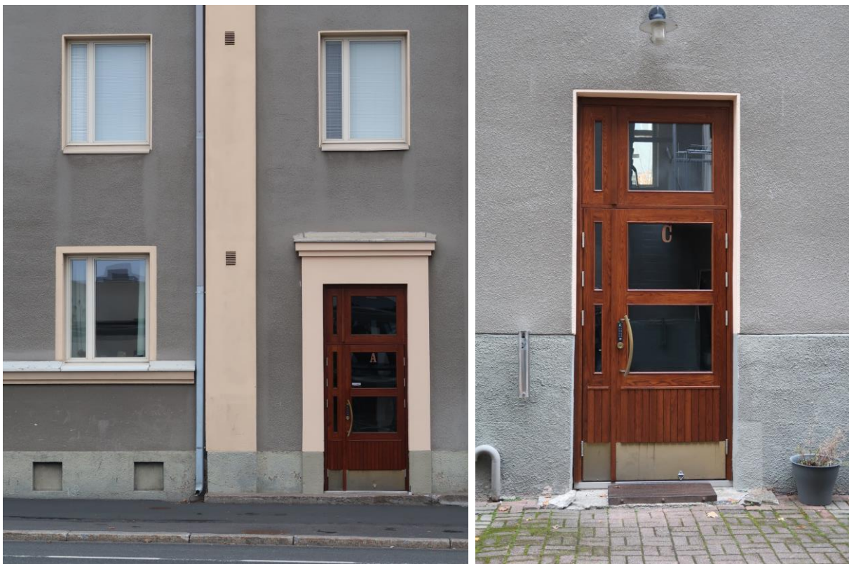
Kuva 33. Molempien siipien porrashuoneiden pääovet ovat samanlaisia puulasiovia. Katujulkisivussa ovia reunustaa vaaleaksi maalattu, rapattu kehys.
