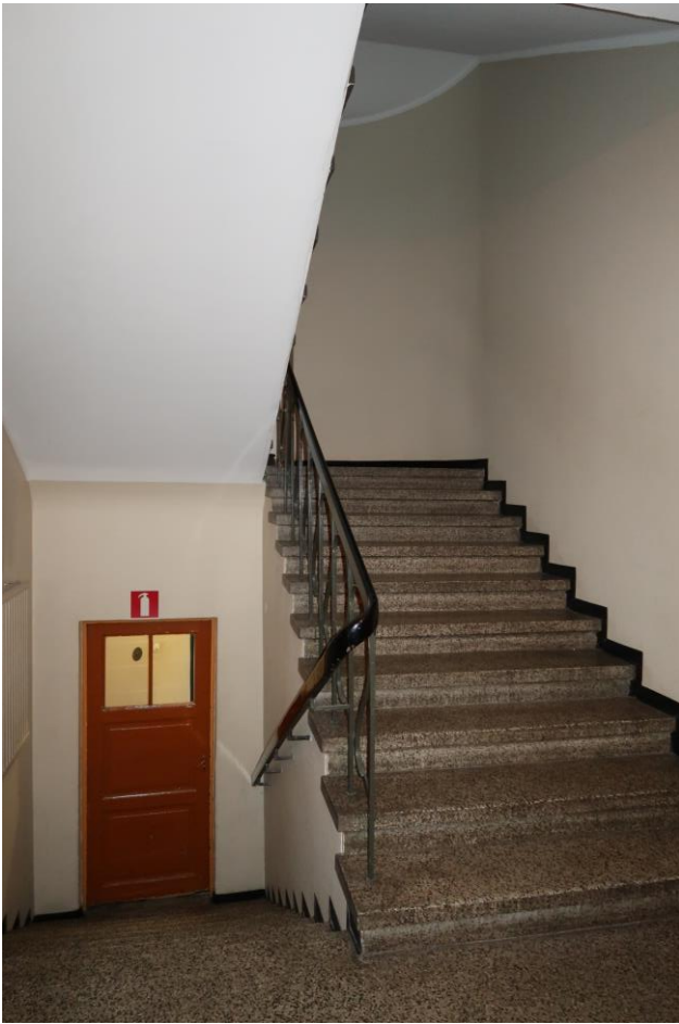
Kuva 42. Porrashuoneet ovat kaikki samanlaisia perusrakenteeltaan. Lepotasot ja porrasaskelmat mosaiikkibetonia, väliovet ovat yleensä peittomaalattuja peiliovia, joiden ylin peili on lasia. Portaan kaide on teräsrakenteinen ja koristeellinen, käsijohde on mustaksi maalattua puuta.
