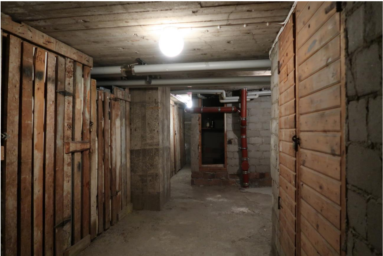
Kuva 37. Kellaritilat ovat kohtuullisen alkuperäisessä asussa, mutta talotekniikka-asennuksia on runsaasti.
