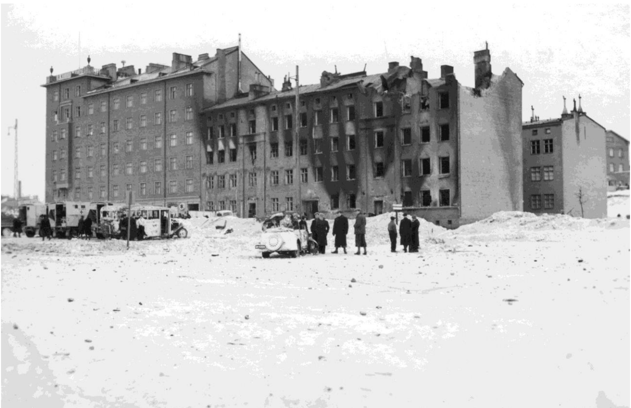
Kuva 13. Pommituksen tuhoja As Oy Sorinmäessä. Kuvajaaja Bertel Strömmer 2.3.1940. Vapriikin kuva-arkisto. CC BY 4.0
