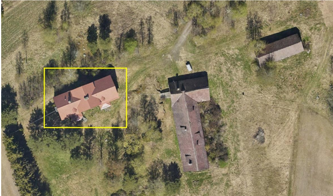
Kuva 61: Ilmakuva vuodelta 2022. Nattarin päärakennus on kuvassa vasemmalla. Ilmakuvasta erottuvat etelänpuoleiset kuistit ja kattolyhdyt sekä keskellä rakennusta sijaitsevat poikkipäädyt. Lähde: Tampere, Oskari
