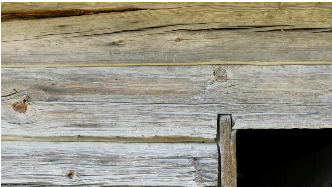
Kuva 49 Otsa-aitan seinässä pystyviivoin hirteen kaiverrettuja siirtomerkkejä.
