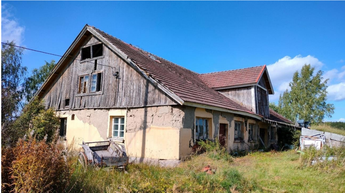
Kuva 37 Navetta kuvattuna kaakosta. Itäjulkisivulla on poikkipääty, jossa on sisäänkäynti ylisille. Sisäänkäynnille johtaa silta ja harkkoperustainen ajoliuska.
