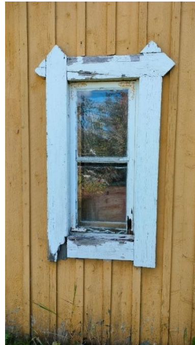
Kuva 57 Vuorilautojen päät on viistetty ja ne risteävät toisiinsa.
