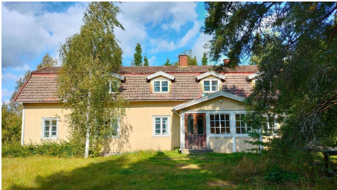
Kuva 20 Kovapään päärakennuksen eteläjulkisivu.
