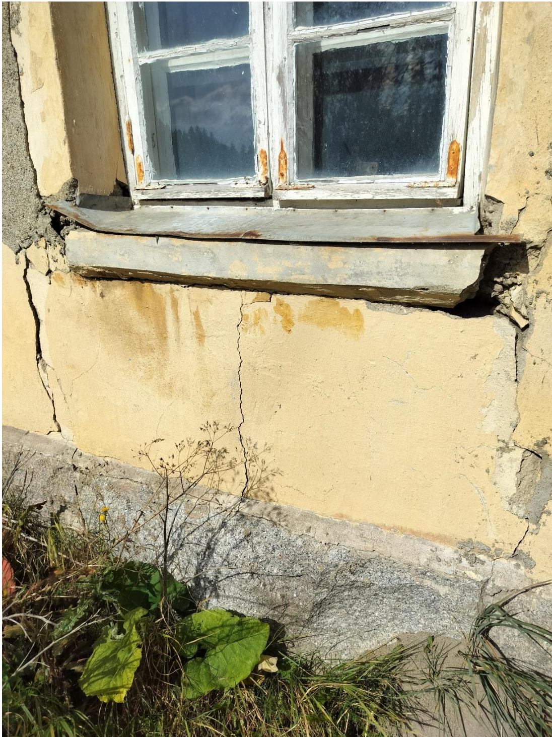
Kuva 41 Yksityiskohtakuva navetan ikkunasta ja perustuksista. Ikkunalauta on samaa savi-kanervaseosta ulkoseinän kanssa. Ikkunoiden puupuitteiden nurkissa on perinteisen malliset kulmaraudat. Ikkunalaudan päällä on pelti. Perustuksena on harmaat porakiviharkot.
