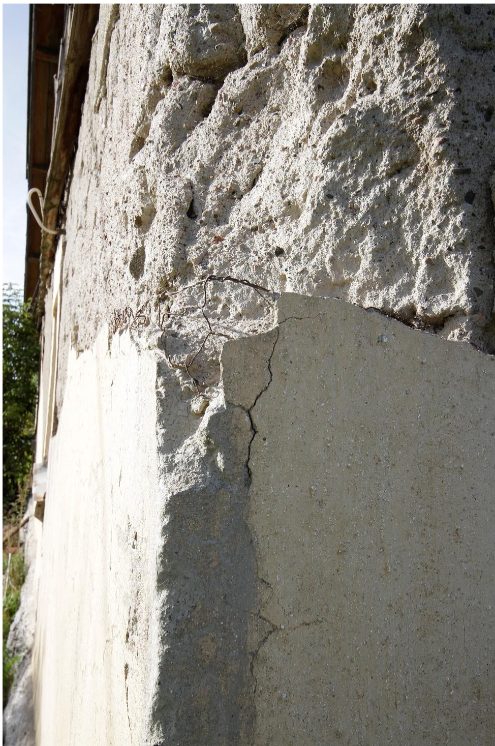
Kuva 42 Kovapään navetan rappauksessa on käytetty "kanaverkkoa".
