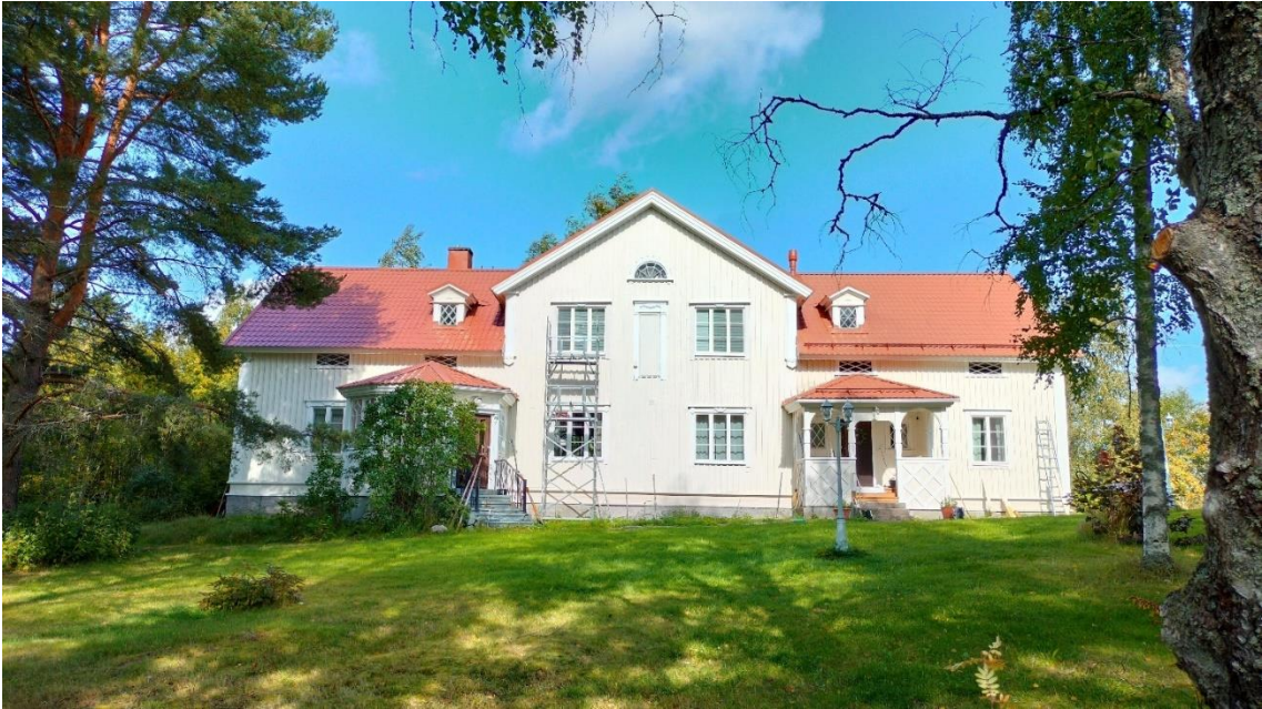
Kuva 63 Nattarin päärakennuksen kaakkoisjulkisivu. Inventoinnin maastokäynnin aikaan kohteessa oli käynnissä julkisivun ja ikkunoiden kunnostustyöt, ja pihapiirissä oli pystyssä useita rakennustelineitä.
