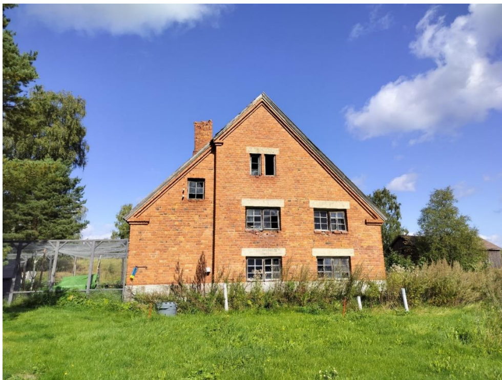
Kuva 72 Navetan eteläpääty. Räystäät kääntyvät kissanpenkeiksi eteläpäädyssä.
