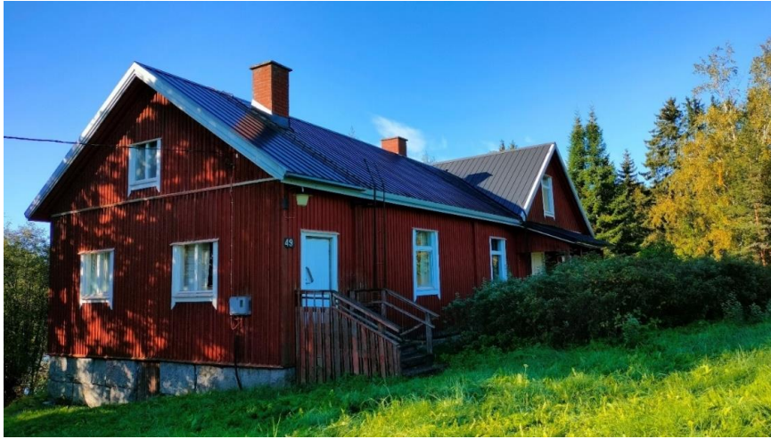
Kuva 7: Työväentalon pääjulkisivu koillisesta kuvattuna.
