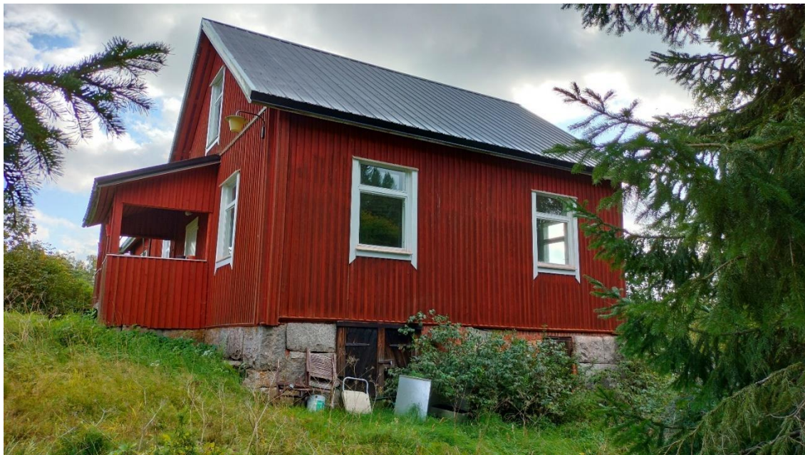
Kuva 13 Entisen työväentalon länsijulkisivu.
