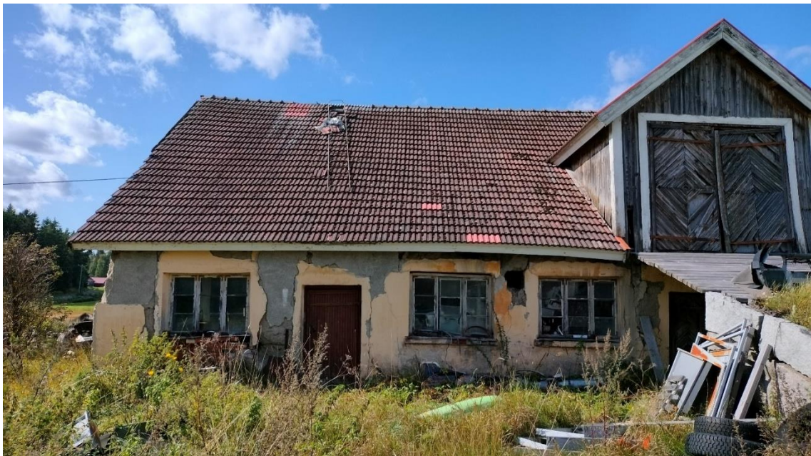
Kuva 38 Kovapään navetan itäjulkisivua. Itäjulkisivulla on poikkipääty, jossa on sisäänkäynti ylisille. Sisäänkäynnille johtaa silta ja harkkoperustainen ajoliuska.
