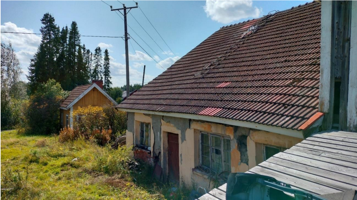
Kuva 39 Navetan itäistä julkisivua ylisille johtavalta ajoliuskalta kuvattuna. Taustalla Kovapään saunamökki.
