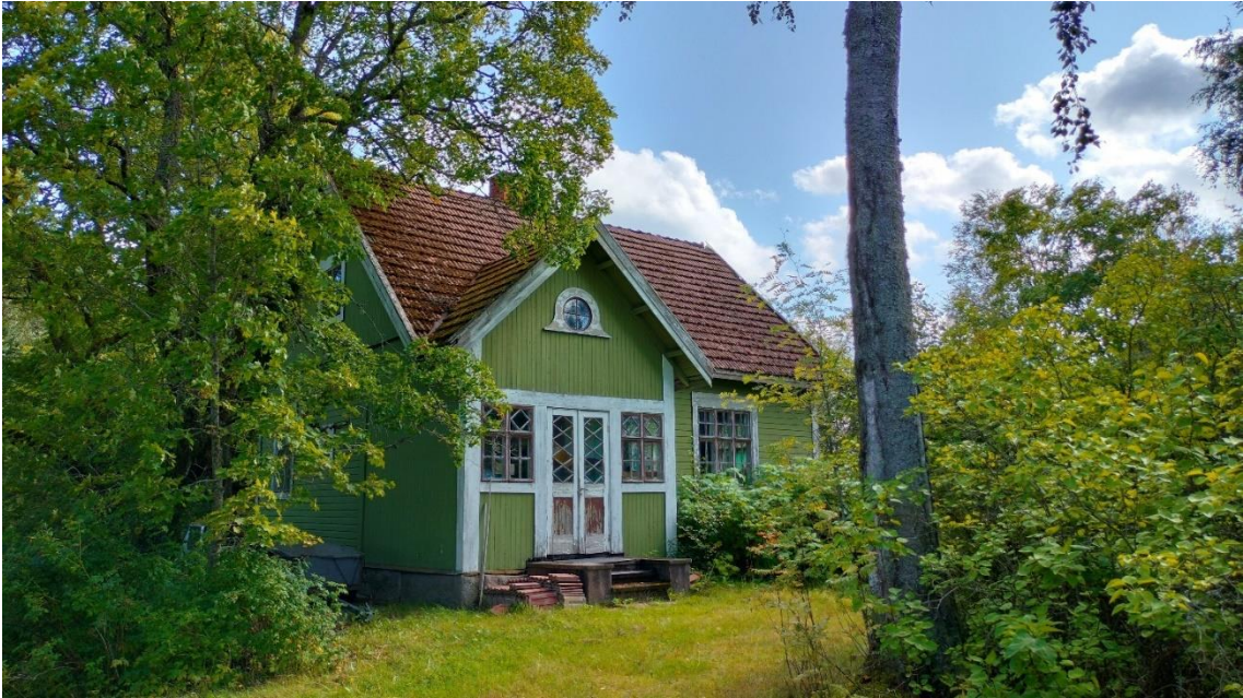
Kuva 25 Vuonna 1917 valmistuneen rakennuksen länsijulkisivu. Sisäänkäynnin yllä kuistilla on kaunis häränsilmäikkuna kaarevin kehyksin.
