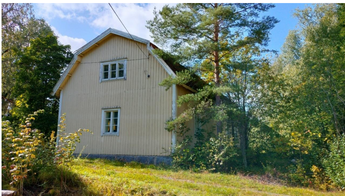
Kuva 23 Päärakennuksen itäpääty. Yläkerran päädyssä ikkunamalli 2.
