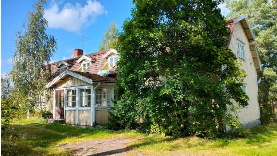
Kuva 17 Kovapään päärakennus kaakosta.
