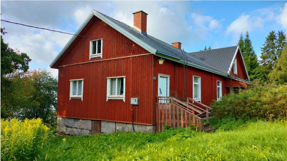
Kuva 11 Työväentalo koillisesta kuvattuna. Työväentaloa on laajennettu vuonna 1956 itään eteisen ja varastohuoneen leveyden verran. Niiden paikalla oli aiemmin umpikuisti, jonka kivijalkaa on hyödynnetty laajennuksessa. Kuisti oli yksikerroksinen, lapekattoinen ja sen pohjoisseinustalla oli pariovi.
