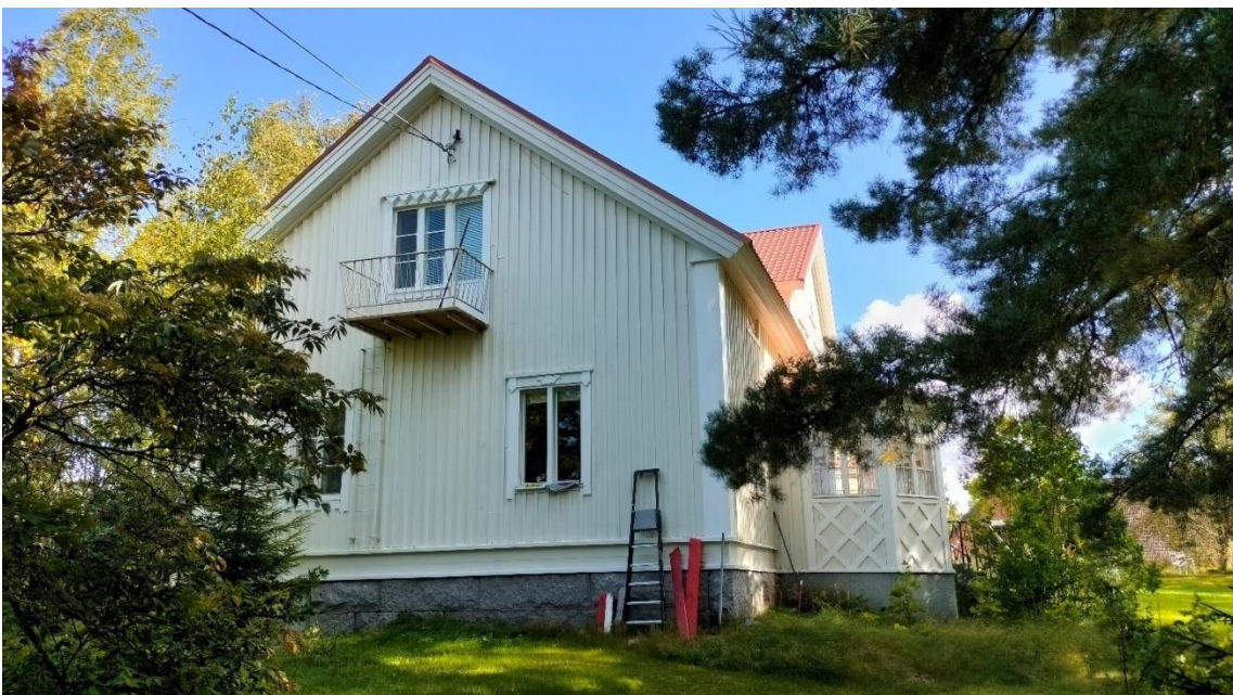
Kuva 64 Nattarin päärakennuksen lounaisjulkisivu. 1920-luvun klassismille tyypilliseen tapaan nurkkia on korostettu pilasteriaiheella. Rakennuksen ulkuvorauksen alareunan vaakasuunteinen helmalaudoitus listoineen muodostaa ikään kuin jalustan, jolta leveiden nurkkalautojen muodostamat pilasterit nousevat. Räystäiden alla oleva koristelista kääntyy myös päätyjulkisivuille muodostaen pilastereille kapiteelin.
