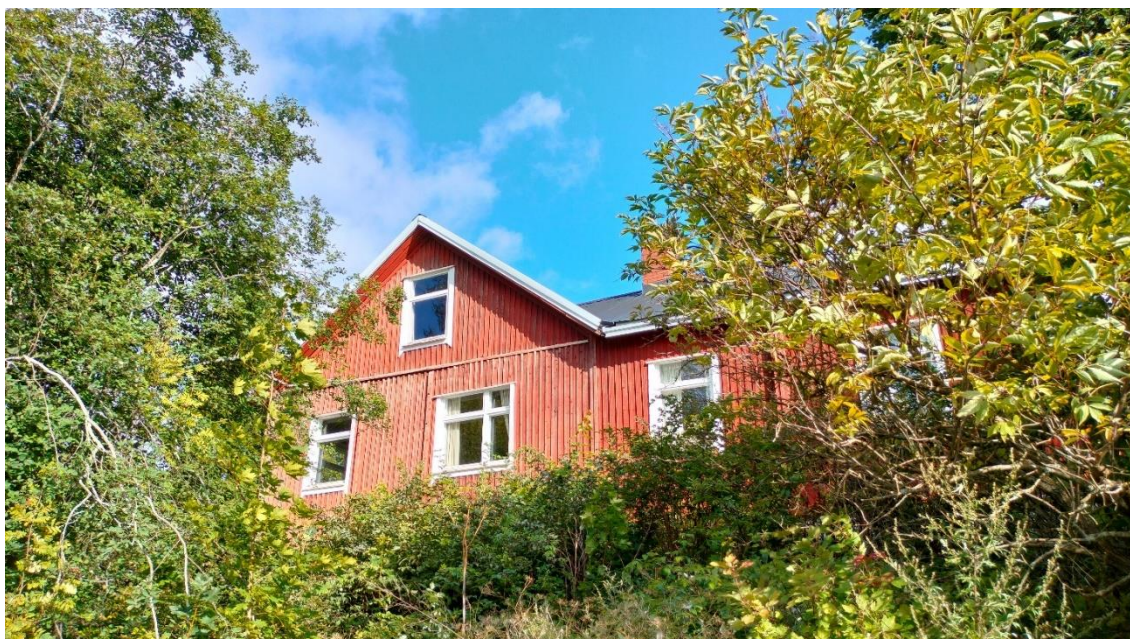
Kuva 14 Entisen työväentalon eteläistä julkisivua.
