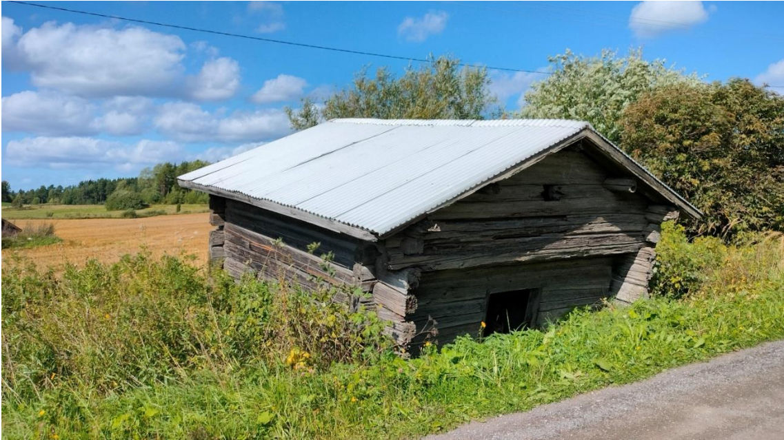
Kuva 44 Kovapään otsa-aitta kuvattuna Nurmintieltä etelästä. Tien levennyksen ja korostusten jälkeen aitta on jäänyt aivan tien reunaan kiinni ja tien pintaan nähden syvälle.
