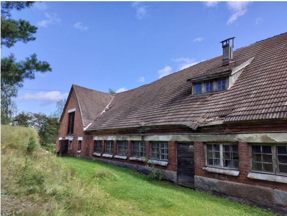
Kuva 71 Navetan länsijulkisivu. Ikkunoiden yläosa on holvattu näyttävällä betonipalkilla.
