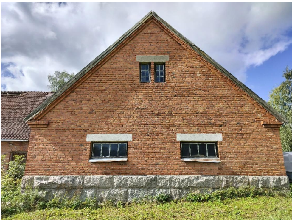
Kuva 73 Itäinen poikkipääty. Räystäällä on tiilestä muuratut kissanpenkit.
