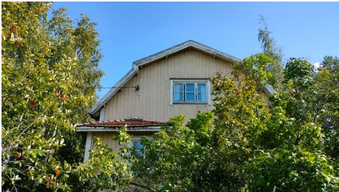
Kuva 22 Päärakennuksen länsipääty. Yläkerran päädyssä ikkunamalli 2.
