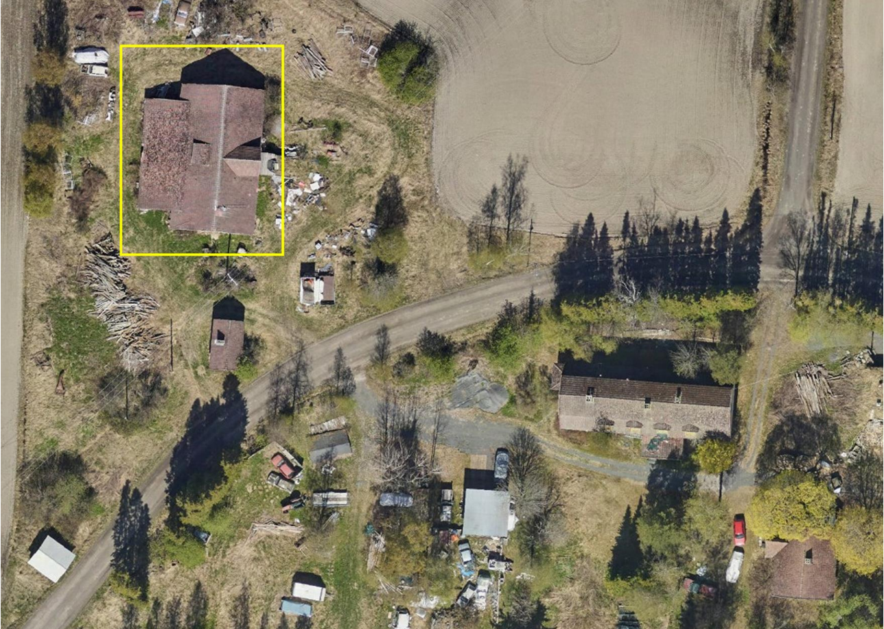
Kuva 36 Ilmakuva vuodelta 2022. Kovapään navetta sijaitsee Nurmintien pohjoispuolella. Navetan suuri koko hahmottuu hyvin ilmakuvesta. Lähde: Tampere, Oskari.
