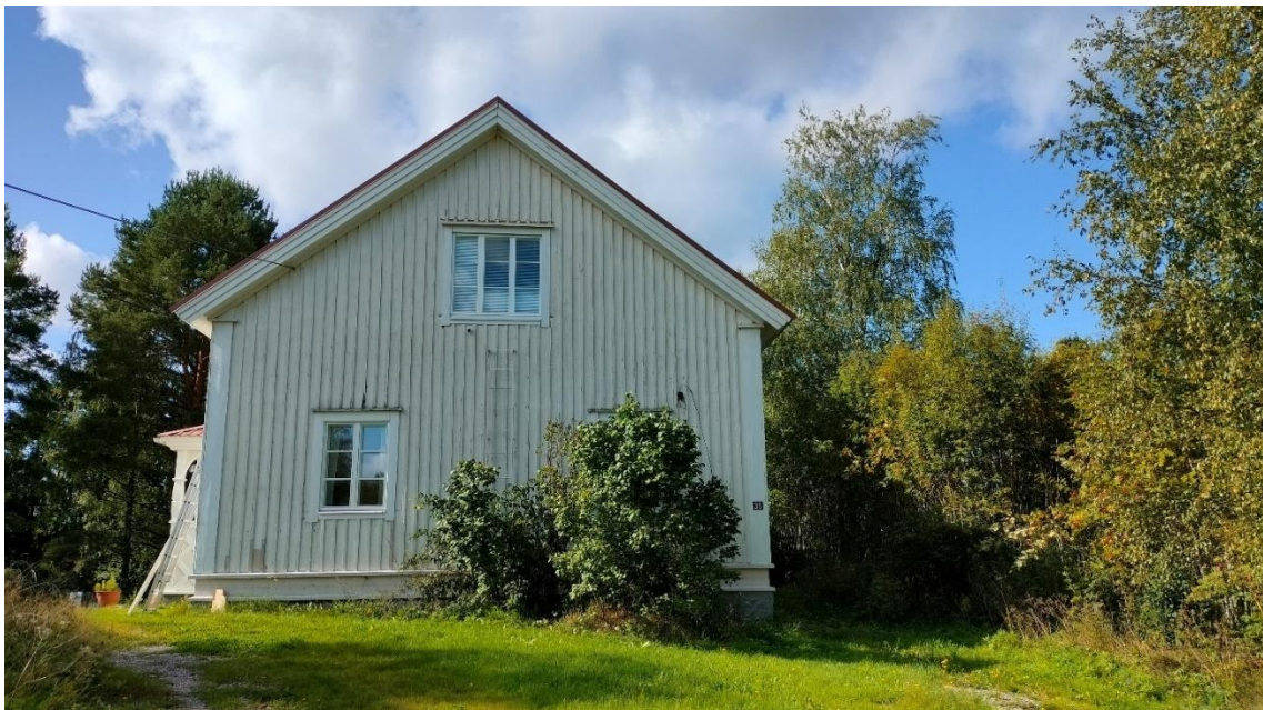
Kuva 66 Päärakennuksen koillispääty. Pädyn ikkunat ovat vanhan mallin mukaan uusittuja alumiini-ikkunoita.
