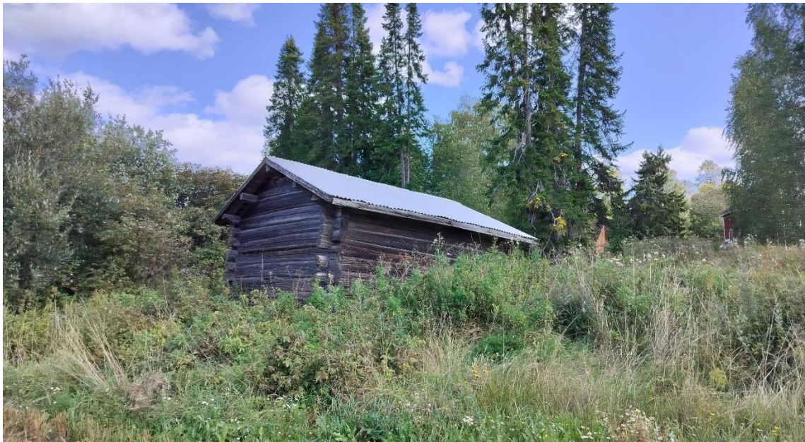
Kuva 47 Otsa-aitta lännestä pellon puolelta.
