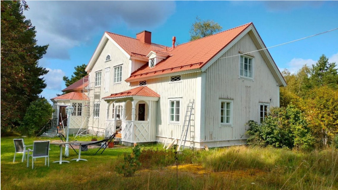
Kuva 67 Päärakennus idästä, pihapiirissä olevan maakellarin katolta kuvattuna.
