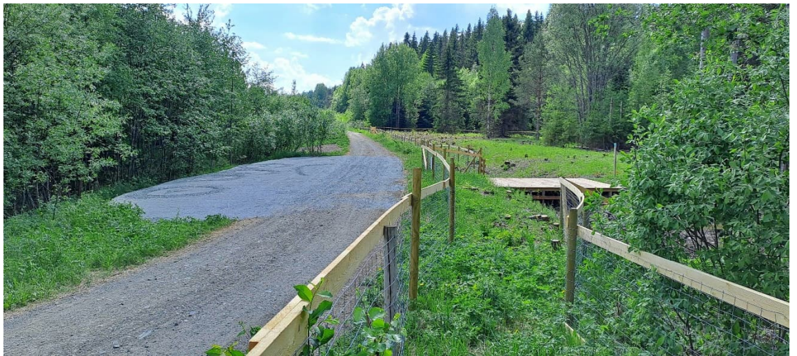
Kuva 6. Laitumen osien välistä yhteyskäytävää, siltatasanne ja huoltolevike.
