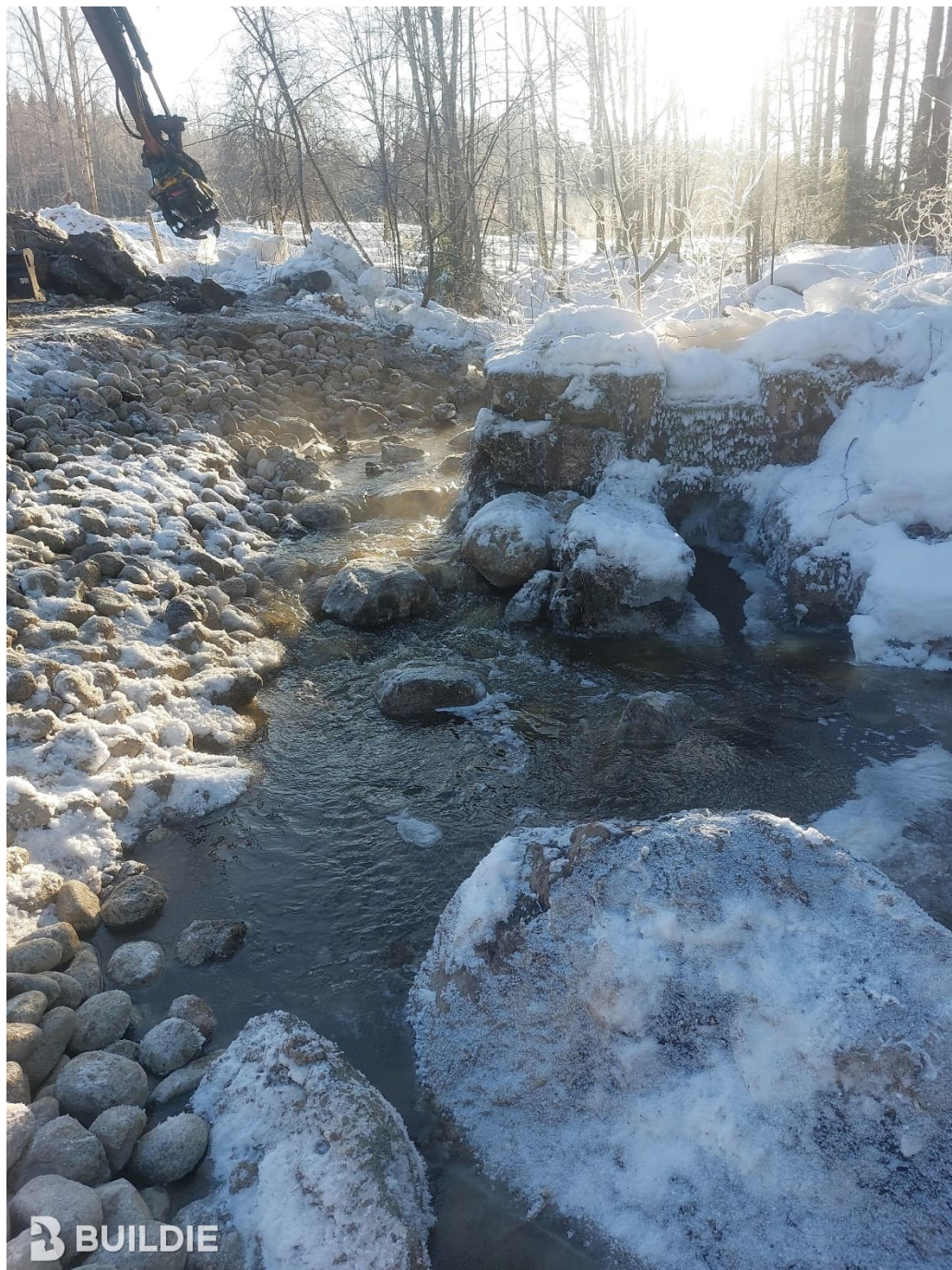
Kuva 14. Kunnostustyöt käynnissä Pärrinkoskella maaliskuussa 2024.
