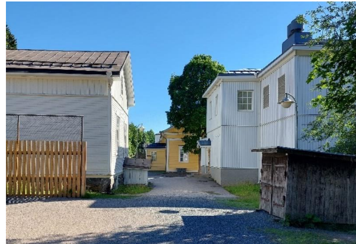
Kuva 76. Näkymä koulun hiekkapintaiselta pallokentältä sisäpihalle.
