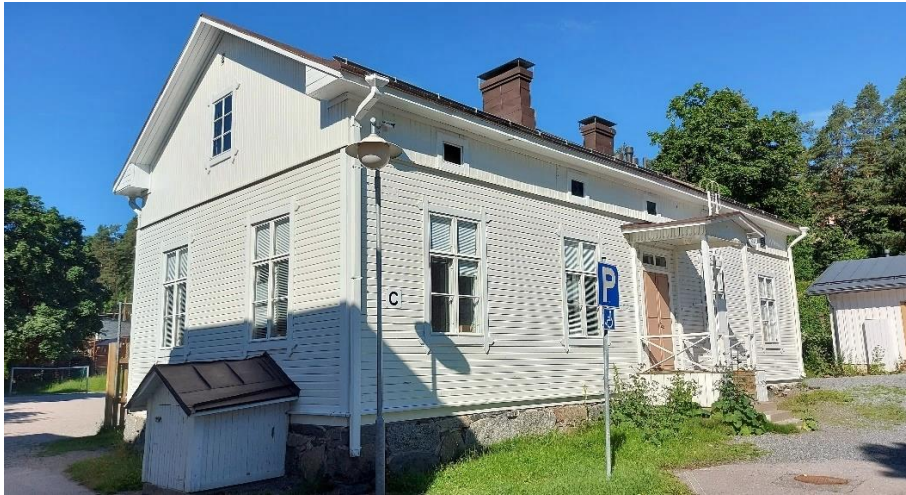
Kuva 70. Vuonna 1864 valmistuneet luokkahuone ja pitkämatkaisten oppilaiden asunnon sisältänyt koulurakennus.
