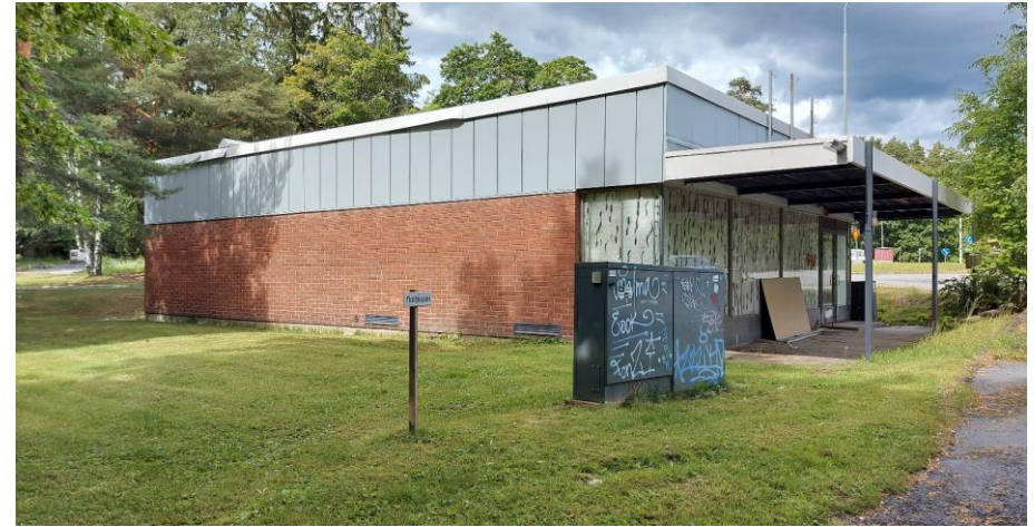
Kuva 45. Sisääntuloaukion vanhalla liikehuoneistolla ei ole nykytilassa toiminnallista merkitystä asuinalueen kannalta.
