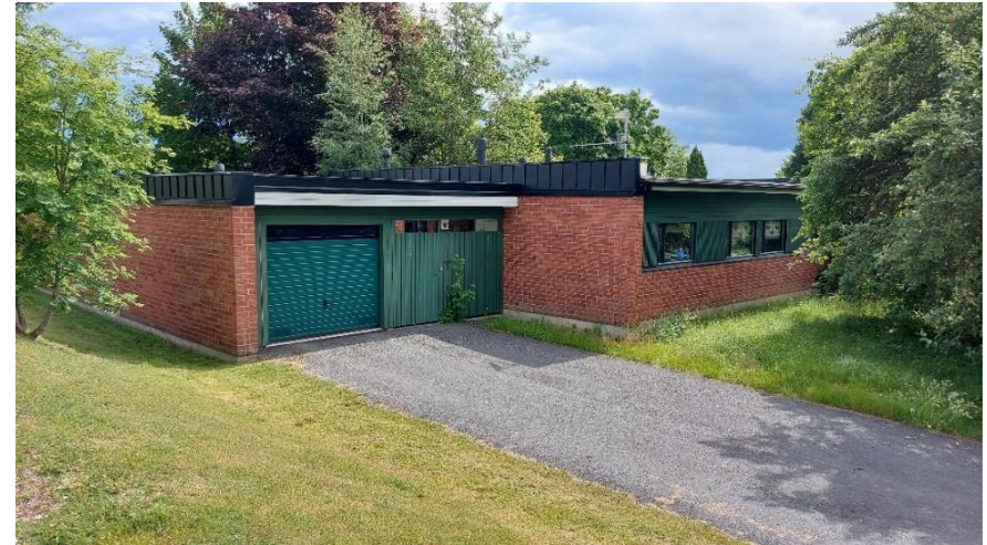
Kuva 56. Muutamissa atriumtaloissa oli kokonaisuudesta poikkeava julkisivuväriyty.
