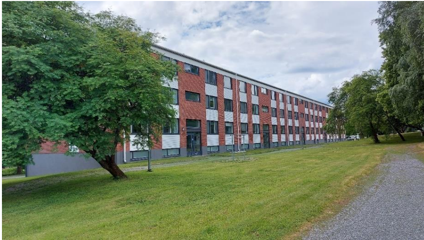
Kuva 50. Lamellitalojen pisin rakennus.
