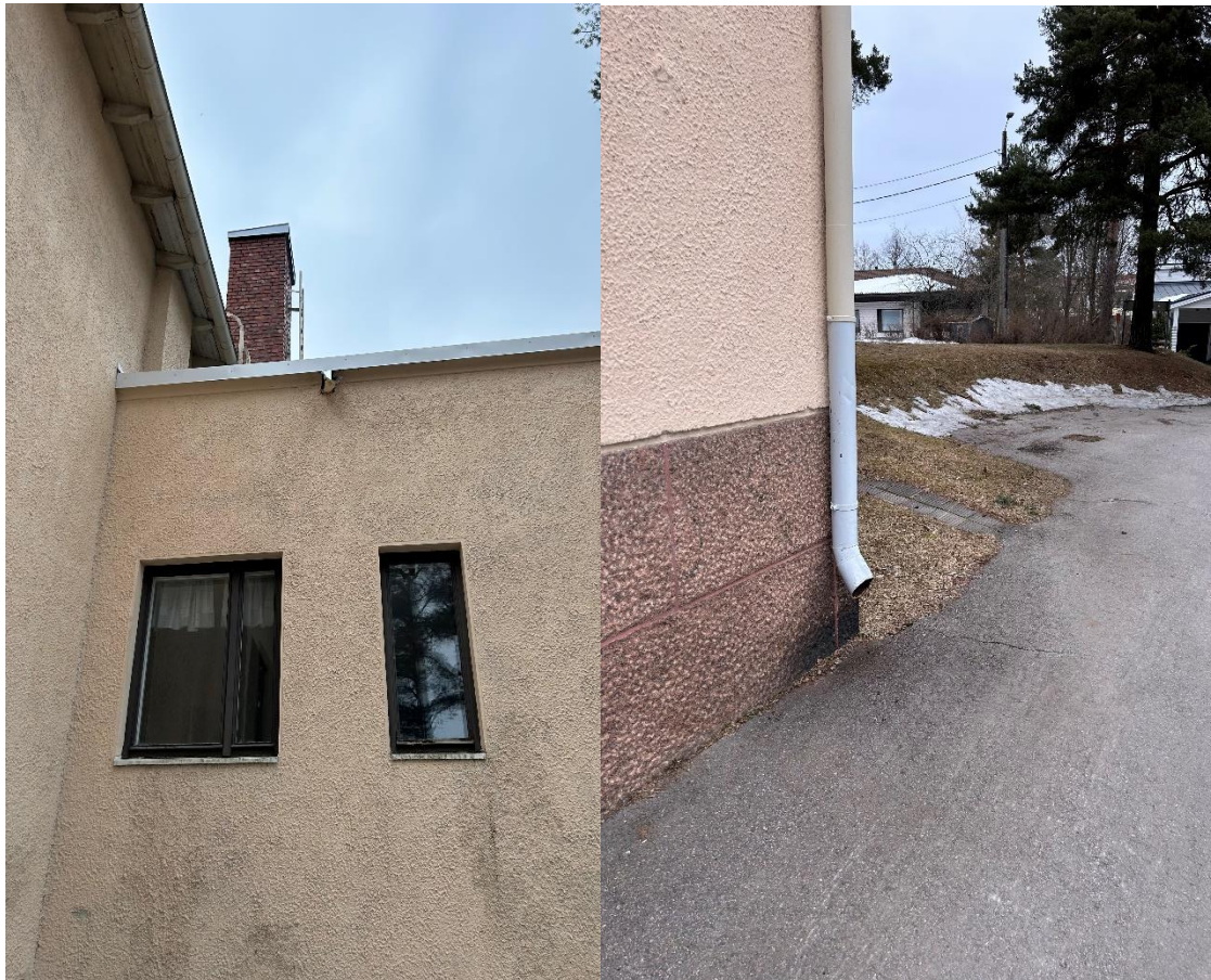
Kuva 13 & 14. Seurakuntatalon kattokuivatuslinja sekä syöksyputki rakennuksen itäpäässä. Syöksyputkista vedet valuvat vapaasti rutiläkaivoa kohti. Kuvassa 13 seurakuntatalon tasakattoisella osalla on ulkoinen vedenpoisto ilman syöksytorvea. Vesi purkautuu rakennuksen seinustalle. Jatkossa vesi on mahdollista kerätä hallitusti rännikourulla ja syöksytorvella. (Lähde: Ramboll Finland Oy)
