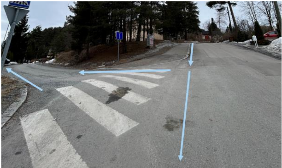
Kuva 6. Suunnittelualueen sijainti Kappelinkadun ja Suurmäenkadun risteyksessä. Nykyiset tulvareitit on esitetty vaaleansinisillä nuolilla. (Lähde: Ramboll Finland Oy)
