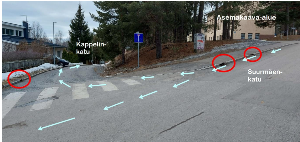
Kuva 7. Suunnittelualueen sijainti Kappelinkadun ja Suurmäenkadun risteyksessä. Nykyiset tulvareitit on esitetty vaaleansinisillä nuolilla ja kitakaivot korostettu punaisilla ympyröillä. (Lähde: Ramboll Finland Oy)
