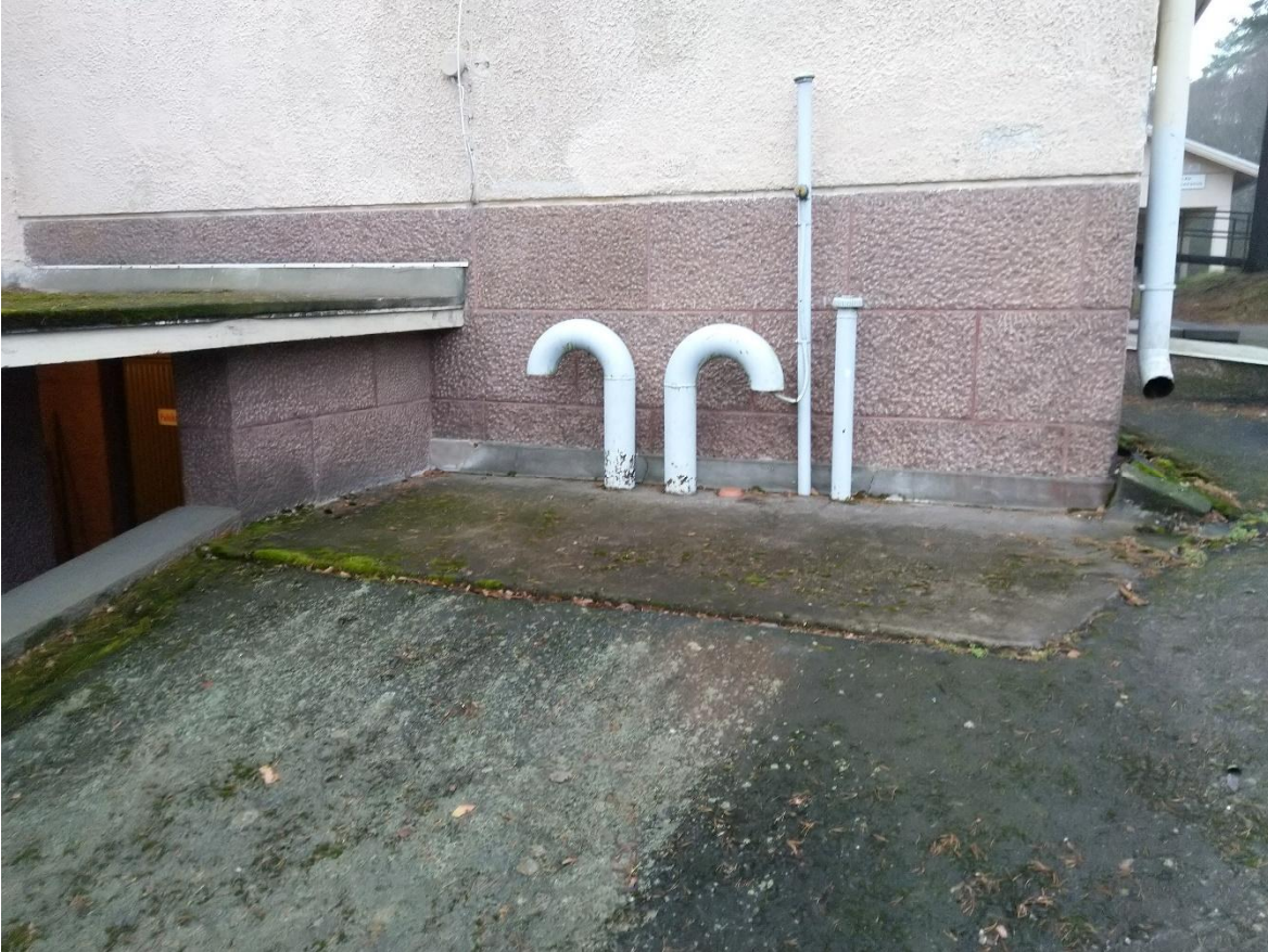
Kuva 07 Öljysäiliön putkia.
