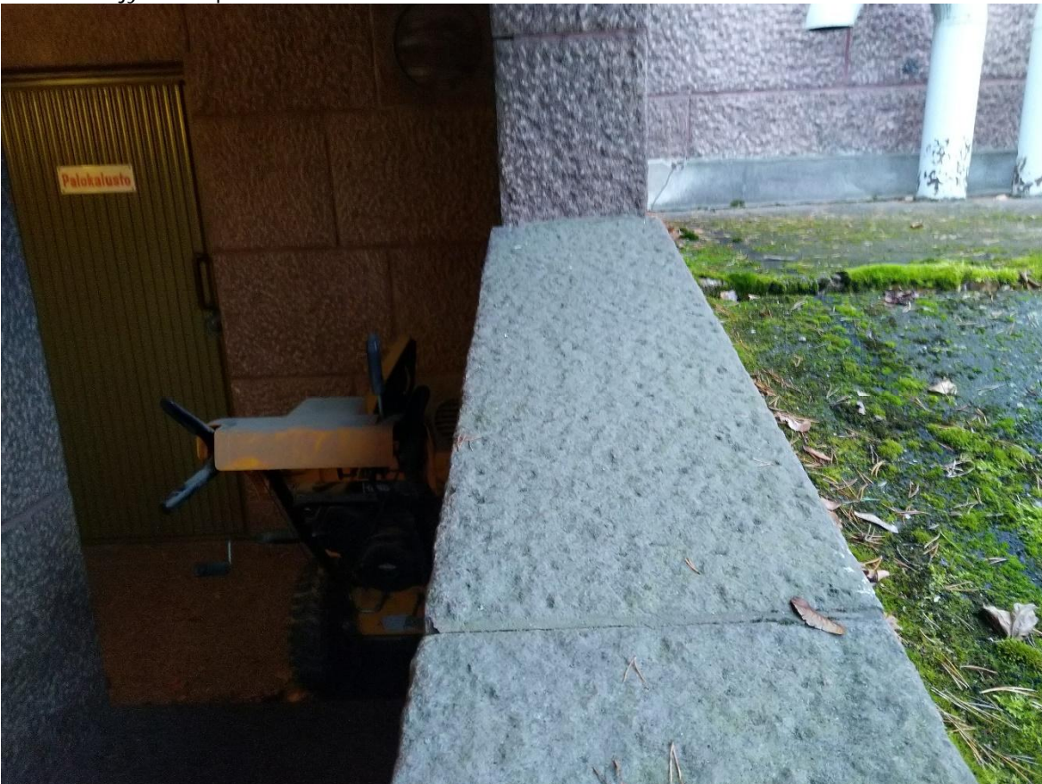
Kuva 08 Näkymä kellaritilojen sisäänkäynnille.
