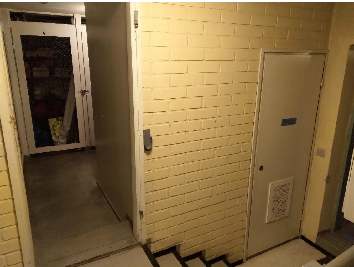
Kuva 10 Näkymä kellaritilojen sisäänkäynnille sisäpuolelta. Häkkivarasto jatkuu kuvasta katsoen oikealle ulkoseinään asti.
