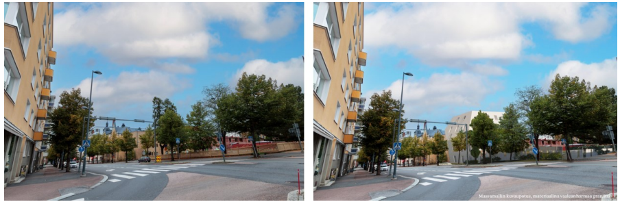
Kuvaparissa näkymä Satamakadun ja Mariankadun kulmasta kohti kaava-aluetta, nykytilanne vasemmalla ja oikealla viitesuunnitelman mukainen uudisrakennus ja koulun piha. Lunden Architecture Company 2024.
