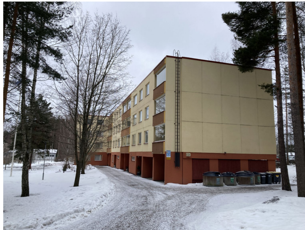
5: Matala korotuspotentiaalia omaava rakennus tontilla 9
