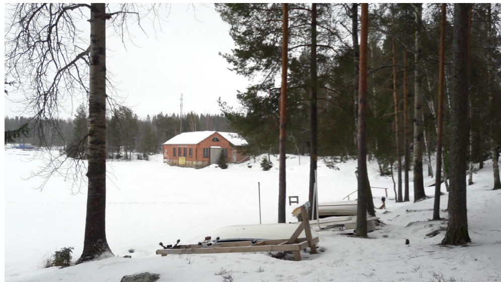
Vanha punatiilinen pumppaamo on kaunis maamerkkirakennus itäisen rantapolun varrella.
